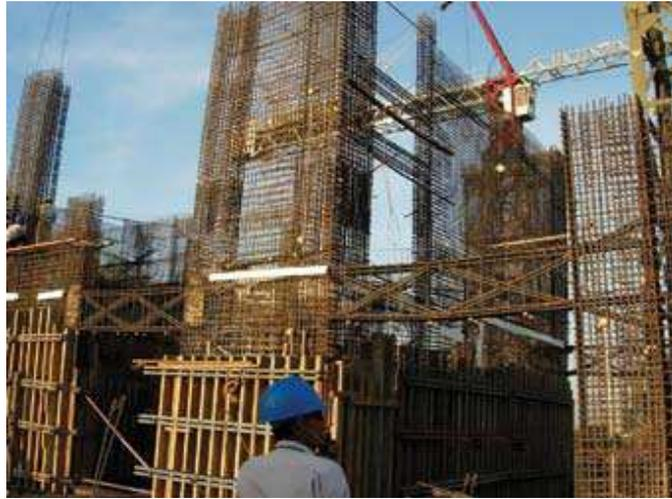
**Fig.3.7: Ejecución en obra de viga de acople típica en la Torre Satrio [4].**
