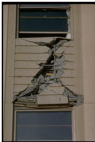
**Fig. 2.7: Edificio Mount McKinley, falla diagonal en dintel [7].**
