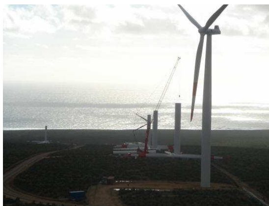
Ilustración 14. Montaje Parque eólico Canela fuente: www.pnud.cl
