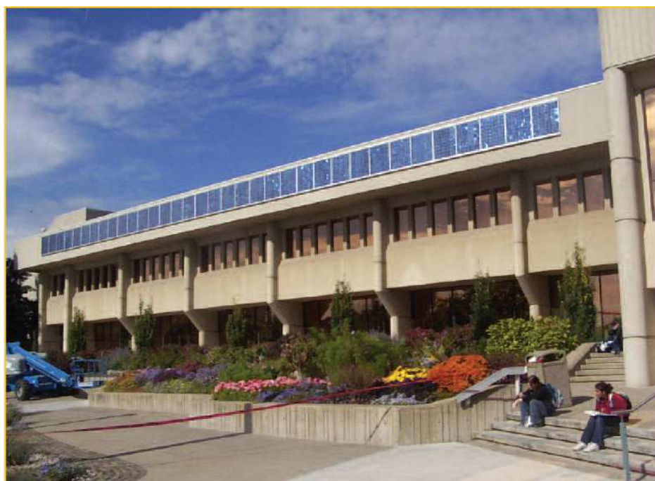
Ilustración 14. Sistema Fotovoltaico de 5 kW en Universidad de Toronto, Canadá
