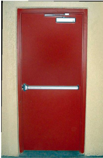
FIG. 5-20: PUERTA DE EVACUACION TIPO, CON CIERRE AUTOMÁTICO Y BARRA ANTIPÁNICO
