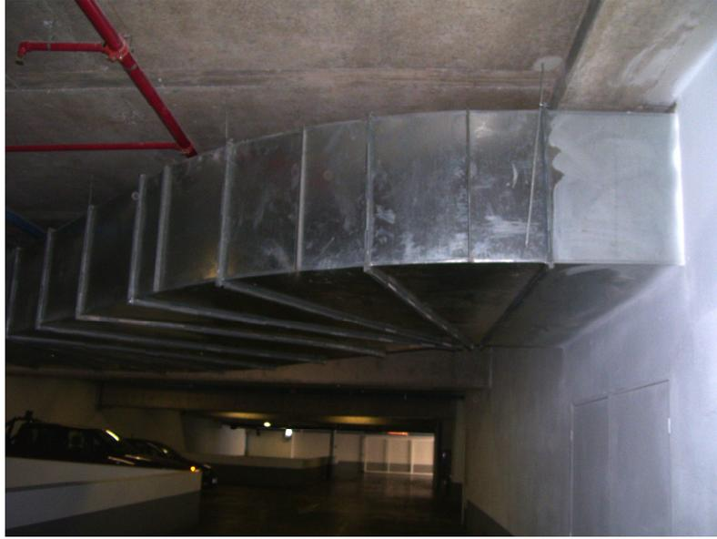
FIG. 5-14: DUCTO DE AIRE
