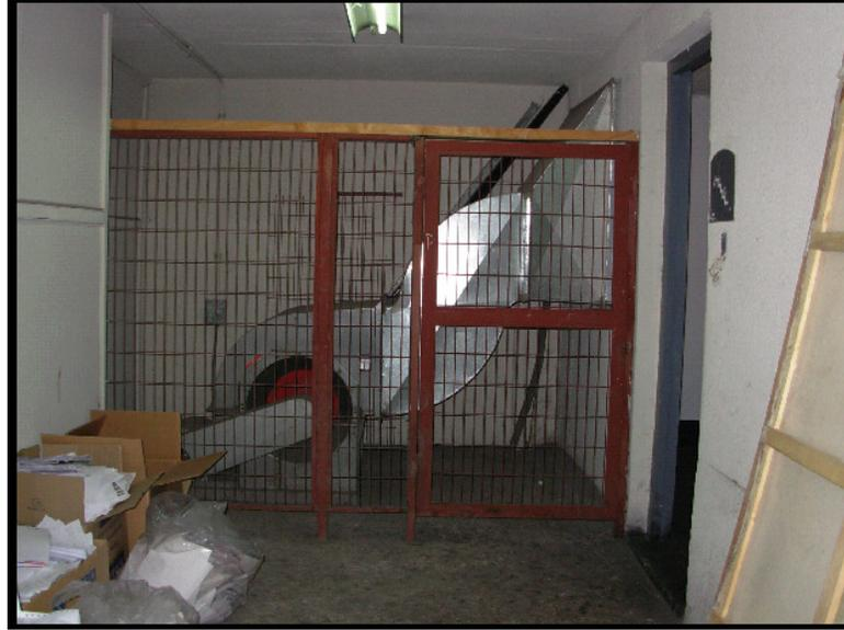
FIG. 5-19: UBICACIÓN DE VENTILADOR POCO SEGURA
