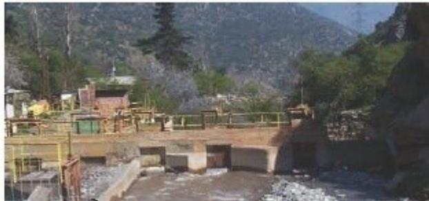
Fig. 4.10: Instalaciones de La Ermita, compuertas de bocatoma.
