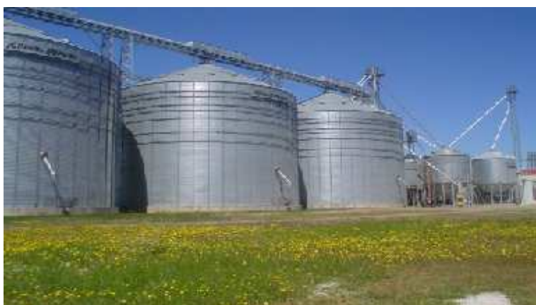
Figura 3.3: Silos para almacenaje en atmósfera normal
