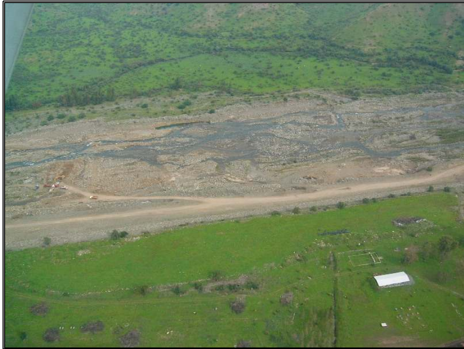
Foto N°3: Tramo Aguas Abajo del Badén Peldehue, Julio 2005
