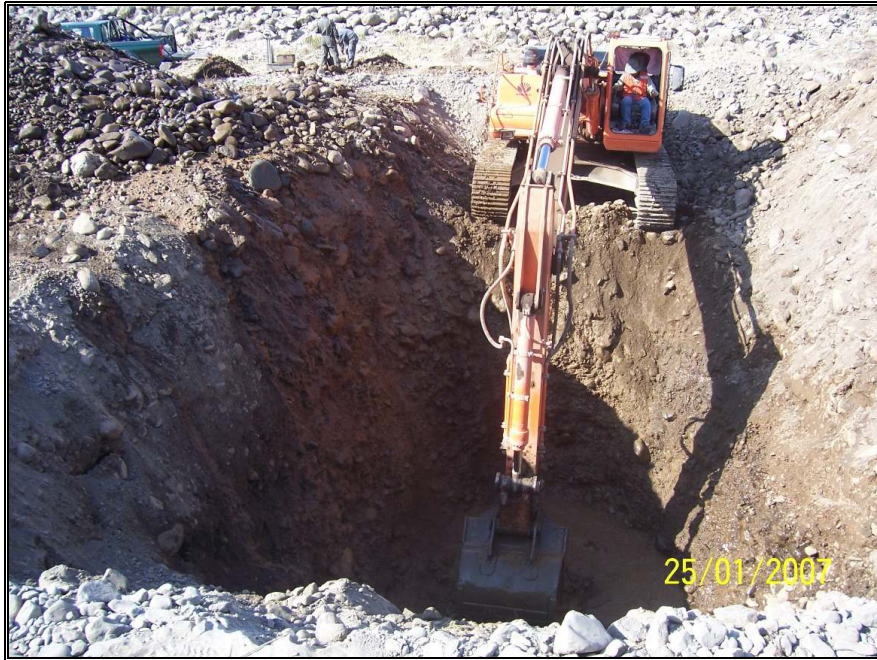
Foto N°13: Calicatas DICTUC, Proyecto Cruce Aéreo Canal Colina
