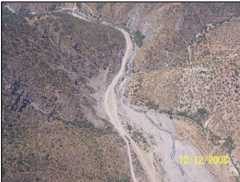
Foto N°10: Sector Bocatoma Canal Colina - Ensanchamiento Cauce
