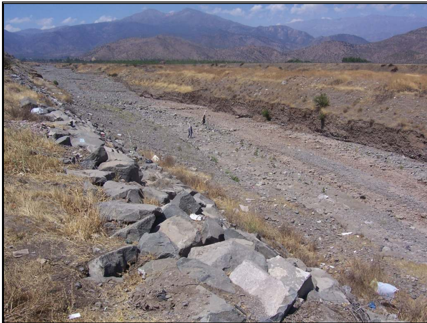
Foto N°2: Vista Aguas Arriba Puente San Luis
