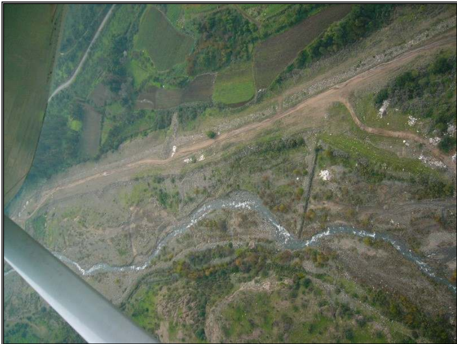
Foto N°6: Descalce del Sifón Peldehue, Julio 2005
