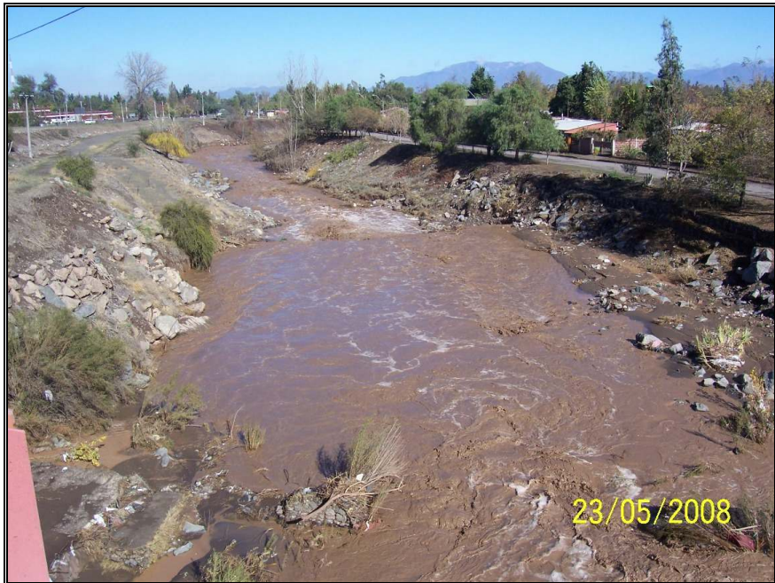
Foto N°2: Vista Aguas Abajo Puente Colina
