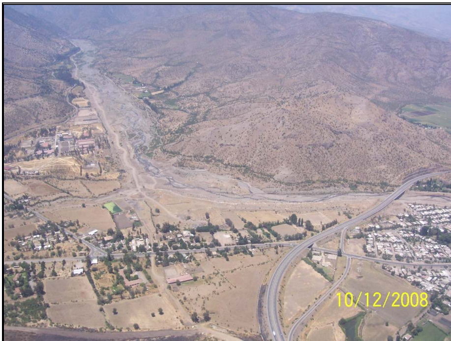
Foto N°14: Tramo Aguas Arriba Puente Esmeralda
