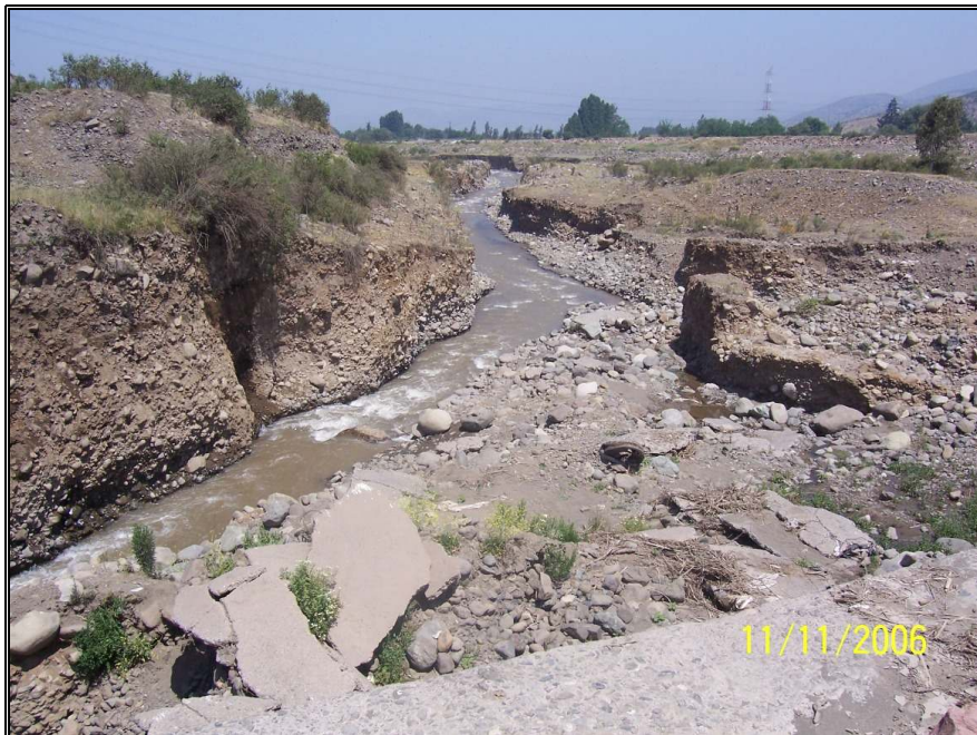
Foto N°10: Estado del Cauce Aguas Abajo del Sifón El Molino
