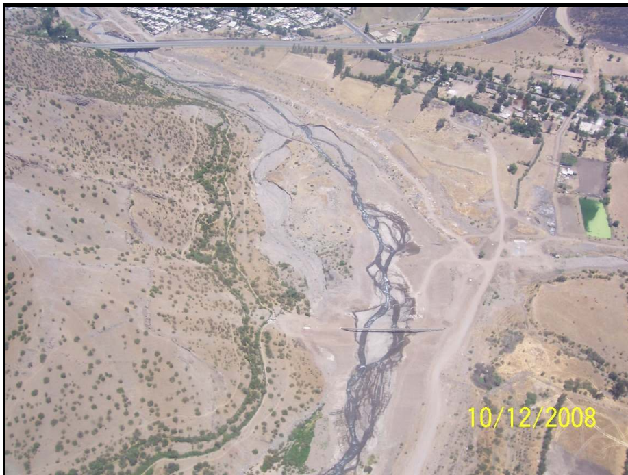
Foto N°12: Vista Cruce Aéreo Canal Colina
