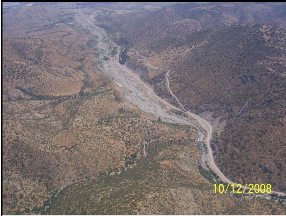
Foto N°11: Vista Desde Aguas Arriba Bocatoma Canal Colina
