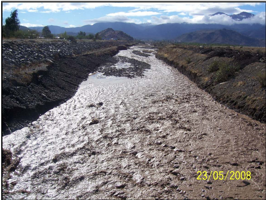
Foto N°4: Vista Aguas Arriba Puente San Luis
