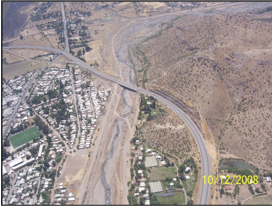
Foto N°13: Inmediaciones Puente Esmeralda
