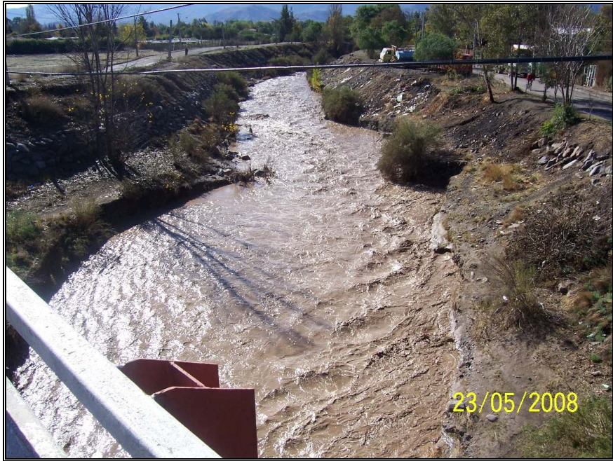
Foto N°1: Vista Aguas Arriba Puente Colina
