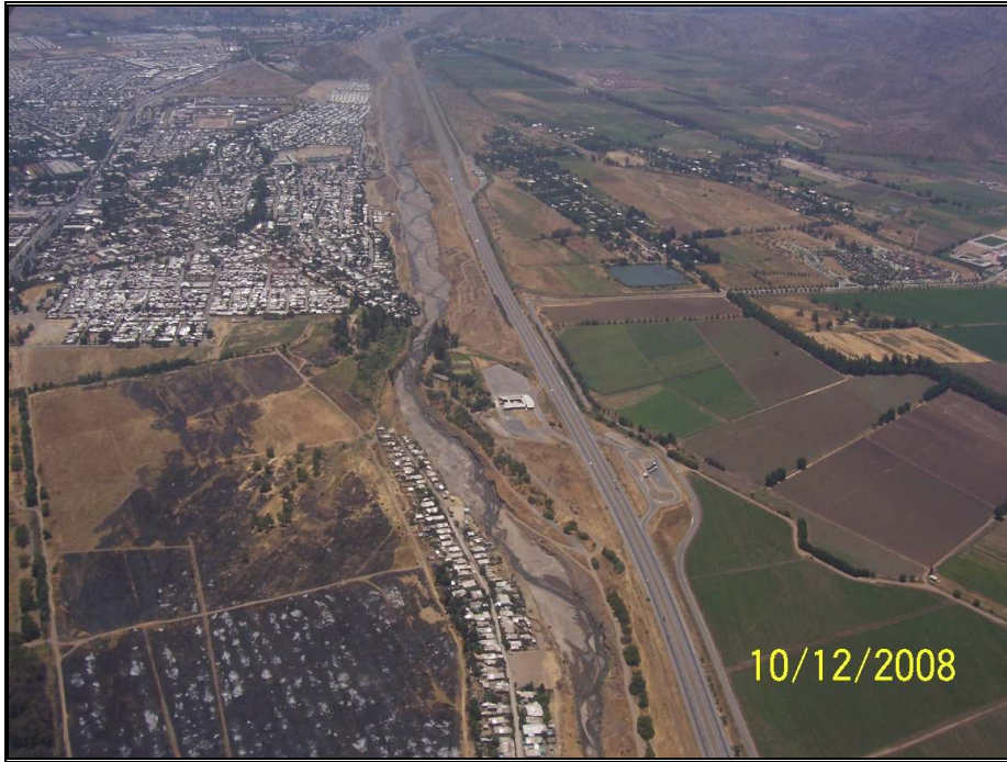
Foto N°15: Tramo Aguas Arriba Puente Colina
