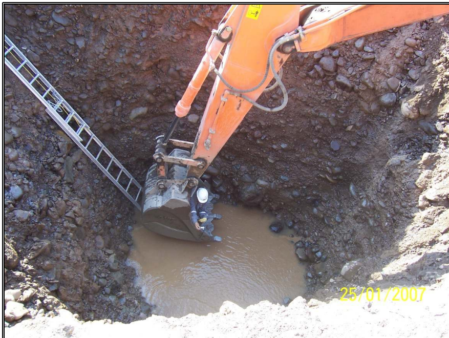
Foto N°14: Ingeniero del DICTUC Caracterizando Calicata
