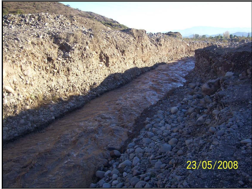
Foto N°13: Socavón Aguas Abajo Sifón El Molino
