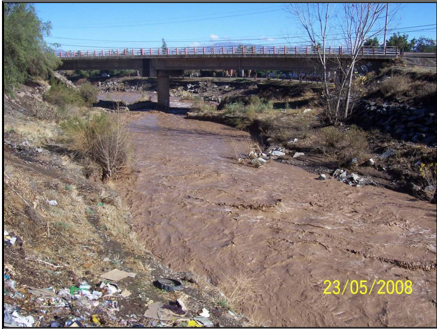
Foto N°3: Puente Colina, Desde Aguas Arriba
