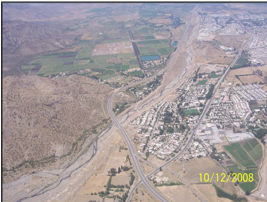
Foto N°6: Vista Sobre Puente Esmeralda
