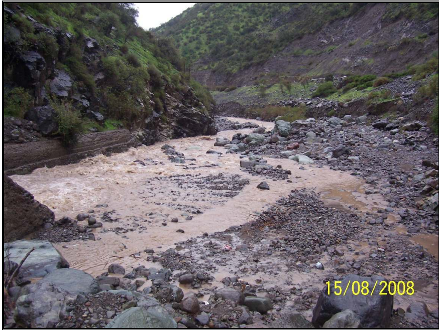
Foto N°3: Vista Aguas Abajo Bocatoma Canal Colina
