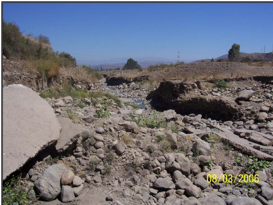
Foto N°6: Vista Aguas Abajo Sifón El Molino
