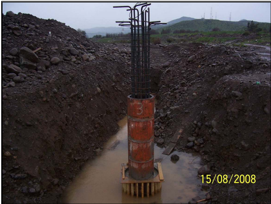
Foto N°6: Detalle Columna Cruce Aéreo Canal Colina
