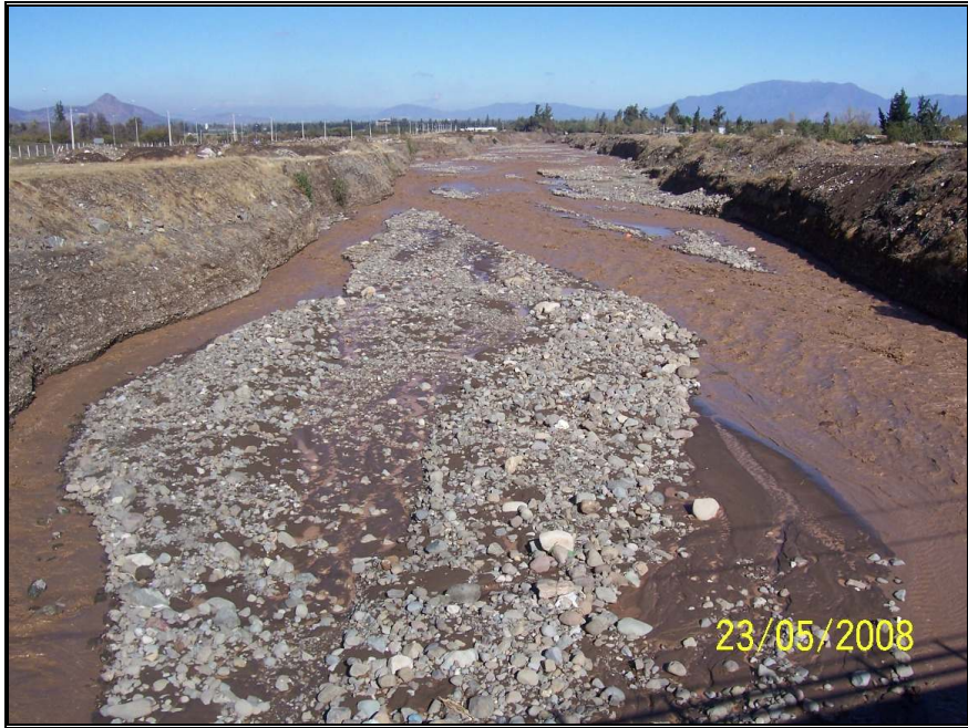
Foto N°5: Vista Aguas Abajo Puente San Luis
