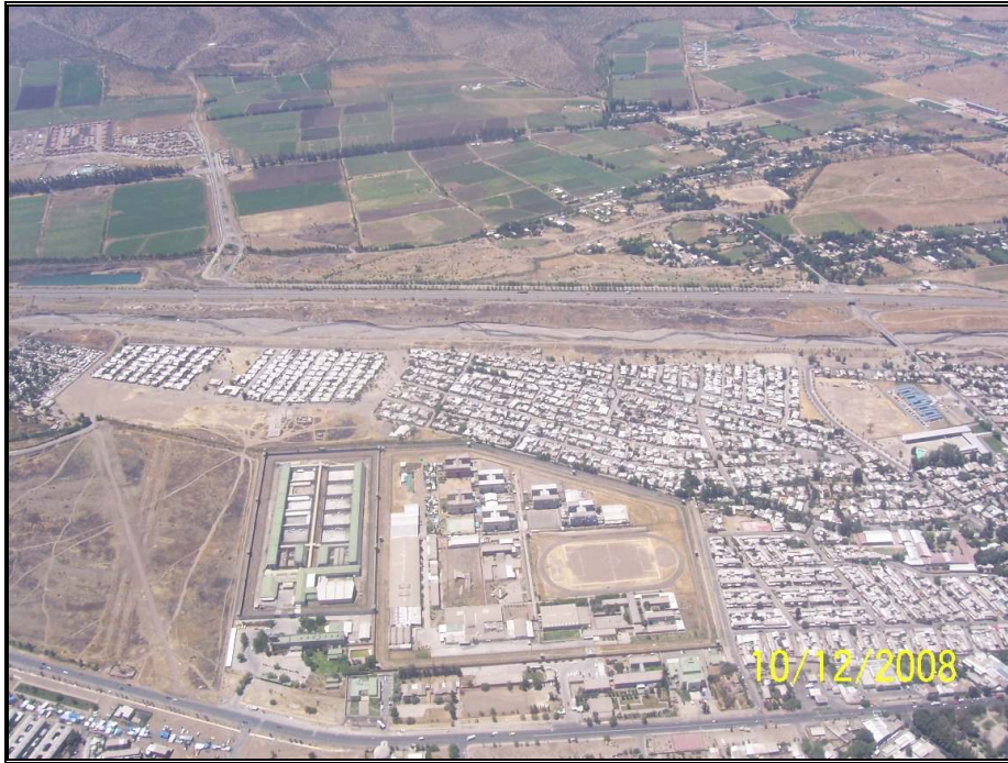
Foto N°3: Tramo Aguas Arriba Puente San Luis
