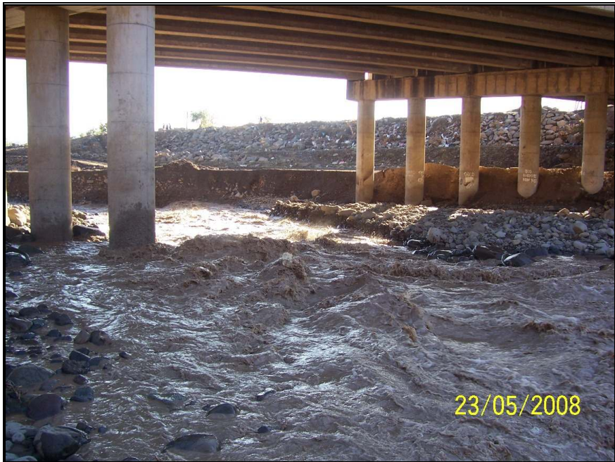
Foto N°10: Columnas Soportantes Puente Esmeralda
