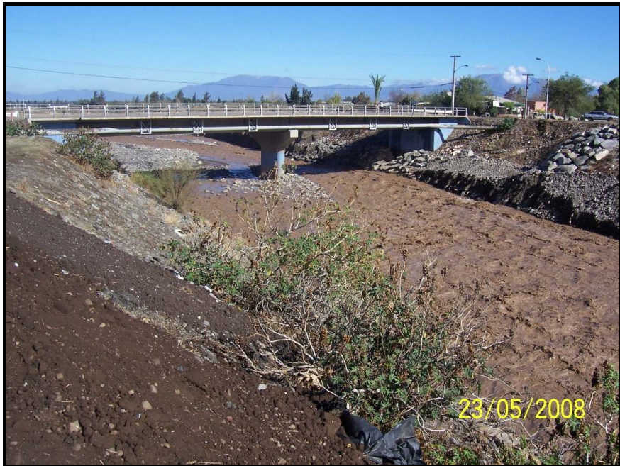
Foto N°6: Puente San Luis, Desde Aguas Arriba
