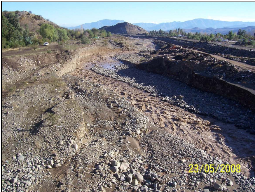
Foto N°8: Vista Aguas Abajo Puente Esmeralda
