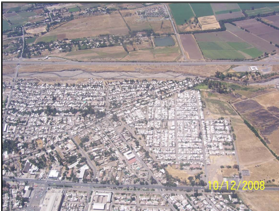
Foto N°2: Tramo Aguas Abajo Puente San Luis
