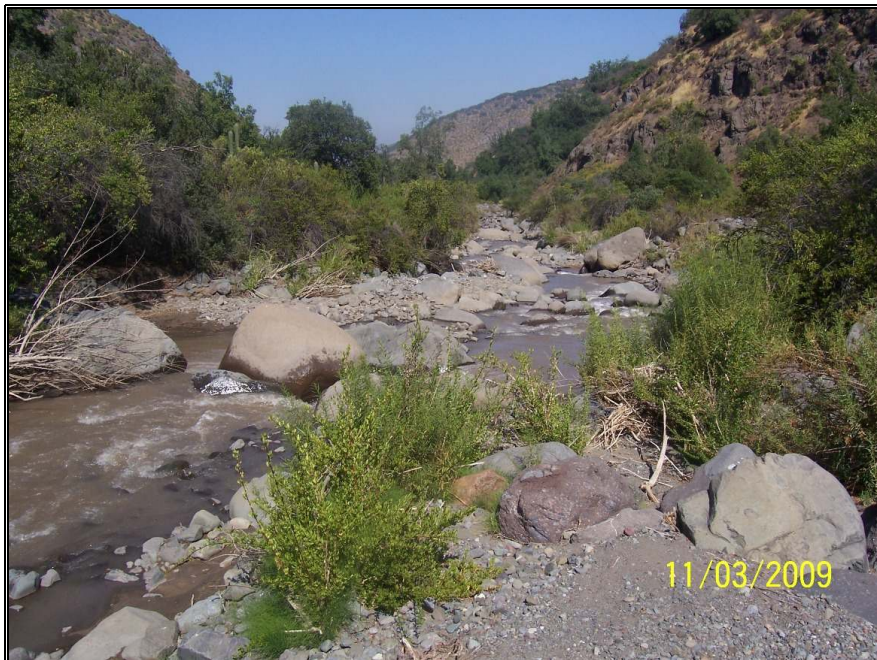
Foto N°18: Sector Aguas Arriba Junta Quebrada Santa Filomena
