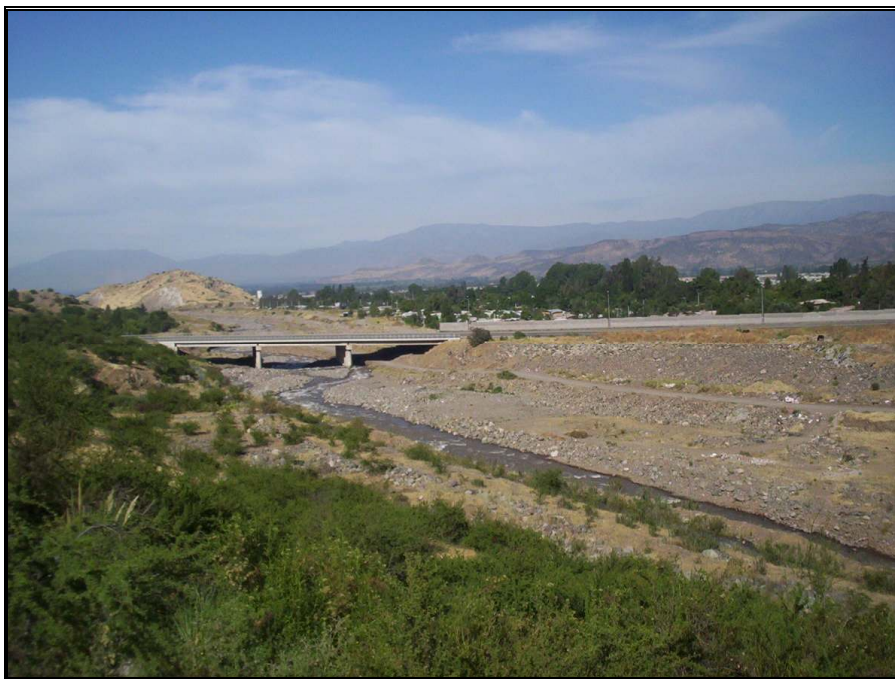
Foto N°2: Puente Esmeralda, Vista Desde Aguas Arriba
