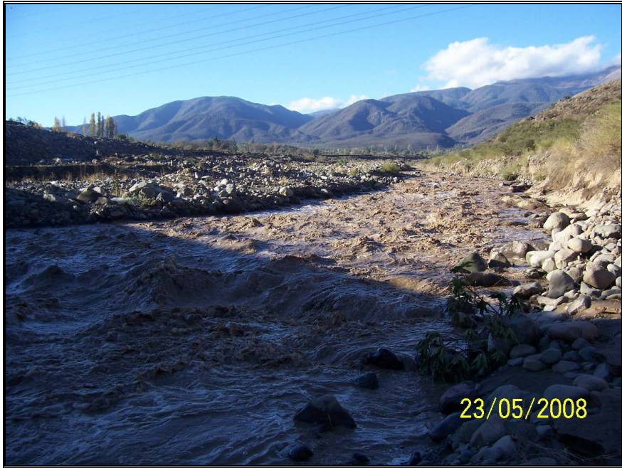
Foto N°9: Vista Aguas Arriba Puente Esmeralda
