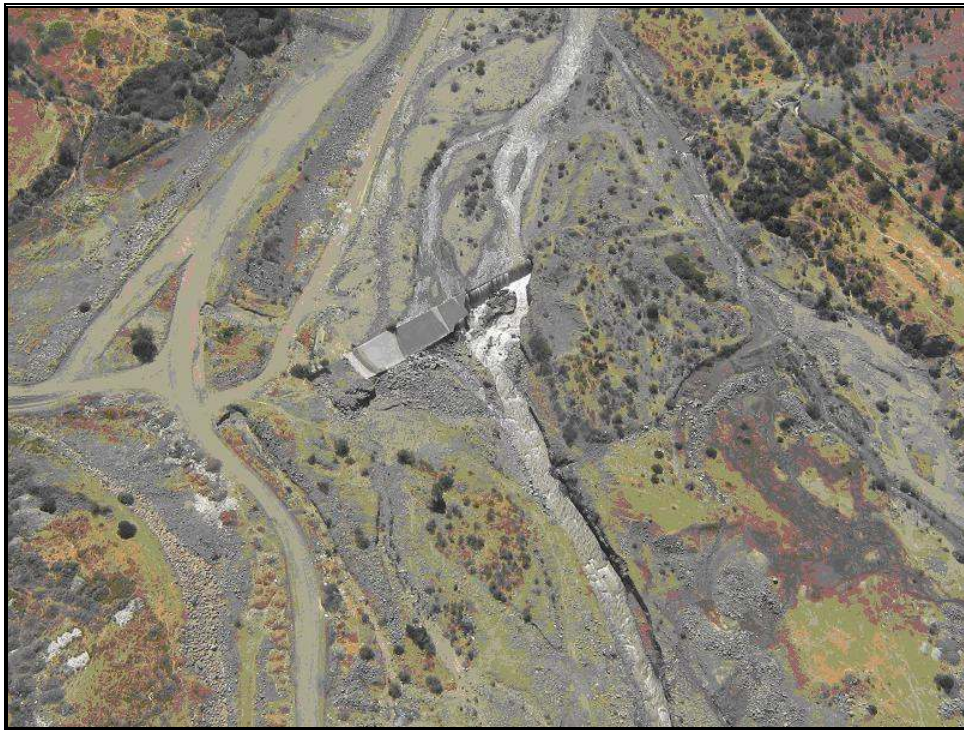
Figura N°4: Sifón El Molino. Fotografía Diciembre 2005 (Fuente Propia)
