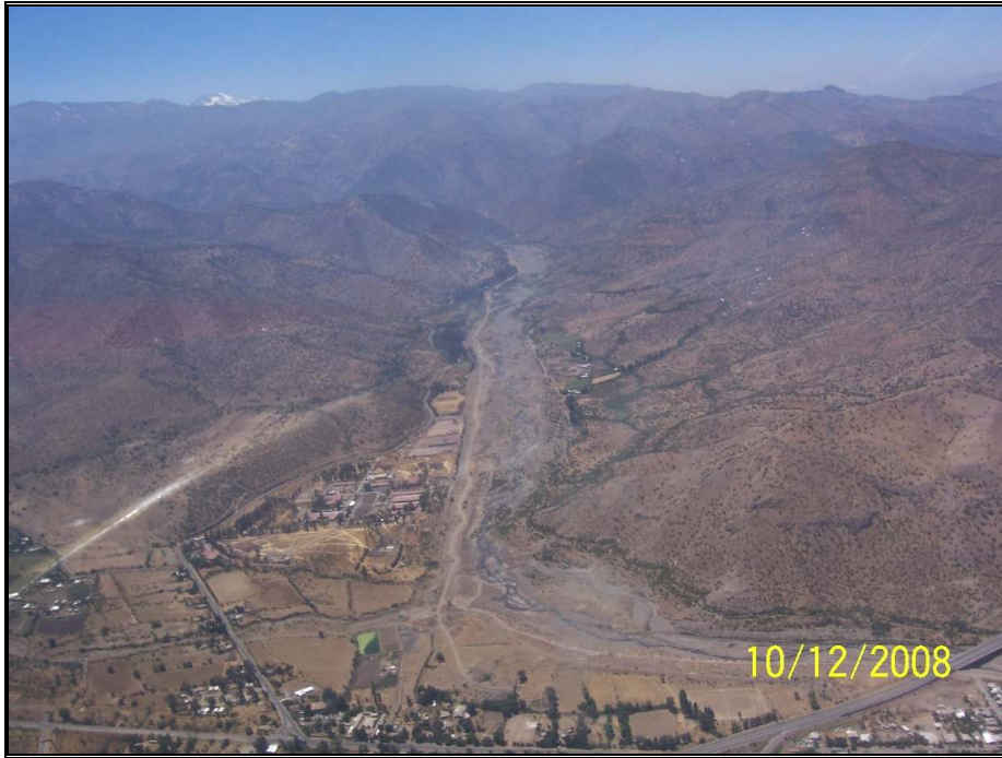
Foto N°5: Tramo Aguas Arriba Puente Esmeralda
