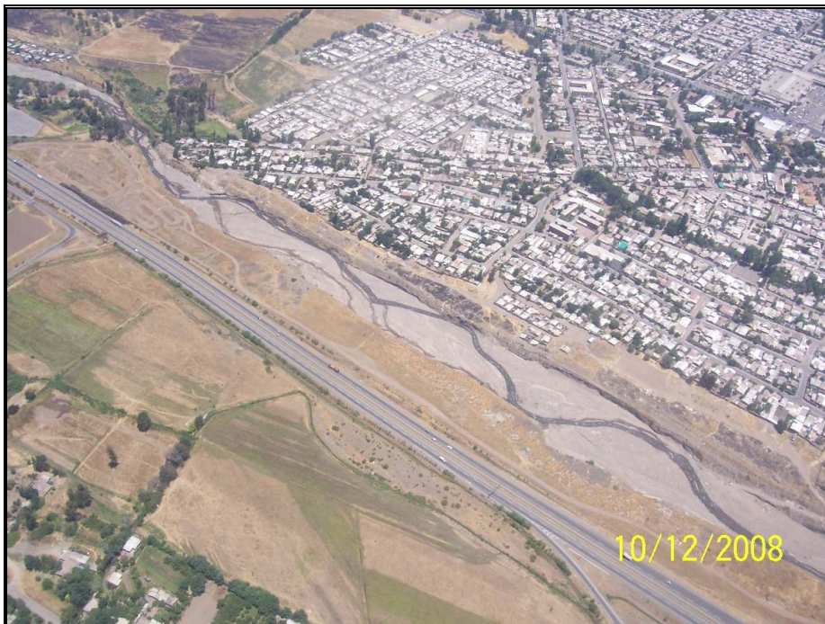
Foto N°16: Tramo Aguas Abajo Puente San Luis
