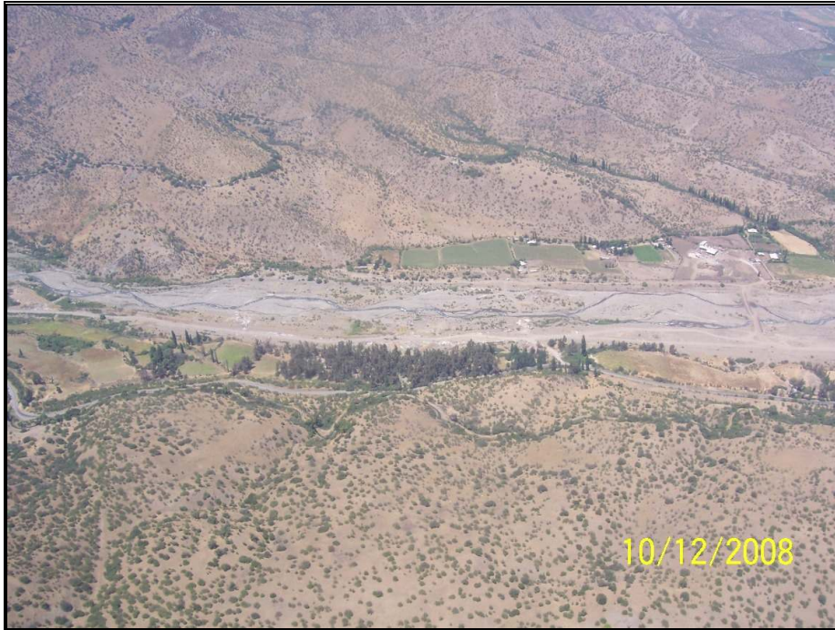
Foto N°9: Tramo Aguas Arriba Badén Peldehue
