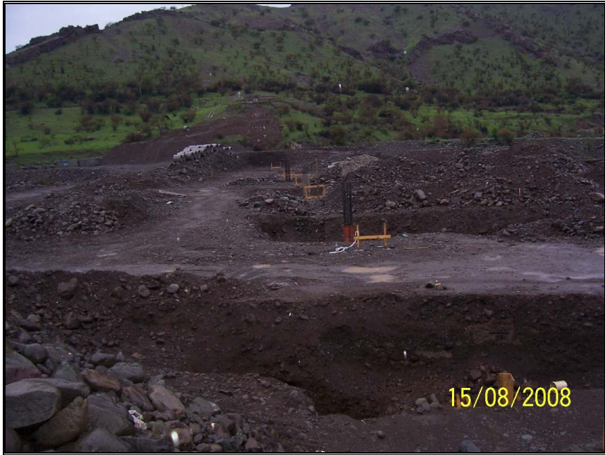
Foto N°5: Columnas Cruce Aéreo Canal Colina, en Construcción
