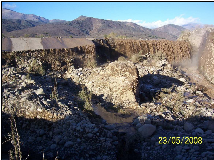
Foto N°14: Sifón El Molino Como Vertedero en Recesión Crecida
