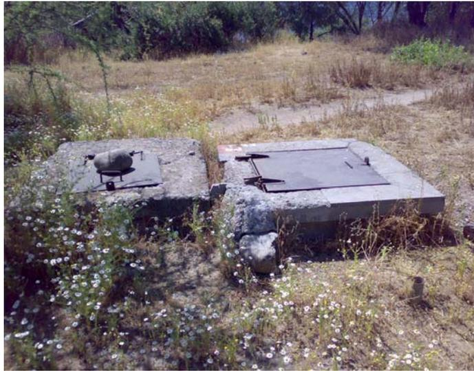
**Fig.2.3: Estanques subterráneos interconectados en la cumbre del cerro Calán (Cap: 70 y 30 m<sup>3</sup>)**
