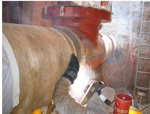
Figura 5.18: Fotografía en pleno proceso instalación de una abertura reforzada mediante piezas soldadas.
