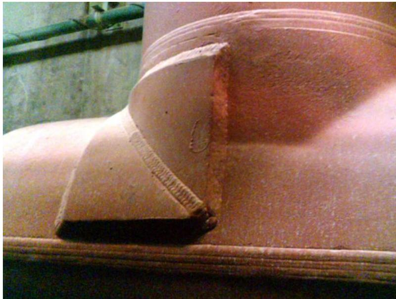
Figura 6.5: Foto de una instalación de piping de transporte de relaves con un refuerzo en una de las zonas críticas identificadas
