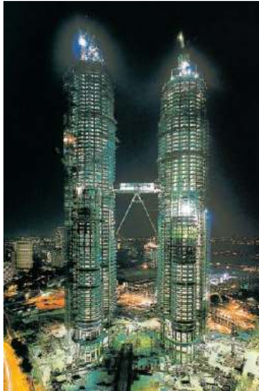
Figura 2.3: Torres Petronas, Singapur, construidas con moldajes auto trepantes.
