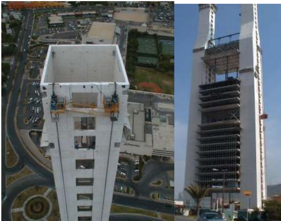
Figura 2.1: Estructuras construidas con moldajes deslizantes.
