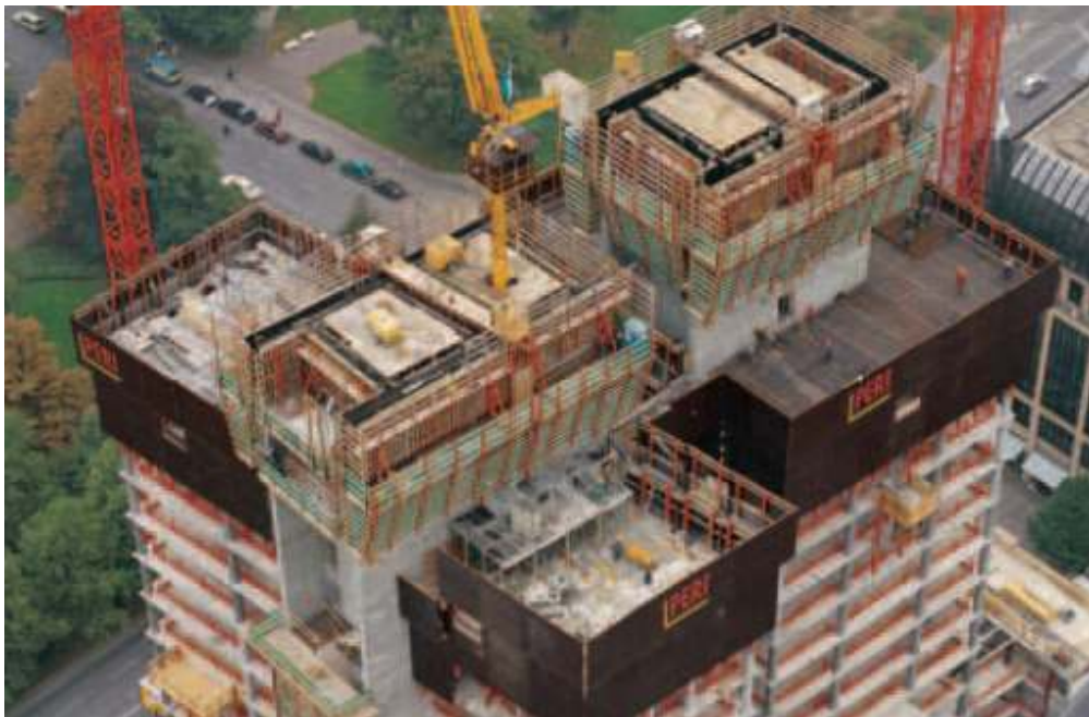
Figura 2.4: Estructura construida con moldajes auto trepantes.
