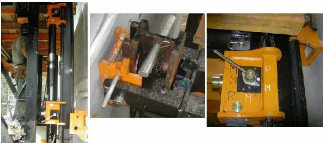
Figura 3.44: Cilindro hidráulico, cajetín con riel inserto y cabezal superior ULMA.
