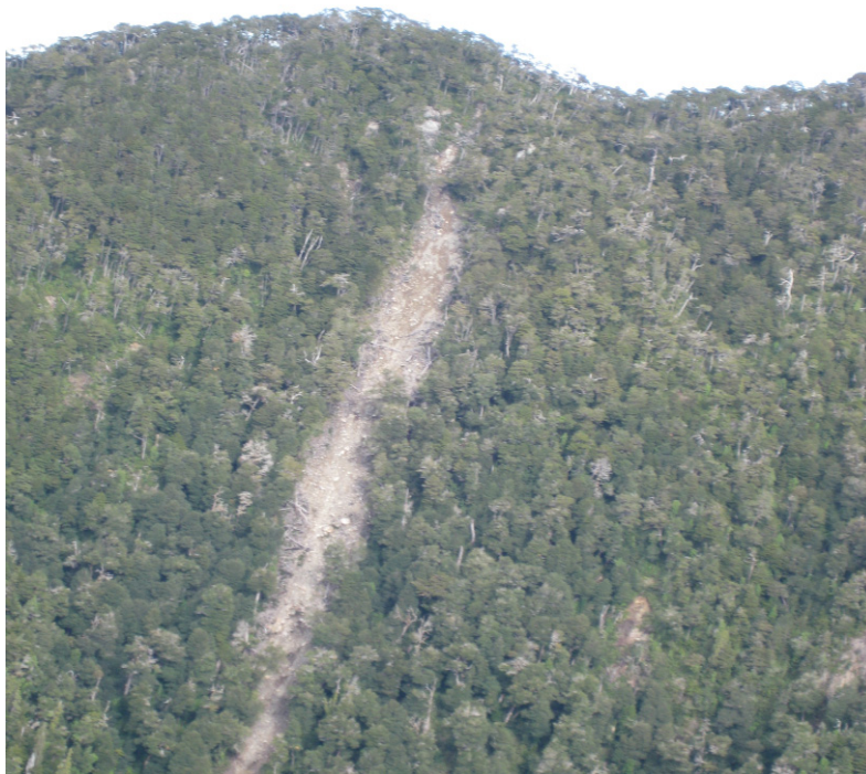
Figura 4.4.: Deslizamiento de roca-suelo.
