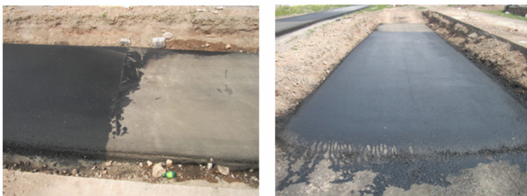
Figura 32: Aplicación de riego liga sobre carpeta asfáltica en la pista sobre base granular
