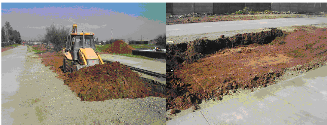
Figura 23: Excavación de capa vegetal para construcción de pista sobre base granular
