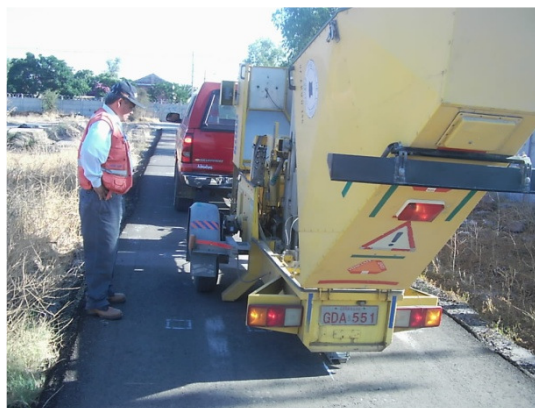
Figura 39: Mediciones deflectómetro del LNV en pista sobre hormigón
