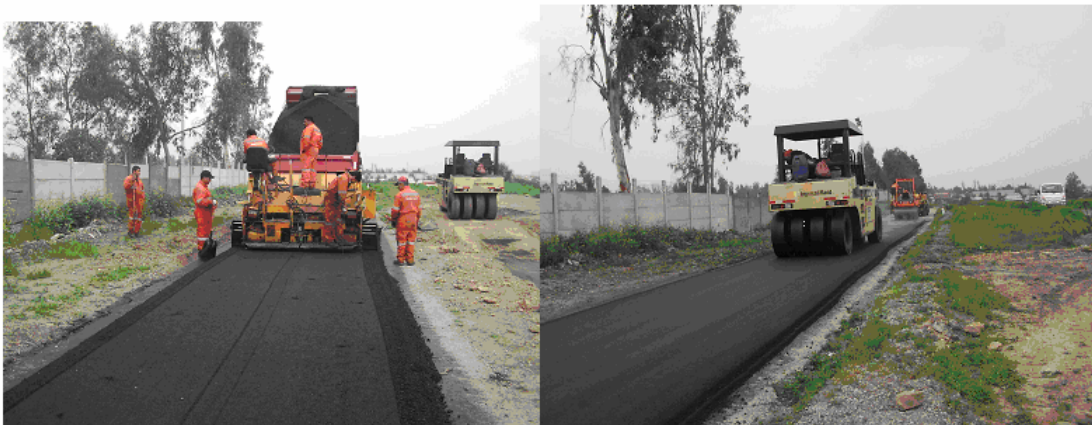
Figura 29: Colocación y compactación de 1ª capa asfáltica en pista sobre hormigón
