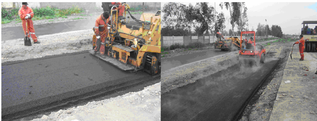
Figura 30: Colocación y compactación de 1ª capa asfáltica en pista sobre base granular
