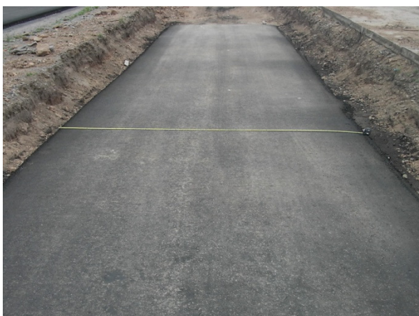
Figura 36: Pista prueba terminada sobre base granular
