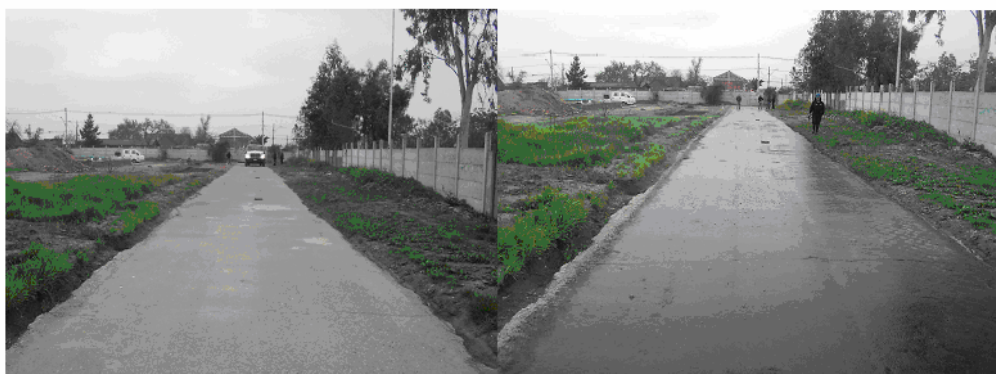
Figura 28: Aplicación riego liga sobre superficie HCR
