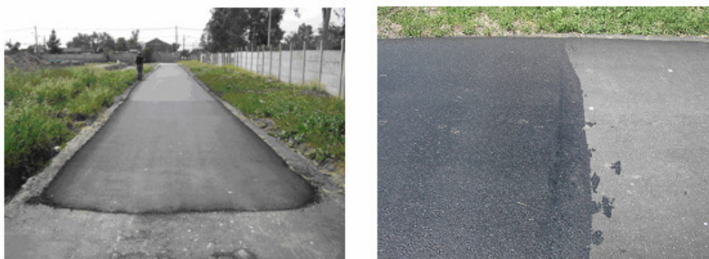
Figura 31: Aplicación de riego liga sobre carpeta asfáltica en la pista sobre hormigón
