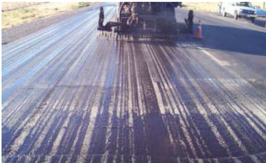
Figura 5 Aplicación no uniforme del riego de liga
