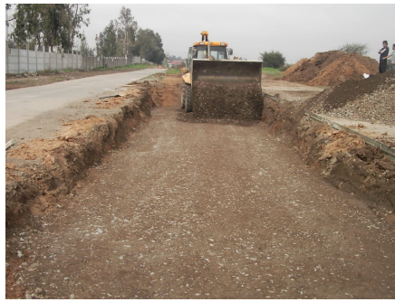
Figura 24: Colocación de material para base granular
