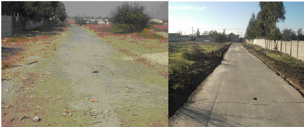
Figura 17: Pista existente de Hormigón Compactado por Rodillo
