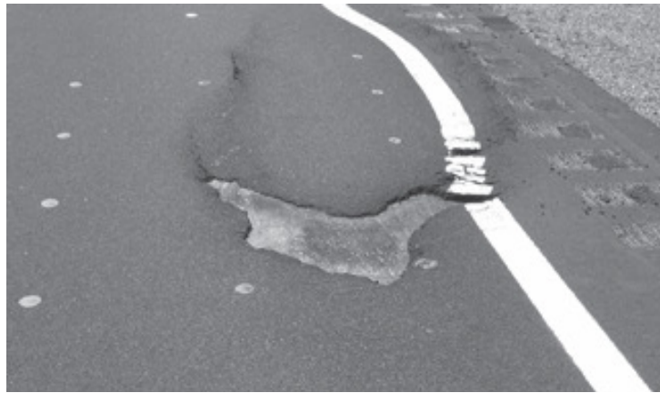
Figura 1: Falla deslizamiento
