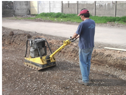
Figura 25: Compactación de 2° capa granular
