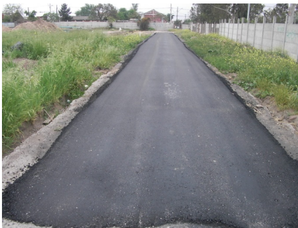
Figura 35: Pista prueba terminada sobre hormigón
