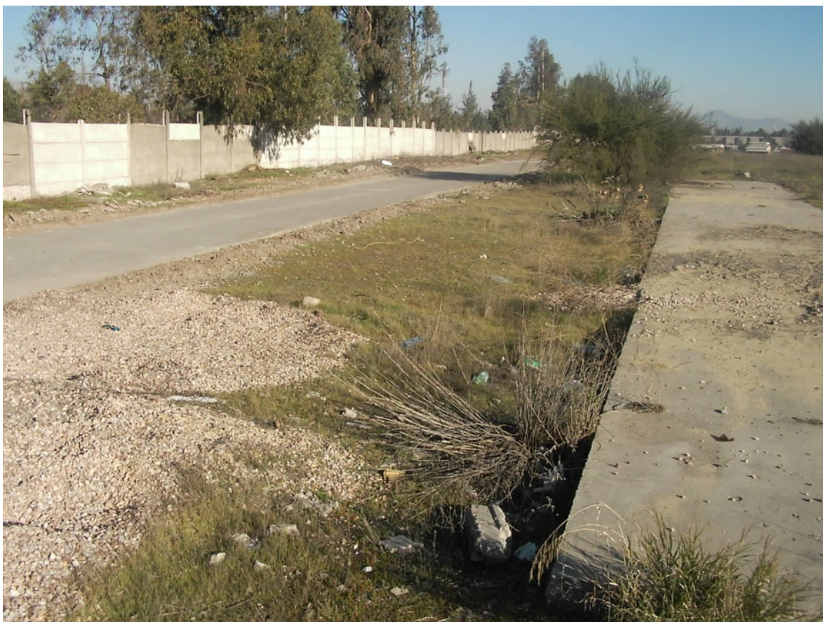
Figura 18: Zona a construir pista sobre base granular
