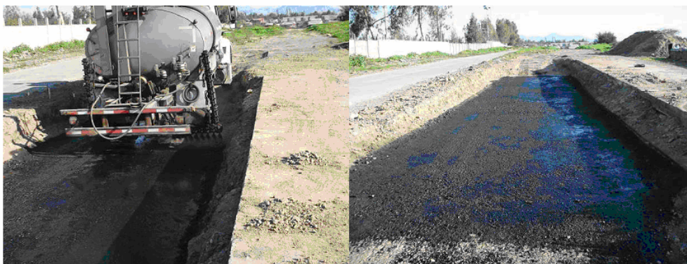
Figura 27: Imprimación de base granular
