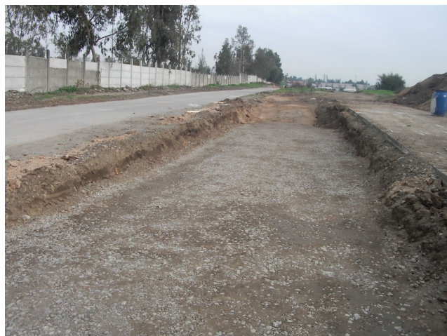
Figura 26: Base granular colocada
