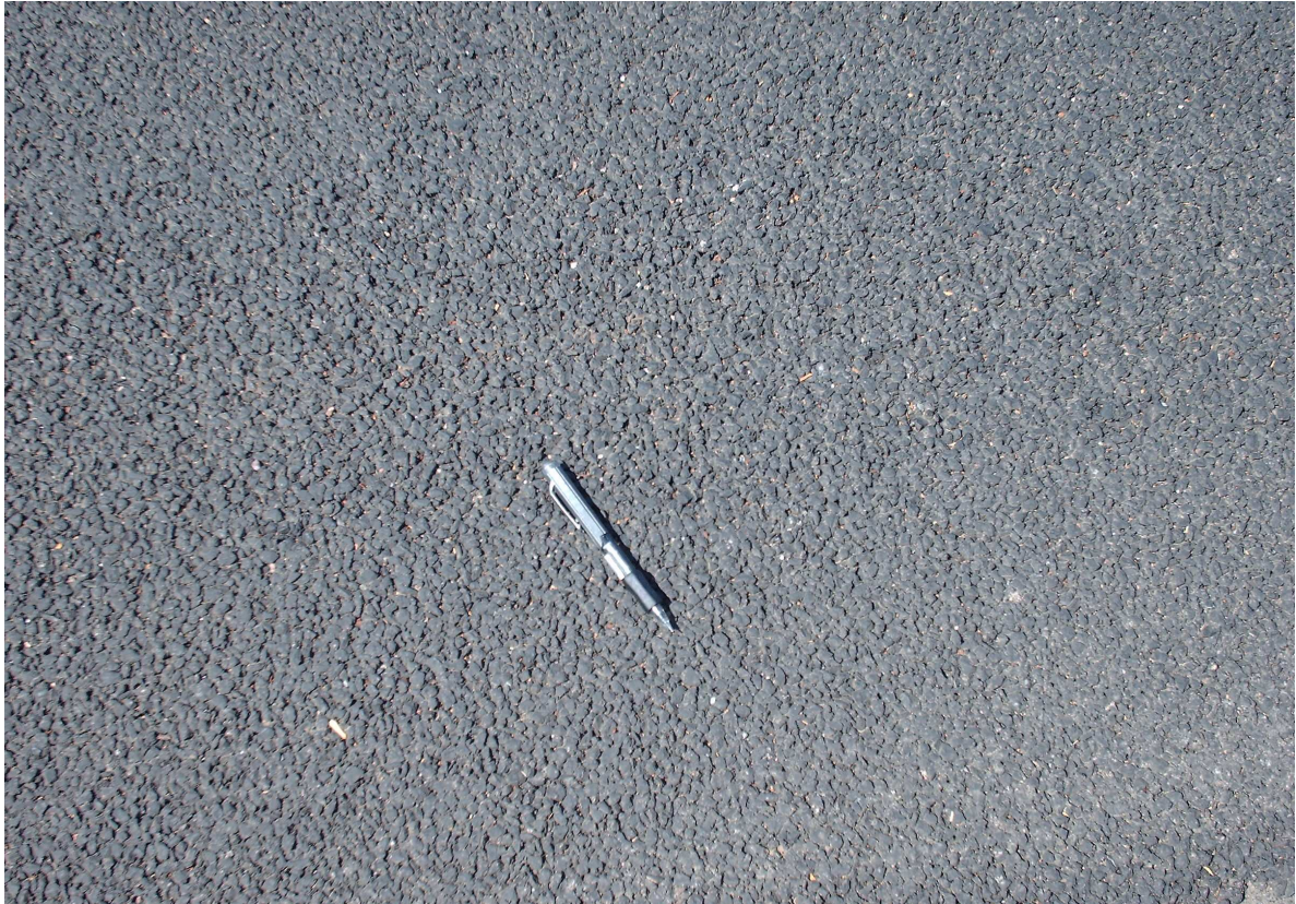
Figura 30: Textura de los tramos construidos con mezcla M-8 en la Autopista del Itata, VIII Región.
