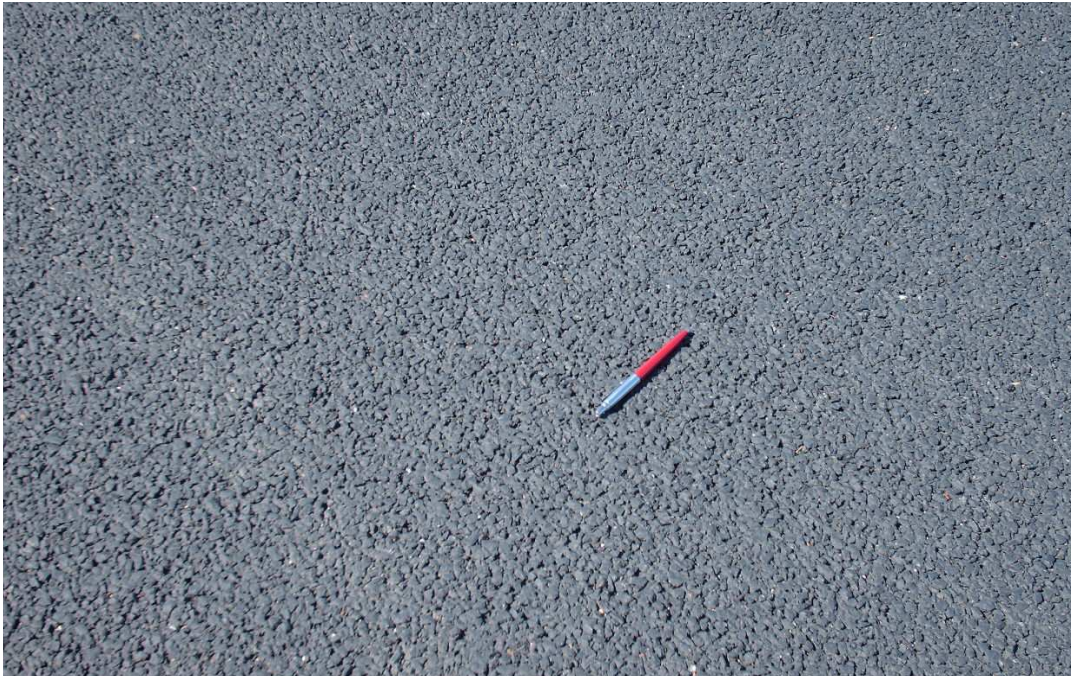
Figura 31: Efecto de “cierre” de la superficie en la Autopista del Itata, VIII Región.
