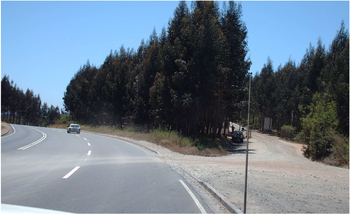
Figura 36: Zona de salida de vehículos en la Ruta 160, Sector Lota, VIII Región.
