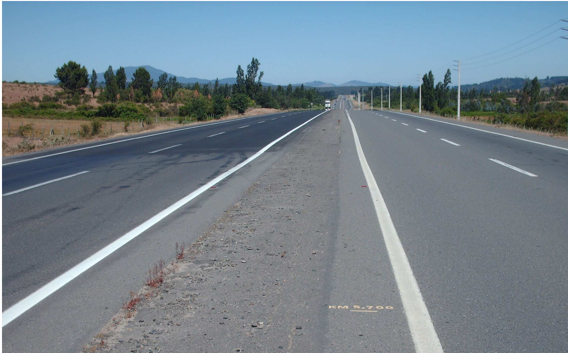
Figura 28: Vista general Autopista del Itata, VIII Región.
