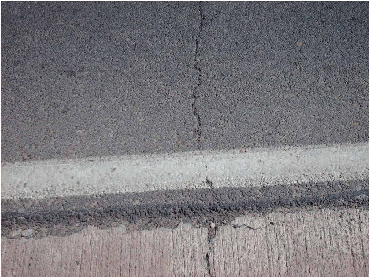
Figura 15: Terminación en el borde de la calzada en el tramo F-10, San Felipe, V Región.
