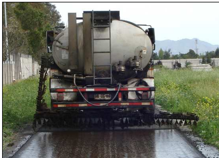
Figura 3.7 Aplicación de riego de liga sobre pista HCR
