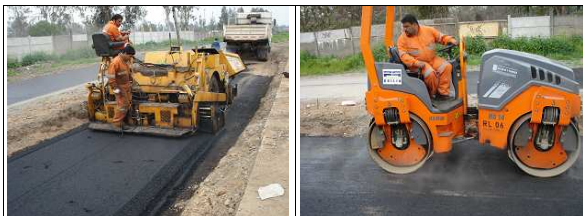
Figura 3.5: a) Colocación de mezcla asfáltica en pista sobre base. b) compactación con rodillo liso
