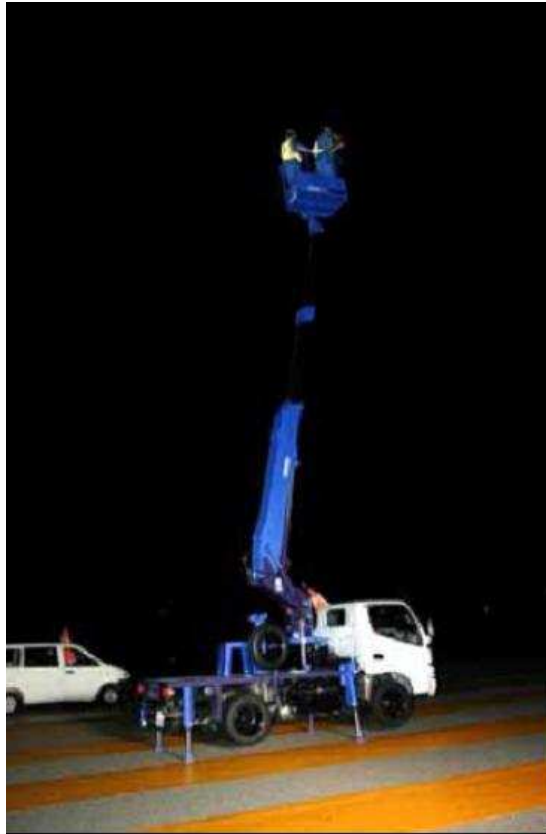
Figura 2.18: Grúa utilizada para la auscultación de pavimentos mediante método infrarrojo.
