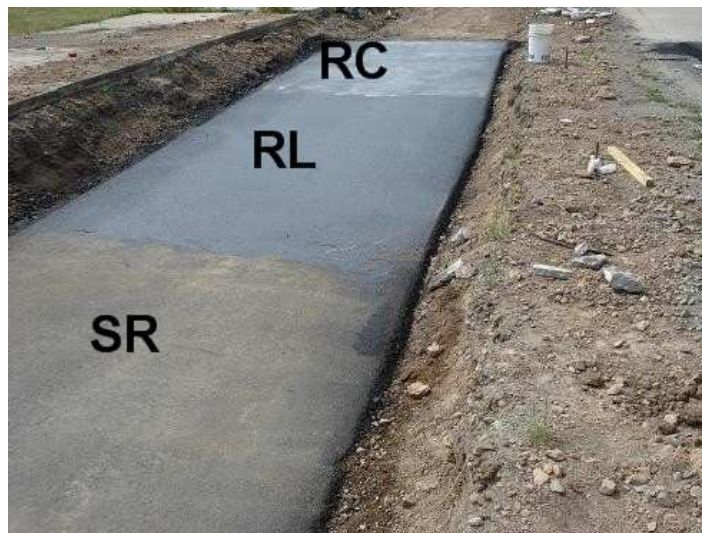
Figura 3.8 Superficie de primera capa asfáltica sobre base granular y tramos con diferente tratamiento. Arriba riego contaminado (RC), riego limpio al centro (RL) y sin riego en la parte inferior (SR).
