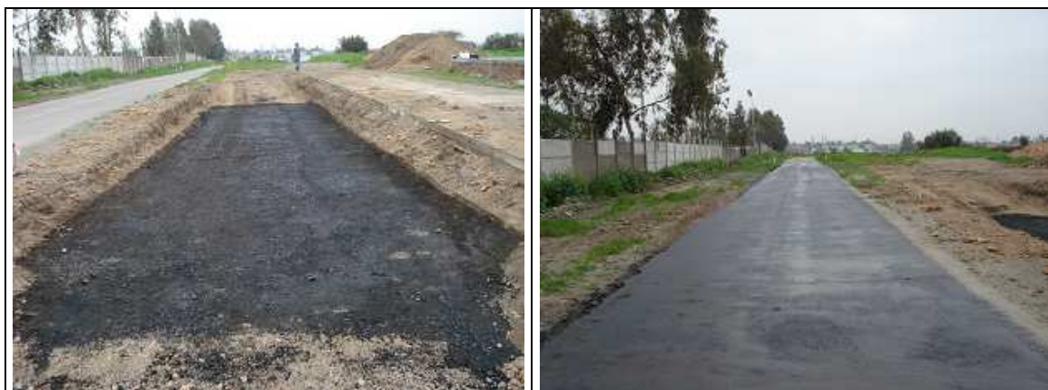
a. Base granular imprimada
