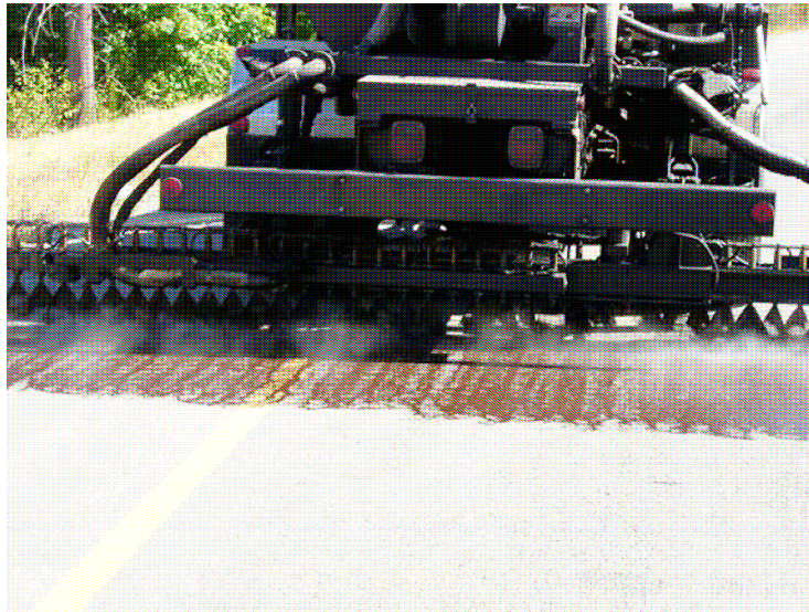
Figura 2.1: Aplicación de riego de liga
