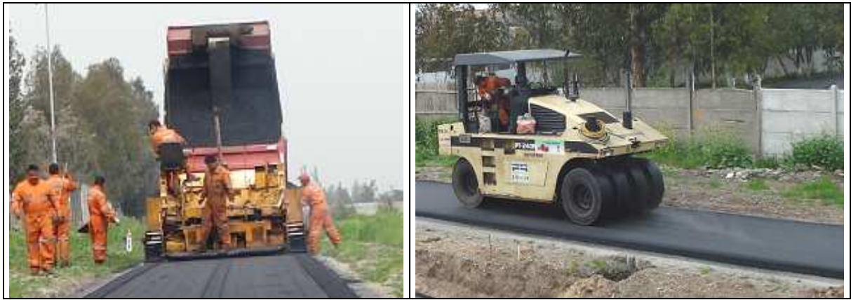
Figura 3.6: a) Colocación de mezcla asfáltica sobre HCR. B) Compactación con rodillo neumático.
