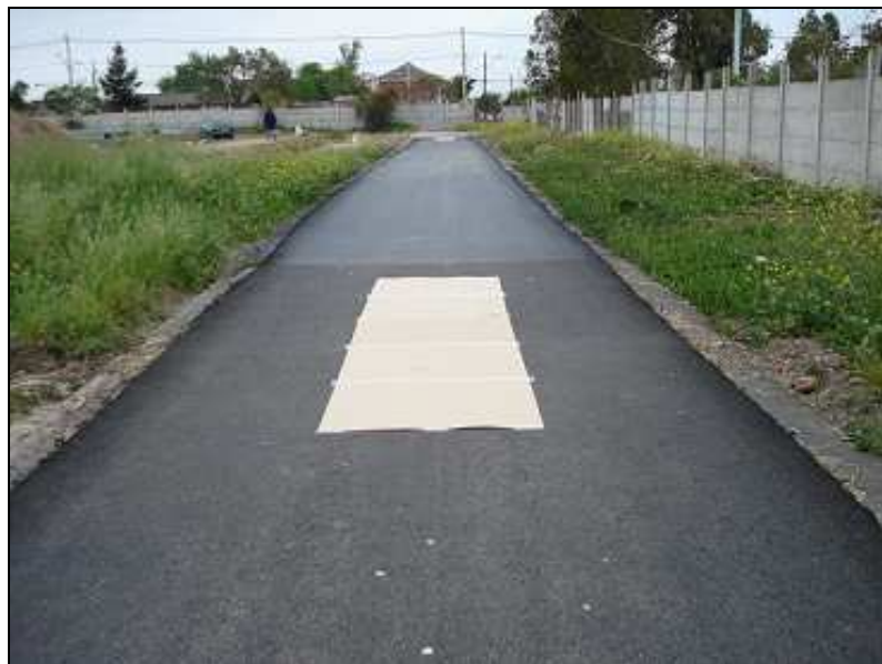
Figura 3.10: Ubicación de franjas de papel para materializar zonas sin adherencia.
