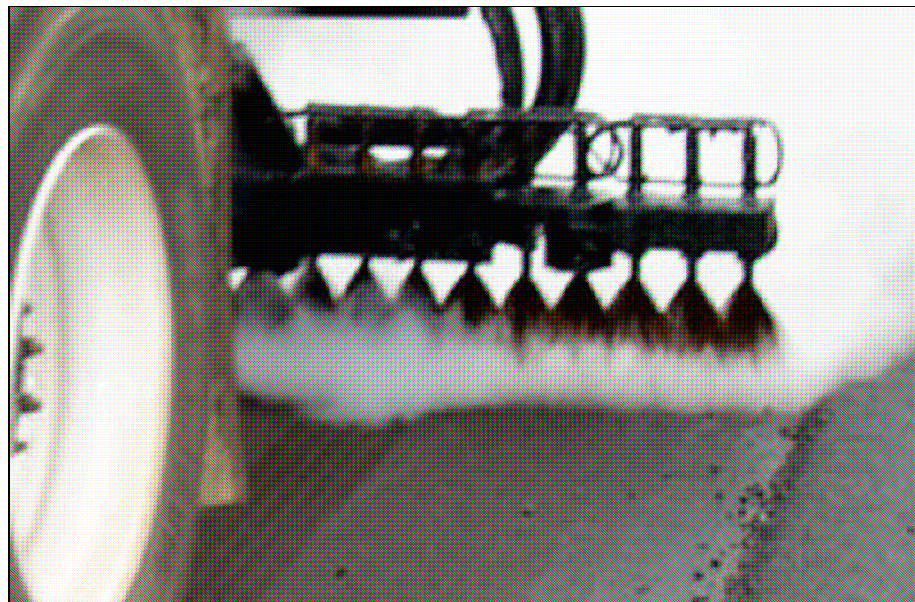
Figura 2.6: Riego de liga con cubrimiento total de la superficie tratada.
