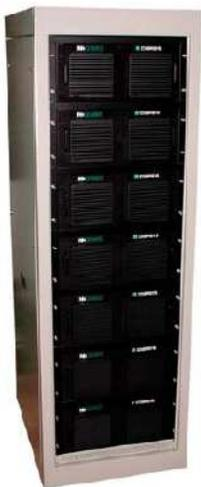
Figura 32. Sistema de baterías de NiMH. Fuente: Mission Critical West Inc.
