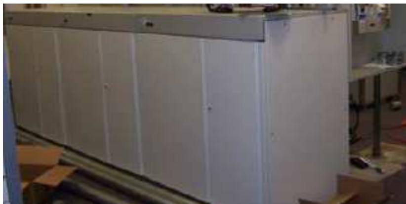
Figura 31. Gabinete con baterías de tipo SLA. Fuente: ESA.
