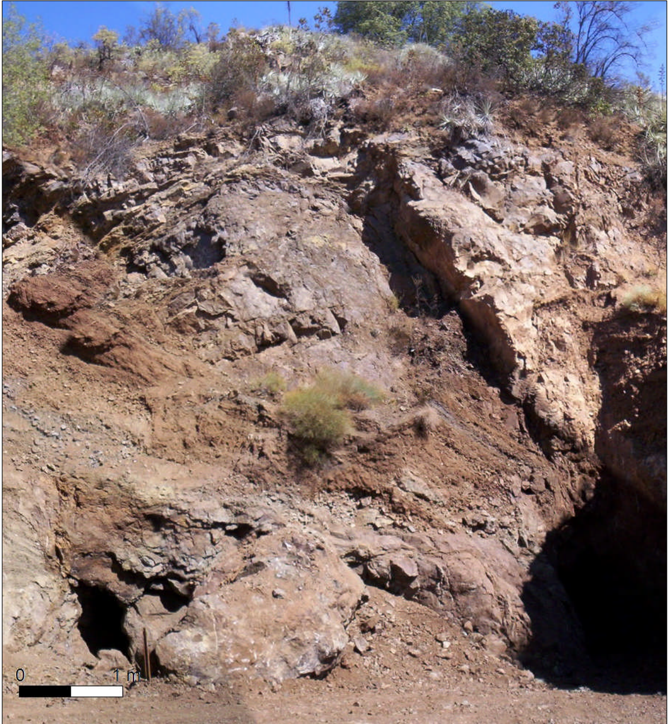
Foto 7. Dique de brecha plegando calizas (314007E, 6261982N). Se observa contacto por falla en esta zona, además de labores mineras.
