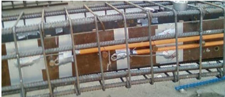
**Figura 3.4: Protección de PVC para el cableado**
