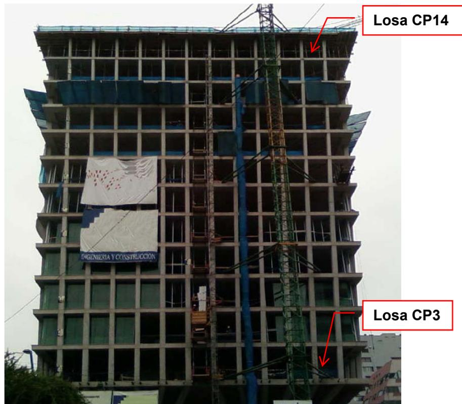
Figura 4.6: Avance de la obra para la 6ta medición (16/12/08)
