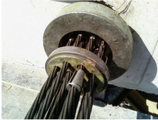
**Figura 2.10: Detalle de los 12 cables de postensado**
