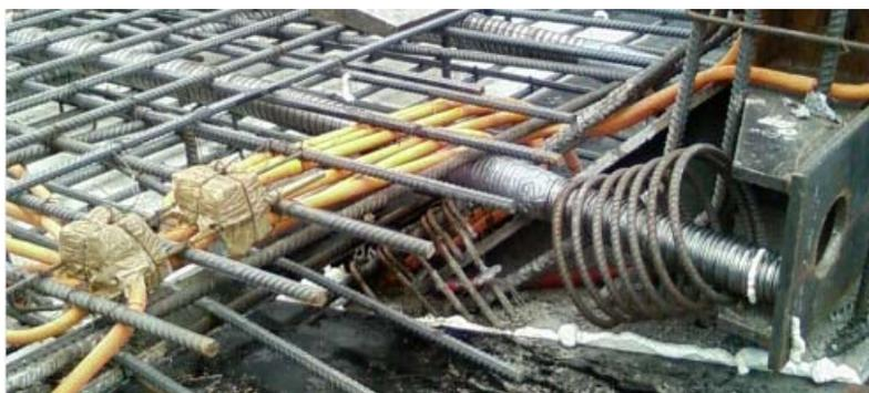
**Figura 3.5: Caja eléctrica instalada al nivel de losa cielo piso tres**
