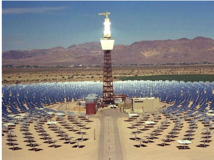
Figura 2.2.3.3: Ejemplo de torre concentradora Solar Two, USA.
