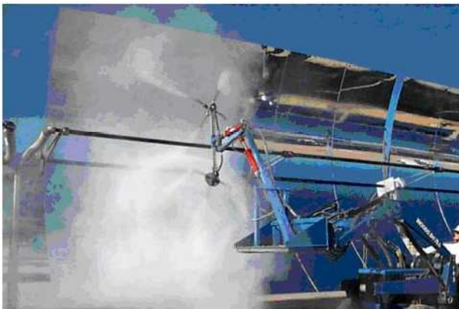
Figura 4.4.1: Ejemplo de sistema de lavado de espejos Mr. Twister
