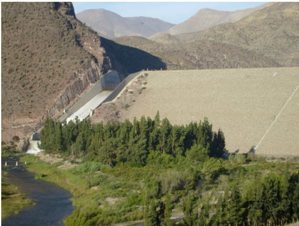
Figura 4.5: Muro y evacuador de crecidas del embalse Puclaro.
