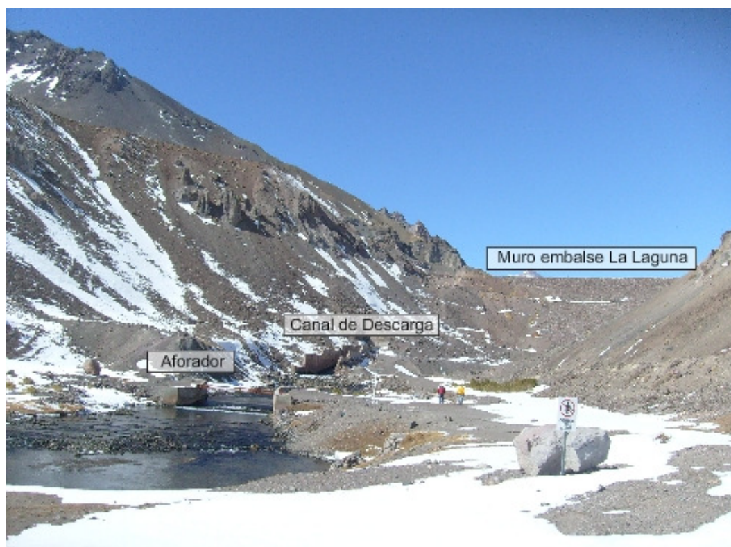
Figura 4.10: Muro, canal de descarga y aforador del embalse La Laguna.
