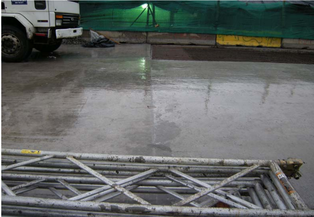
Fig. 6.1.3.5.7 Losa Cargada con Camión. Según datos de obra, al día 7, la losa ha alcanzado el 75% de su resistencia.
