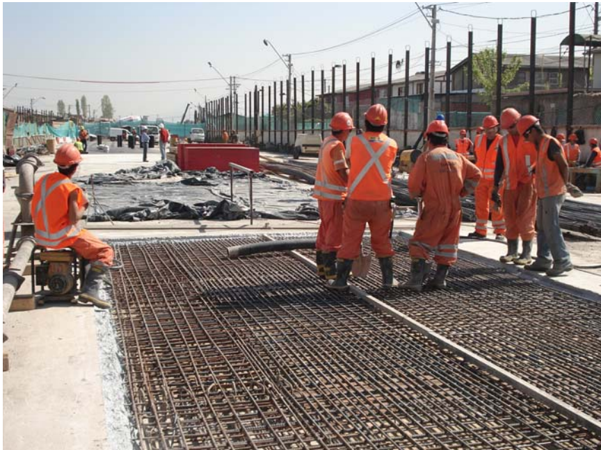
Fig. 2.3.7 Tramo en Espera de Hormigonado. Como proceso constructivo se hormigonan tramos no muy grandes según el avance de proyecto.
