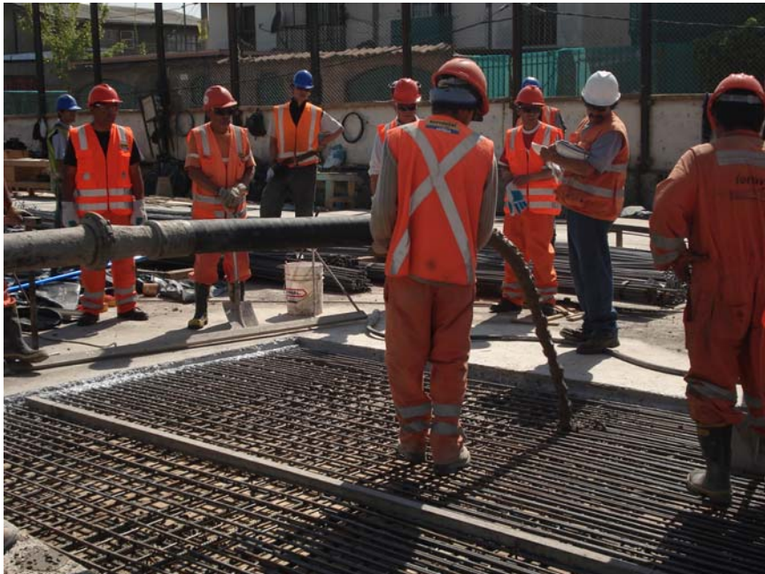
Fig. 2.3.9 Vaciado Hormigón. Se aprecia la operación de vaciado continuo utilizando las tuberías de la bomba.
