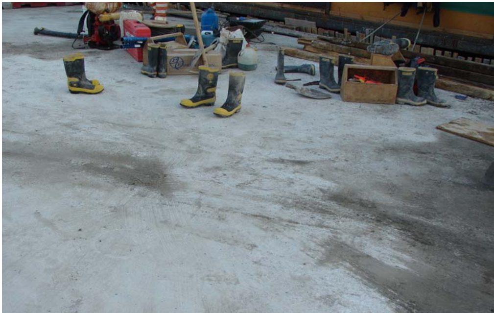
Fig. 6.1.3.4.2 Acercamiento Losa Central, Zona Control 1. No se aprecian fisuras.
