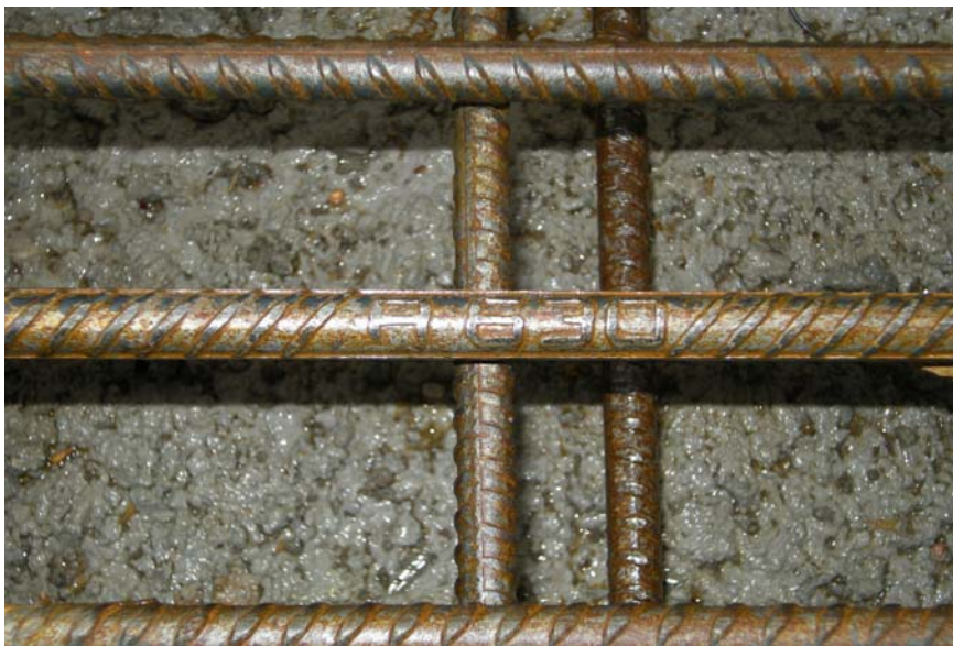
Fig. 2.3.5 Colocación Armaduras. Detalle de la marca acero A630 (A63-42H) empleado.
