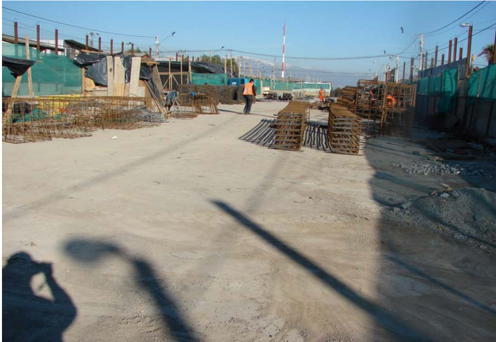
Fig. 6.1.3.6.3 Losa Aledaña Zona Control 1 Hacia el Sur. Se aprecia acopio de armaduras y restos de materiales.
