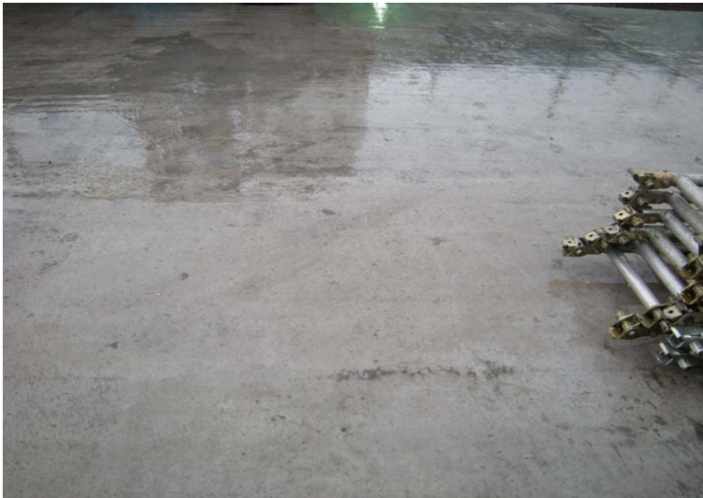
Fig. 6.1.3.5.6 Acercamiento Losa Central, Zona Control 1. No se aprecian fisuras.
