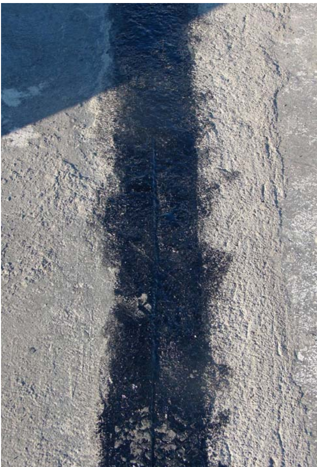
Fig. 6.1.3.6.8 Detalle de Sellado Fisura.
