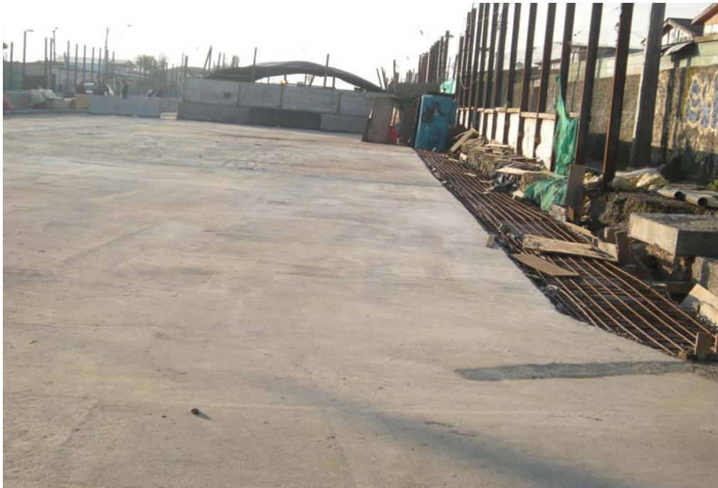
Fig. 6.1.3.13.10 Losa Oriente Fin Tramo 3. Aledaño Avenida San José de la Estrella. Sin fisuración. Losa extrema oriente sobre pilotes. Detalle.
