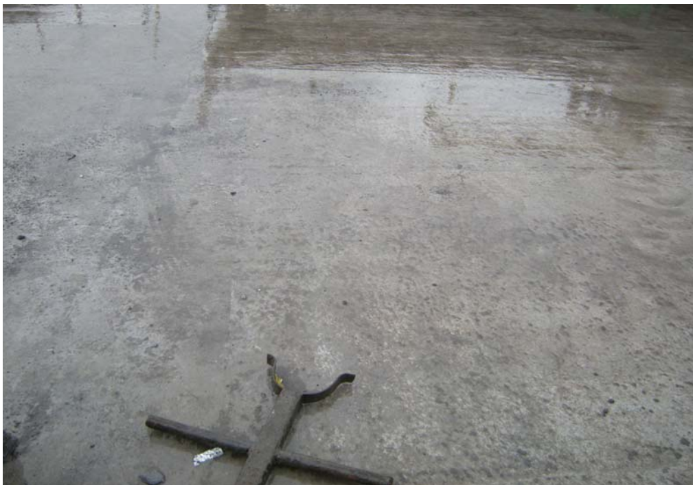
Fig. 6.1.3.5.2 Acercamiento Losa Central, Zona Control 1. No se aprecian fisuras.
