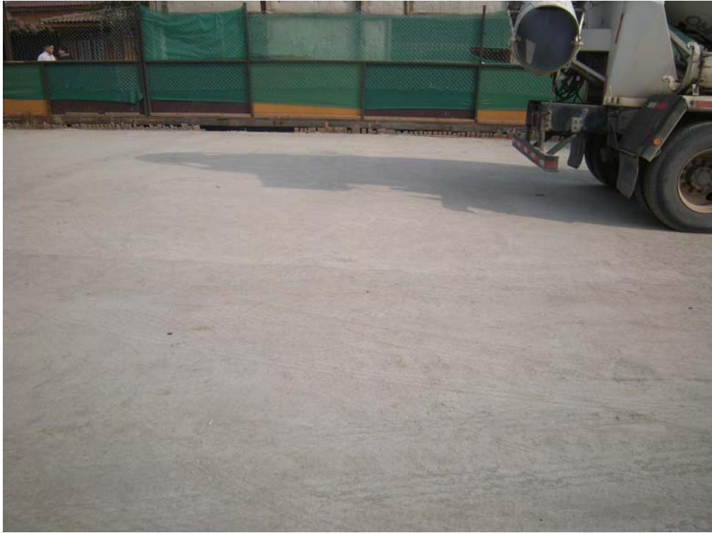
Fig. 6.1.3.8.5 Vista Losa Zona Control 1. Se aprecia como transitan sobre la losa camiones betoneros. A la fecha no se encuentran fisuras.
