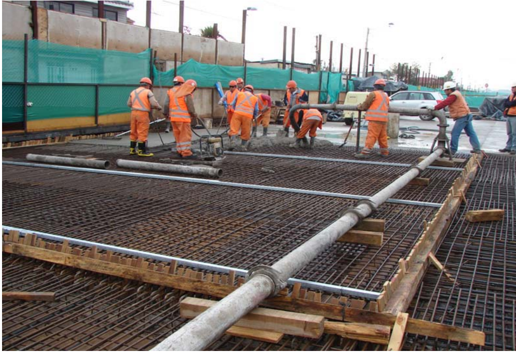
Fig. 6.1.3.3.5 Vista General de Losa de Control en Proceso de Hormigonado. Se puede apreciar las guías de nivel dispuesta sobre la enfierradura.
