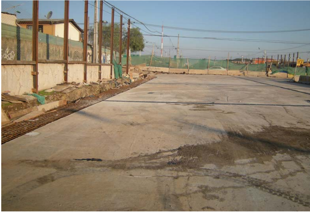
Fig. 6.1.3.13.7 Losa Oriente Fin Tramo 3, Aledaño Avenida San José de la Estrella. No presenta fisuración a pesar de tener paños muy maltratados.
