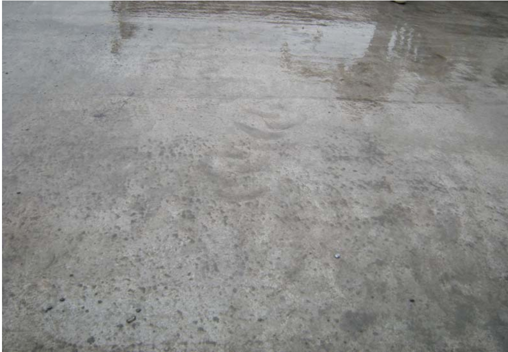
Fig. 6.1.3.5.3 Acercamiento Losa Central, Zona Control 1. No se aprecian fisuras.
