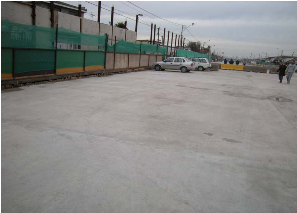
Fig. 6.1.3.7.5 Losa Zona Control 1. Se aprecia un buen estado general a pesar del tránsito sobre ella y la carga de trabajo de generación de armaduras.
