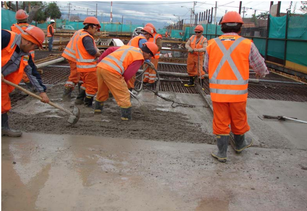
Fig. 6.1.3.3.6 Trabajo de Colocación del Hormigonado, Alisado con Viga de Nivelación.
