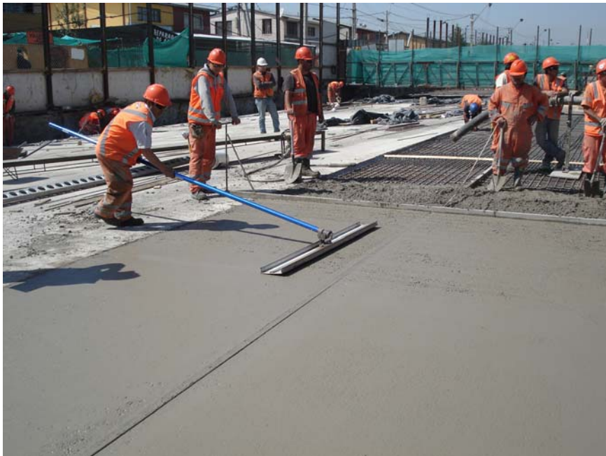
Fig. 2.3.15 Alisado Final Superficial de Hormigón. Esta etapa del proceso constructivo es importante, ya que una buena terminación permite una losa lisa y sin alteraciones superficiales para la colocación de la membrana de impermeabilización y además permite el sellado de las primeras fisuras que puedan ocurrir por la pérdida de agua que se produce en el hormigón.
