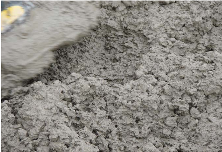
Fig. 2.3.10 Consistencia del Hormigón al Salir de la Tubería. Antes del proceso de vibrado.
