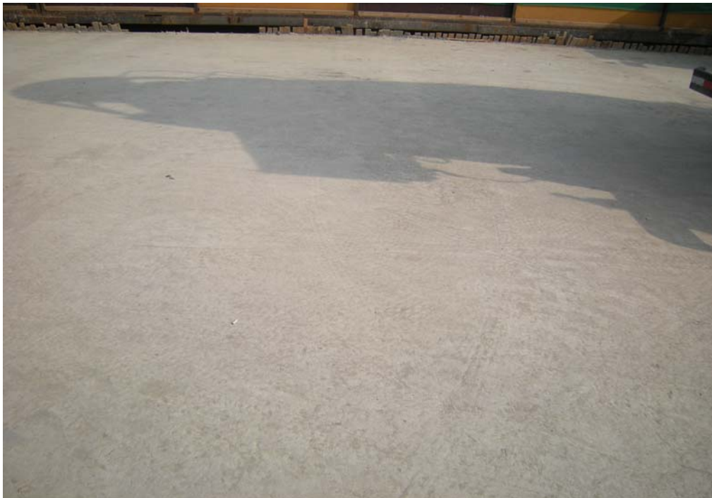
Fig. 6.1.3.8.6 Vista Losa Zona Control 1. A la fecha no se encuentran fisuras.
