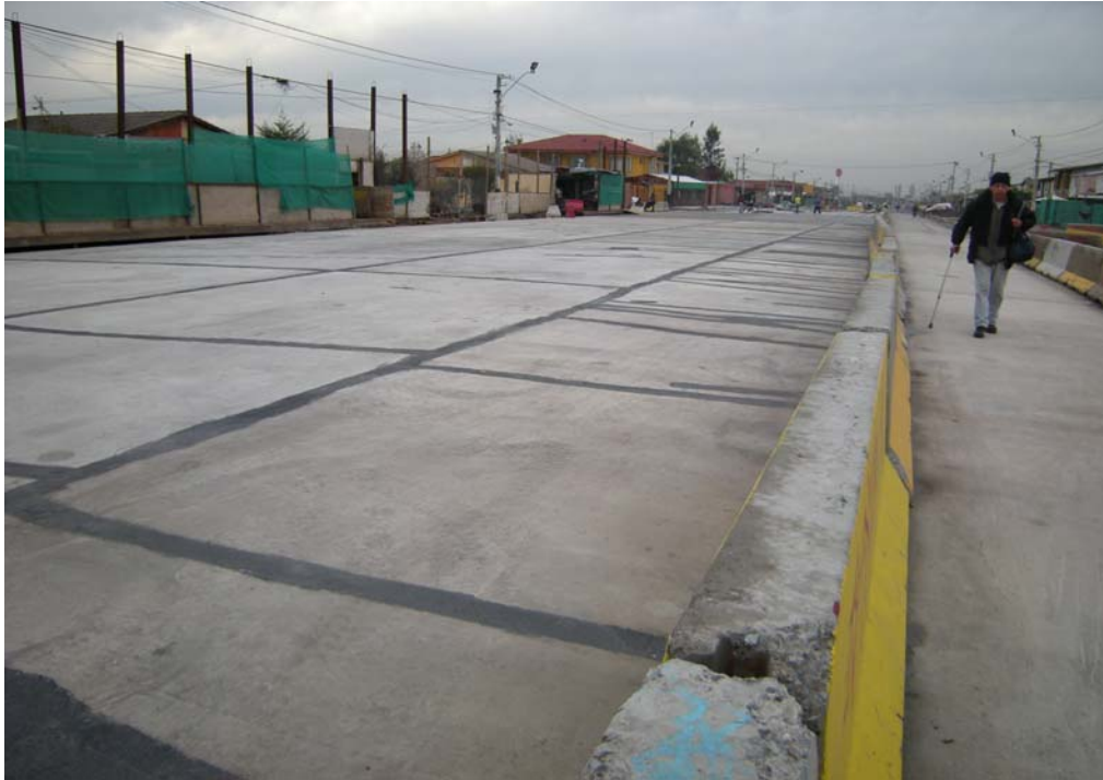
Fig. 6.1.3.7.15 Losas en Zona PK 1340, Entre Zona Control 1 y Calle Pedro Lira. Calzada poniente. Zona aislada con pocas fisuras. Se aprecia el sellado de las juntas de construcción.
