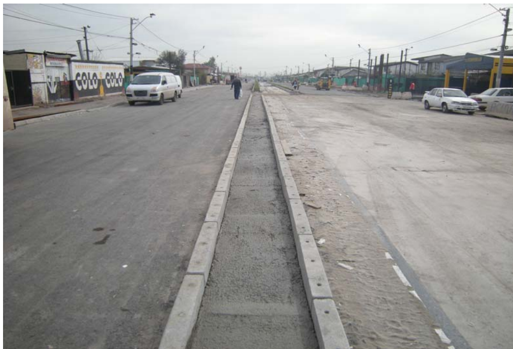
Fig. 6.1.3.14.2 Zona Control 1. Calzada poniente terminada con pavimento. Muestra trabajos en aceras. Calzada oriente aún con losa a la vista. Sin fisuras.
