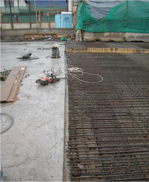
Fig. 6.1.3.2.5 Vista Junta de Construcción con Zona Aledaña ya Hormigonada. Junta en Eje de Viga.
