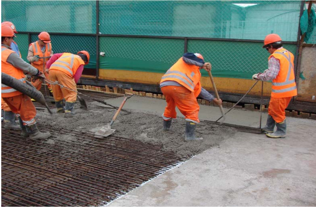
Fig. 6.1.3.3.1 Inicio Hormigonado. La losa de control comienza a ser hormigonada por el poniente y en zona de junta de construcción con losa adyacente lado norte.
