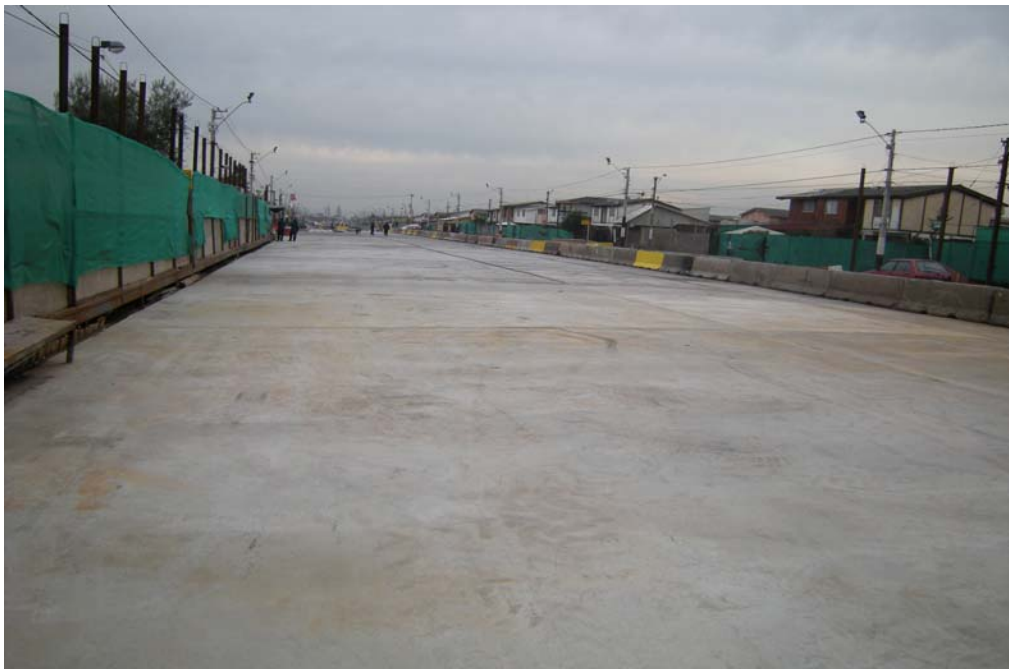
Fig. 6.1.3.7.12 Losas Aledañas Zona Control 1. Importante extensión Tramo 3, en buen estado. Sin fisuras.
