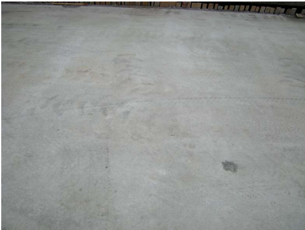
Fig. 6.1.3.7.8 Losa Zona Control 1. Acercamiento. Solo marcas sin fisuras.
