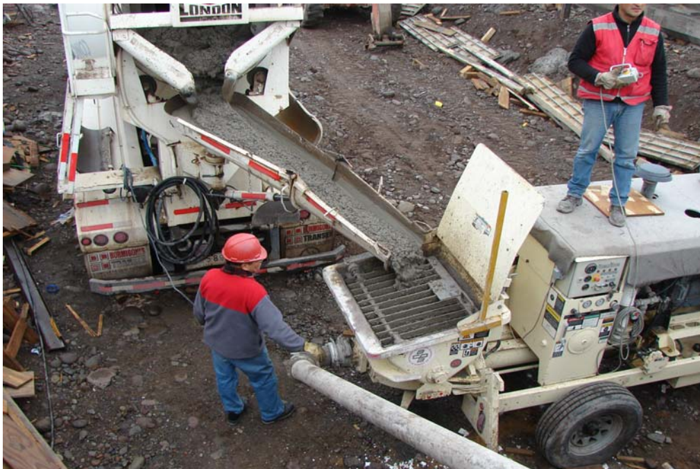
Fig. 6.1.3.3.2 Sistema de Bombeo del Hormigón. Camión situado unos metros bajo el nivel de la losa.
