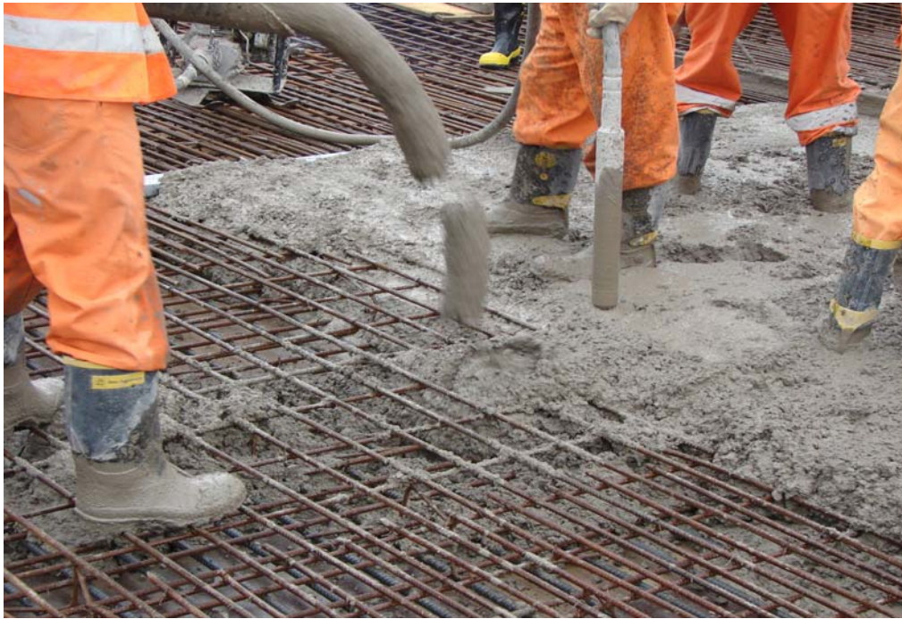
Fig. 6.1.3.3.3 Caída del Hormigón desde la Tubería de Traslado y Vibrado Tradicional.
