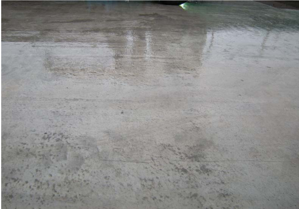
Fig. 6.1.3.5.5 Acercamiento Losa Central, Zona Control 1. No se aprecian fisuras.
