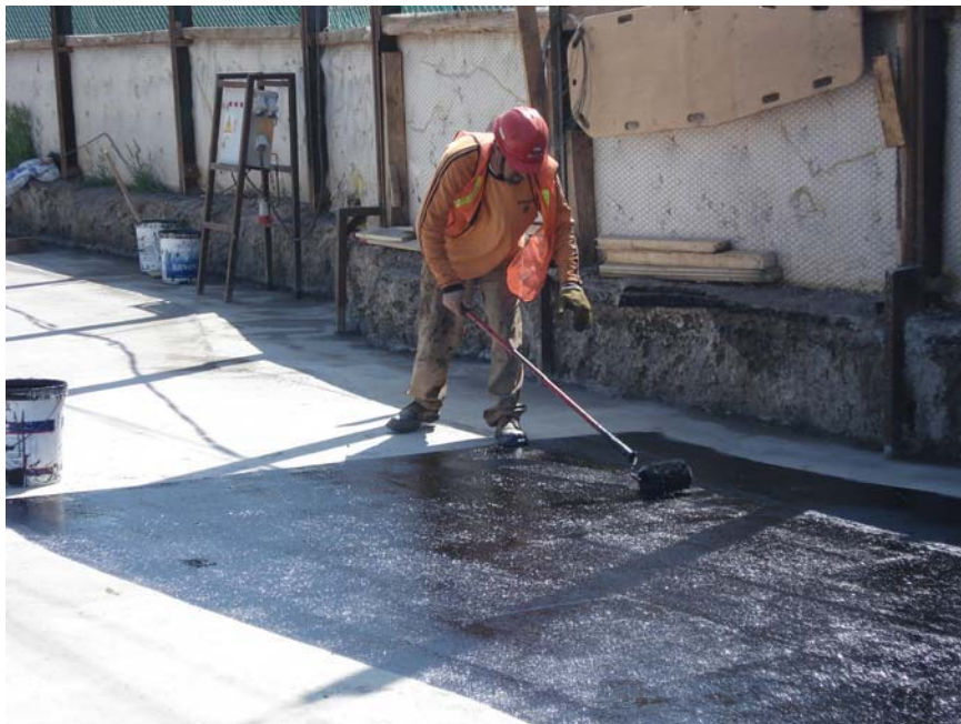
Fig. 2.3.21 Colocación de Imprimación Previa a la Membrana Impermeabilizadora en Losa Terminada.
