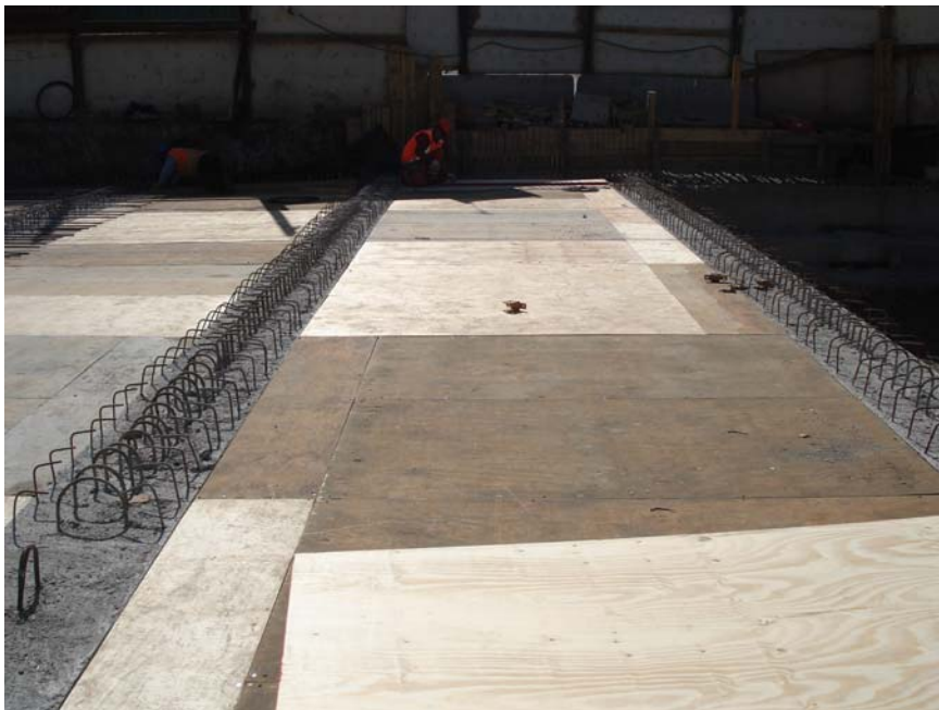
Fig. 2.3.3 Moldaje Inferior Losa entre Vigas Prefabricadas. Proceso terminado.
