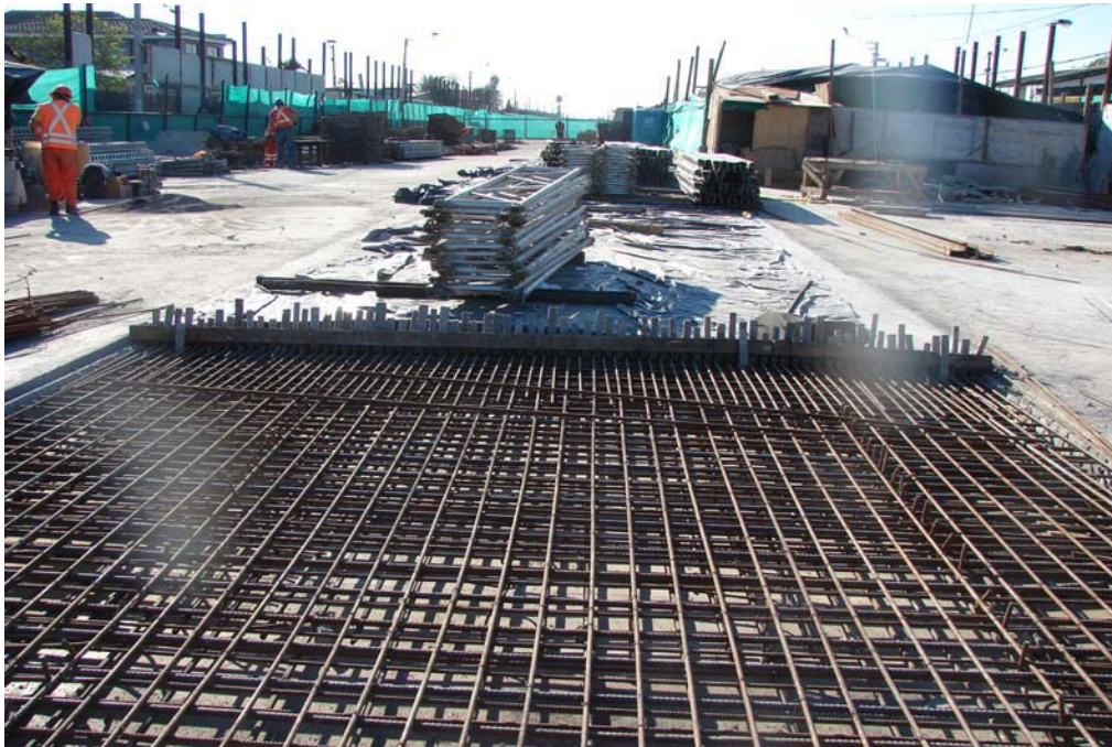
Fig. 6.1.3.6.6 Losas Poniente Hormigonadas hasta Pilote 269. Zona loseta de continuidad con revisión de armadura y en espera de ser hormigonada
