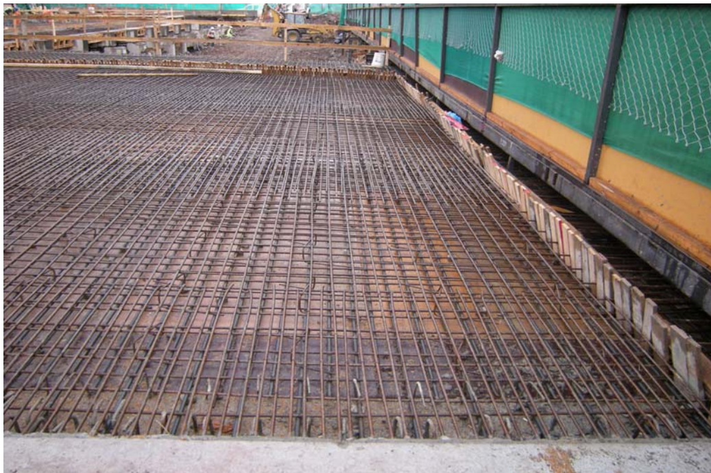
Fig. 6.1.3.2.4 Control Armaduras. Zona apoyo losa de control. Se aprecia también la pasarela peatonal ubicada sobre una zona de losa. Esta zona será hormigonada posteriormente.
