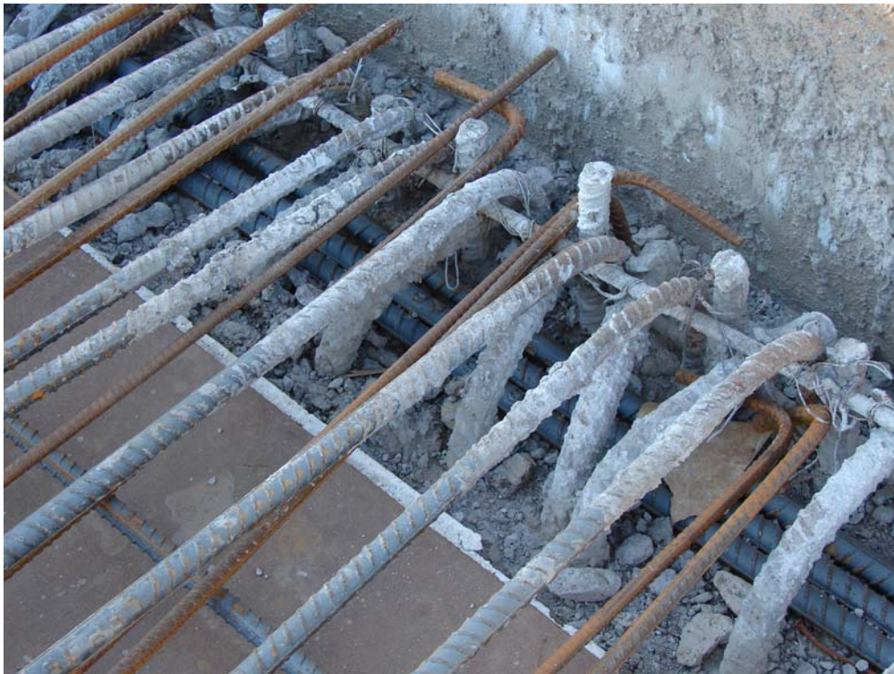
Fig. 6.1.3.6.4 Armaduras Conexión Losa-Pilotes. Redondos 18@10.
