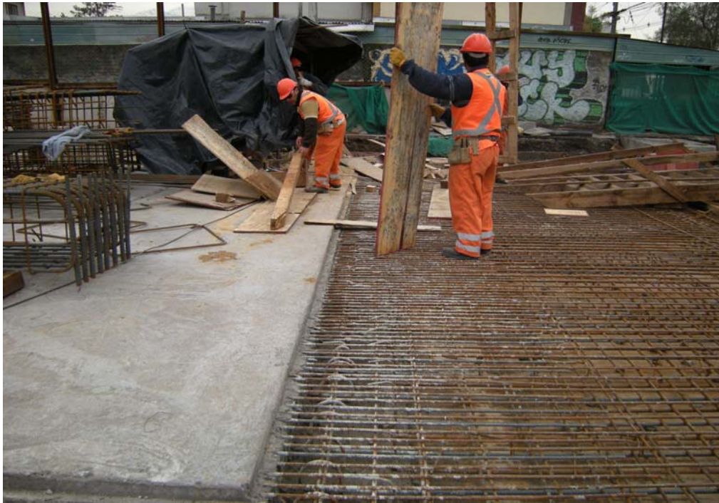
Fig. 6.1.3.7.20 Zona Final de Losas Tramo 3. Fin de los Trabajos de Hormigonado de Losas.
