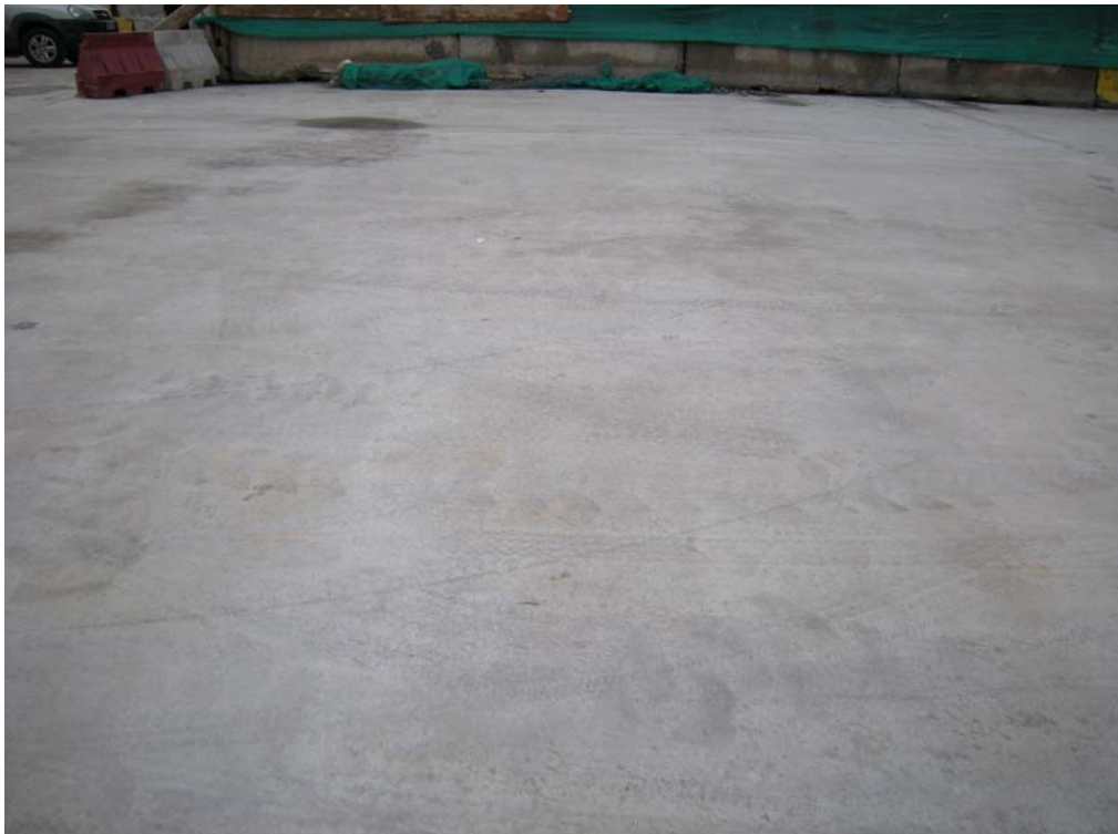
Fig. 6.1.3.7.6 Losa Zona Control 1. Acercamiento, buen estado sin fisuras.
