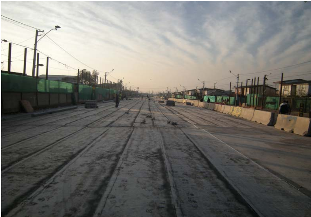
Fig. 6.1.3.11.7 Vista a Zona de Losa al Norte de la Zona de Control 1. Se aprecia trabajos de colocación de membrana.
