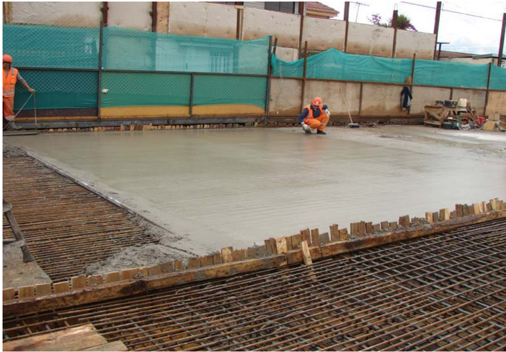
Fig. 6.1.3.3.11 Losa Zona Control 1 Hormigonada. Se hormigona en otra etapa la loseta de continuidad y en otra etapa diferente la zona de apoyo sobre pilotes extremos lado poniente.
