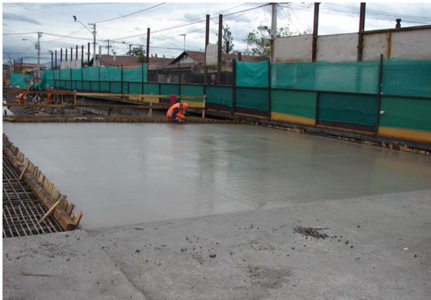
Fig. 2.3.19 Losa Terminada, Previa Colocación de Cubierta Protectora. Es importante señalar que se recomienda que el curado y la protección no deban terminar en forma abrupta. Si se deja que el hormigón nuevo se enfríe gradualmente durante el transcurso de varios días, la fluencia lenta puede reducir la posibilidad de fisuración cuando finalmente el curado y la protección se discontinúan por completo.
