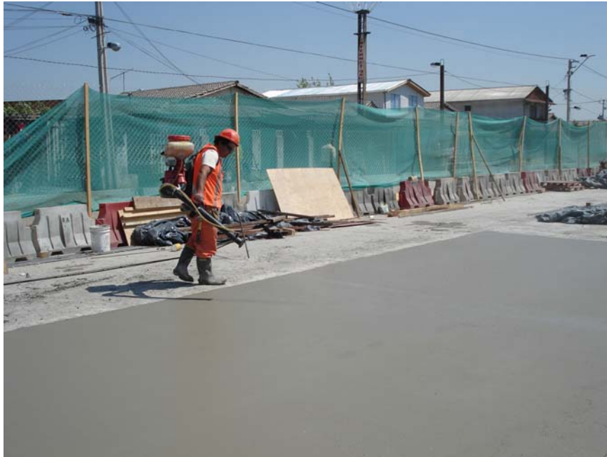
Fig. 2.3.16 Aplicación de Membrana de Curado en Hormigón (Se ha aplicado el producto PRO DUR32).
