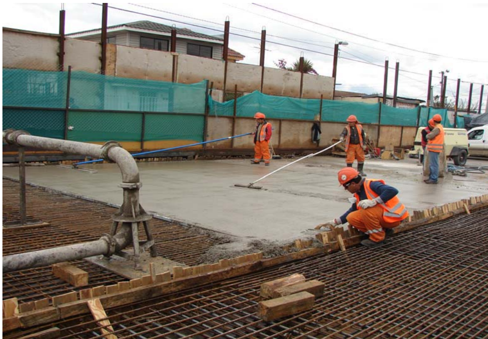
Fig. 6.1.3.3.10 Zona de Control 1. Se hormigona en tres sectores, de los cuales dos ya se encuentran terminados.
