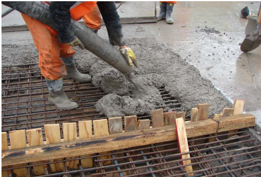
Fig. 2.3.11 Colocación del Hormigón en Zona de Junta de Construcción. Se aprecia el plano separación utilizado para materializar la junta de construcción.
