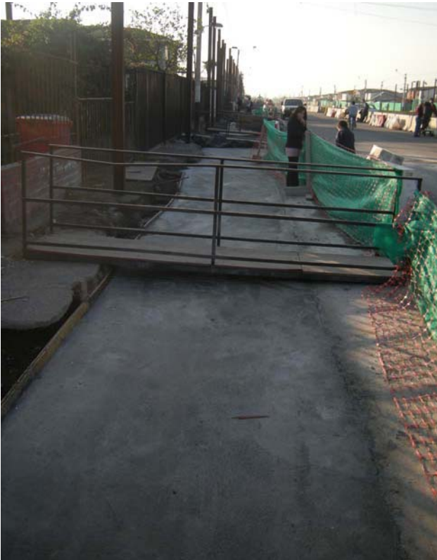
Fig. 6.1.3.13.5 Fin Losa Tramo 3. Losa en zona extrema, sobre pilotes. Hormigón reciente. Sin fisuras.
