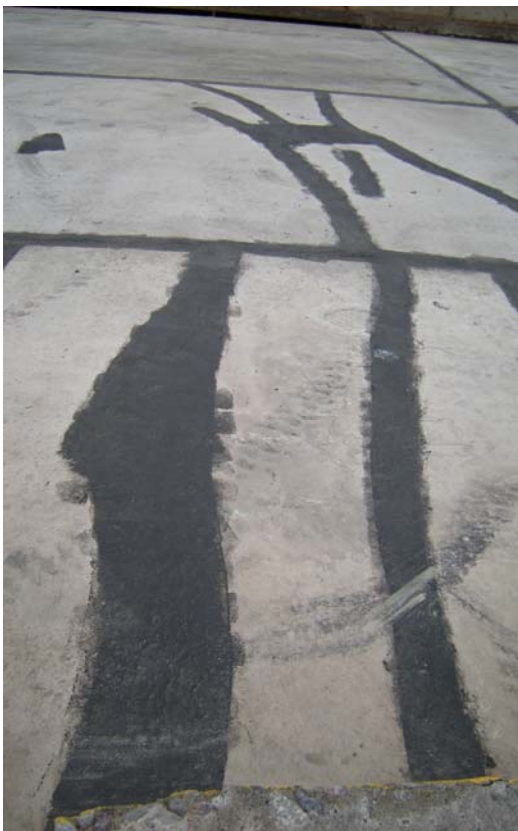
Fig. 6.1.3.7.15 Losas en Zona PK 1340, Entre Zona Control 1 y Calle Pedro Lira. Calzada poniente. Zona aislada con pocas fisuras. Se aprecia el sellado de las juntas de construcción.
