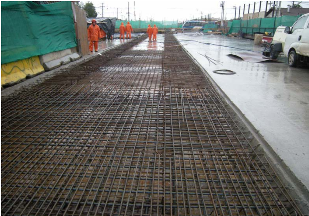
Fig. 6.1.3.5.8 Losa Aledaña hacia el Sur, Hormigonada. Sólo falta hormigón en loseta de continuidad y en zona de apoyo pilotes lado poniente. Al final se ve término tramo 3 de TS-8.
