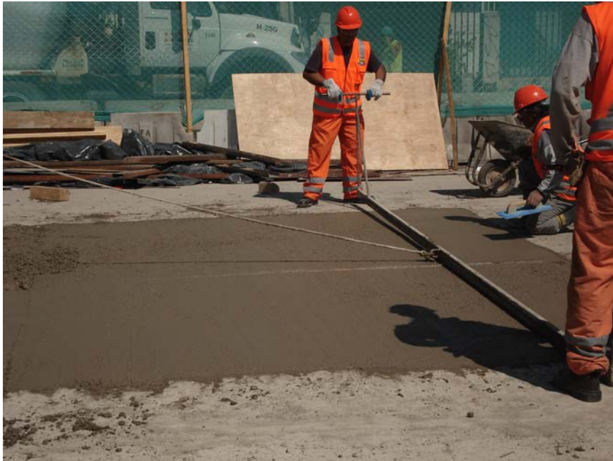
Fig. 2.3.14 Primer Alisado Superficial de Hormigón.
