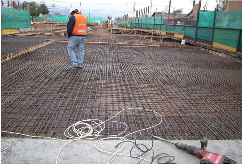
Fig. 6.1.3.2.3 Control Armaduras. Zona media losa de control.
