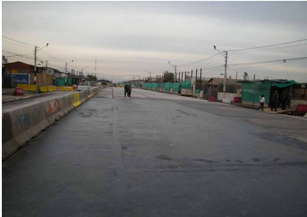
Fig. 6.1.3.7.1 Vista Avance Losas Aledañas.
