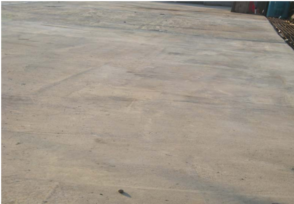
Fig. 6.1.3.13.8 Losa Oriente Fin Tramo 3. Aledaño Avenida San José de la Estrella. Detalle.
