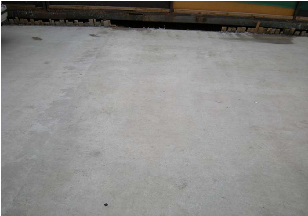
Fig. 6.1.3.7.9 Losa Zona Control 1. Acercamiento. Solo marcas sin fisuras.
