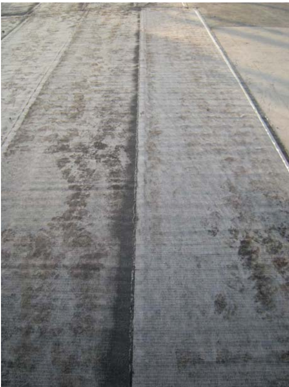
Fig. 6.1.3.11.7 Vista a Zona de Losa al Norte de la Zona de Control 1. Se aprecia trabajos de colocación de membrana.
