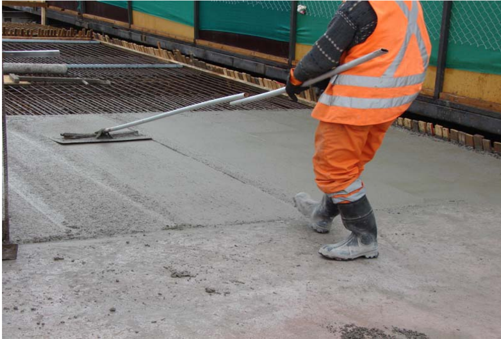
Fig. 6.1.3.3.7 Trabajo de Terminación del Hormigón. Es importante esta etapa por diversos motivos, primero para dejar una buena terminación superficial con el fin de no generar deformaciones que perjudiquen la colocación de la membrana impermeabilizante y también es importante porque permite sellar las fisuras que se generan en las primeras etapas del hormigón.
