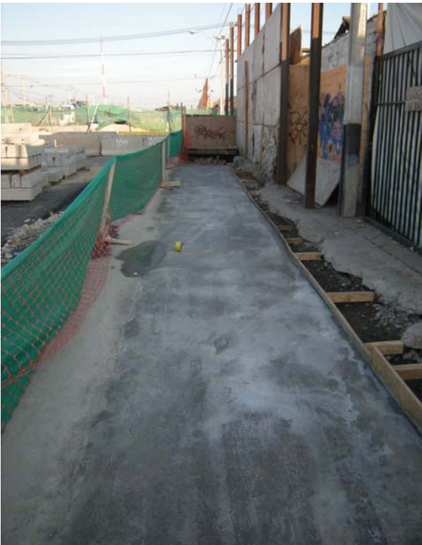
Fig. 6.1.3.13.6 Fin Losa Tramo 3. En zona extrema, sobre pilotes. Detalle.
