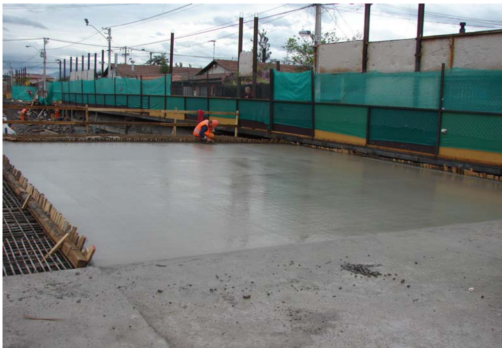
Fig. 6.1.3.3.12 Losa Central Terminada en Zona Control 1.
