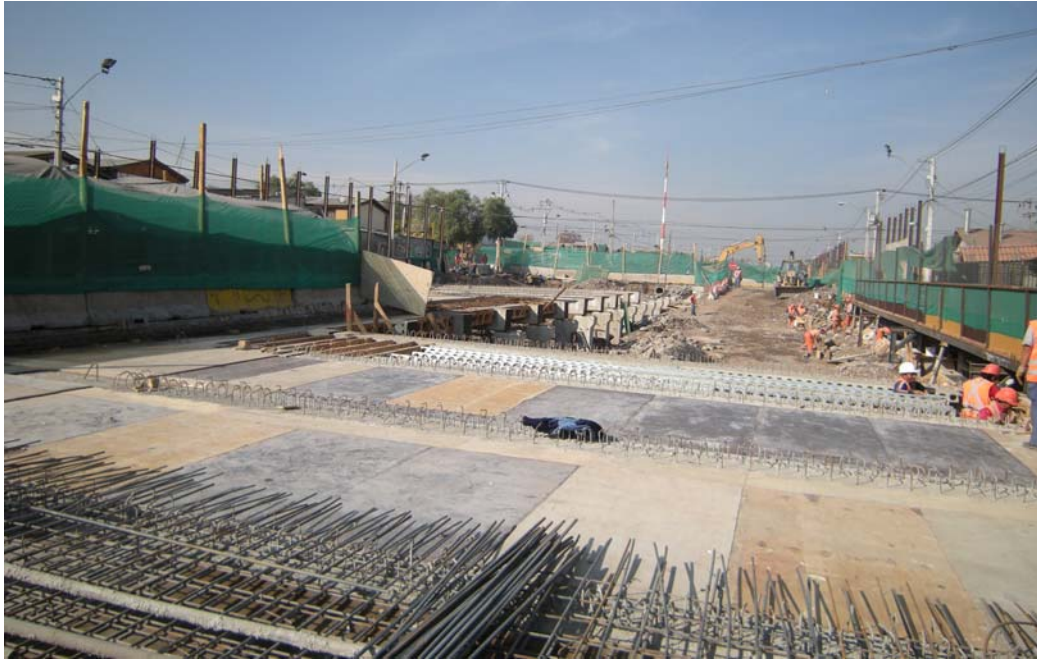
Fig. 6.1.3.1.3 Moldeo Losa Poniente, Zona Control 1. Esta es la zona de losa a controlar. Se aprecia solo la mitad de la losa sin armaduras y la otra mitad con la armadura puesta.
