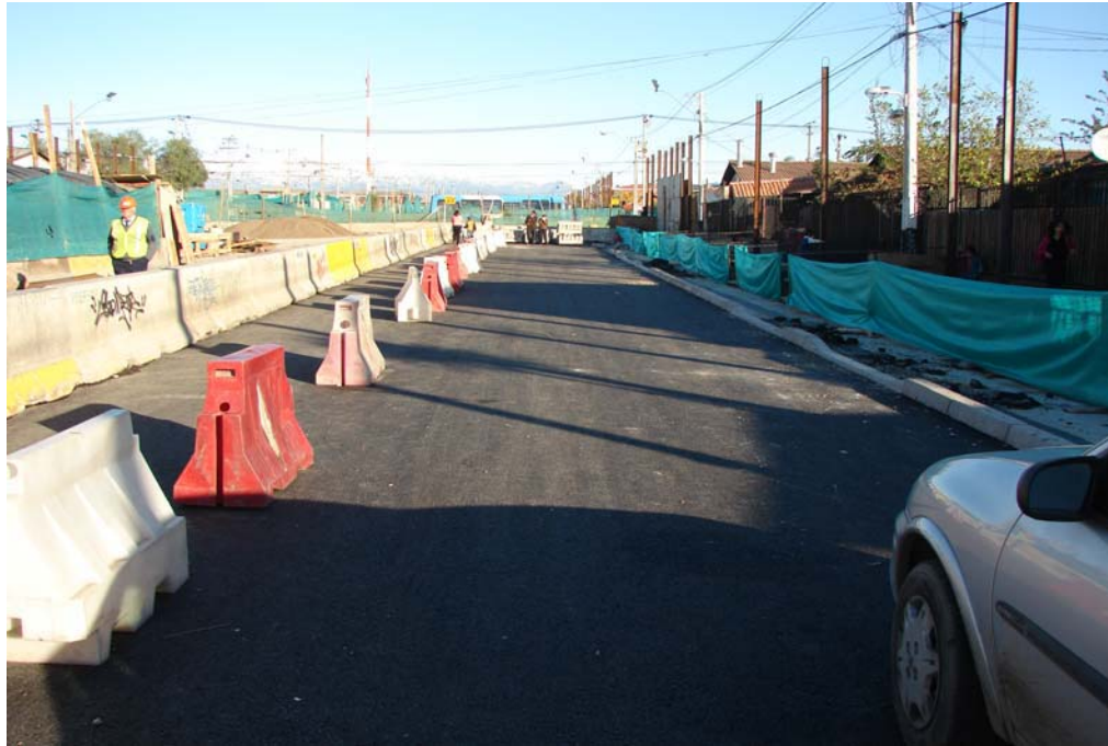
Fig. 6.1.3.12.1 Vista Zona Control 1. Se Aprecia con Membrana Impermeabilizante y Pavimento Colocado.
