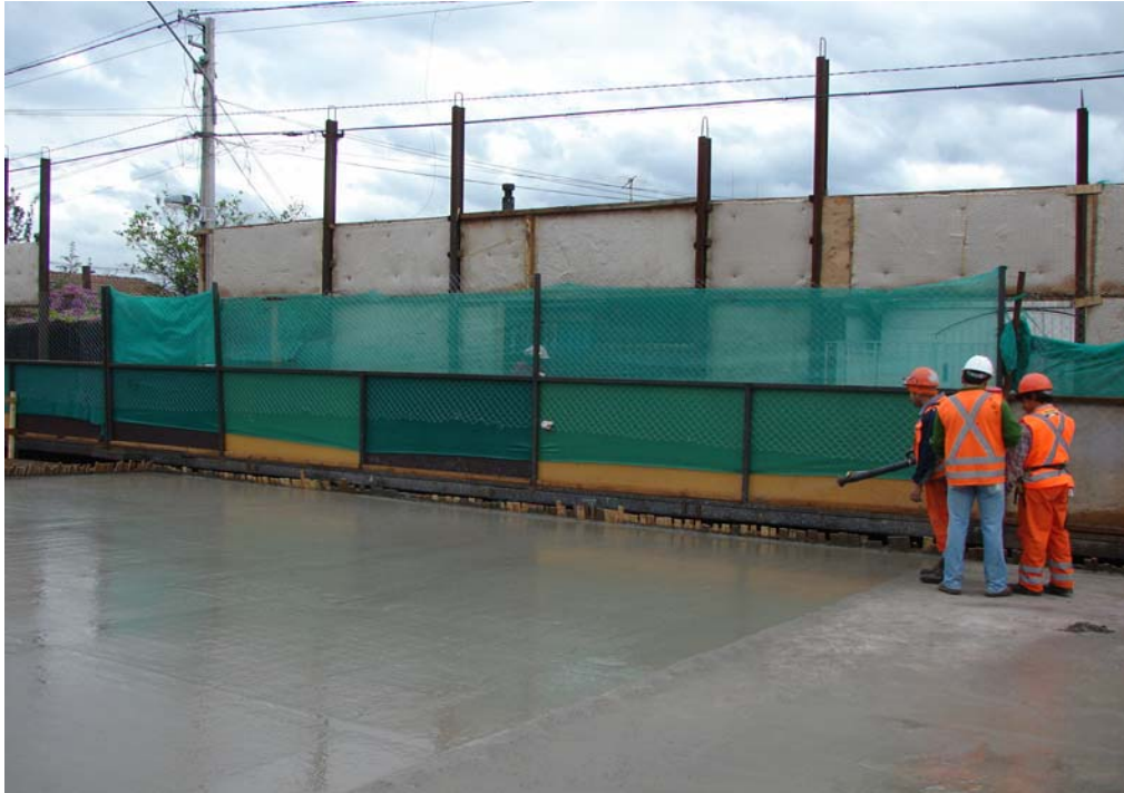
Fig. 6.1.3.3.13 Proceso Colocación Membrana de Curado. La colocación de membranas de curado es importante ya que estos procedimientos deberían asegurar la presencia de humedad suficiente para sostener la hidratación de la superficie del hormigón durante las primeras etapas de desarrollo de la resistencia.
