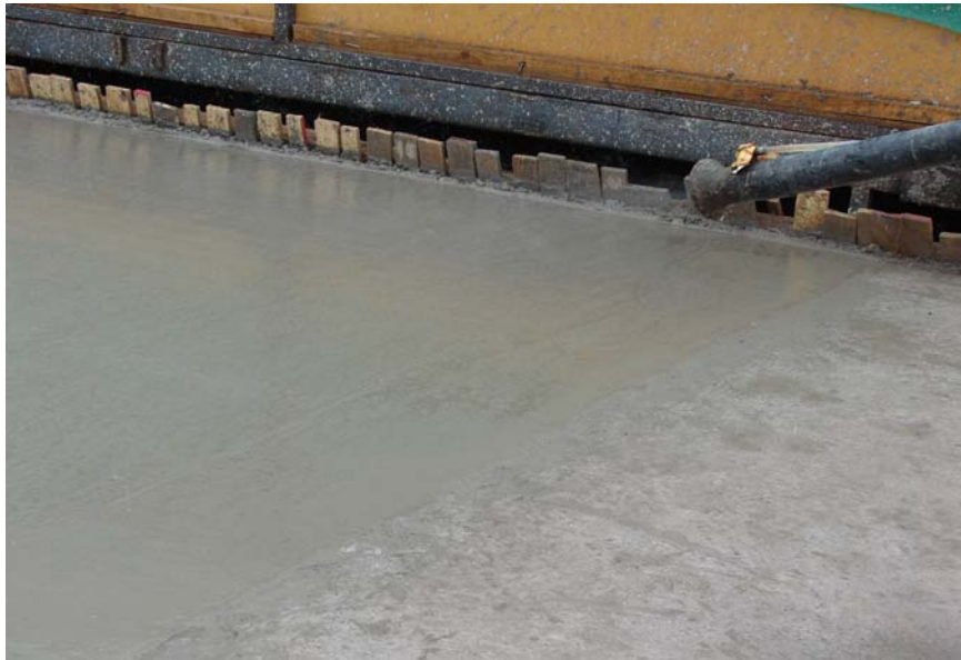
Fig. 2.3.18 Detalle en Aplicación de Membrana de Curado Mediante Aspersores.
