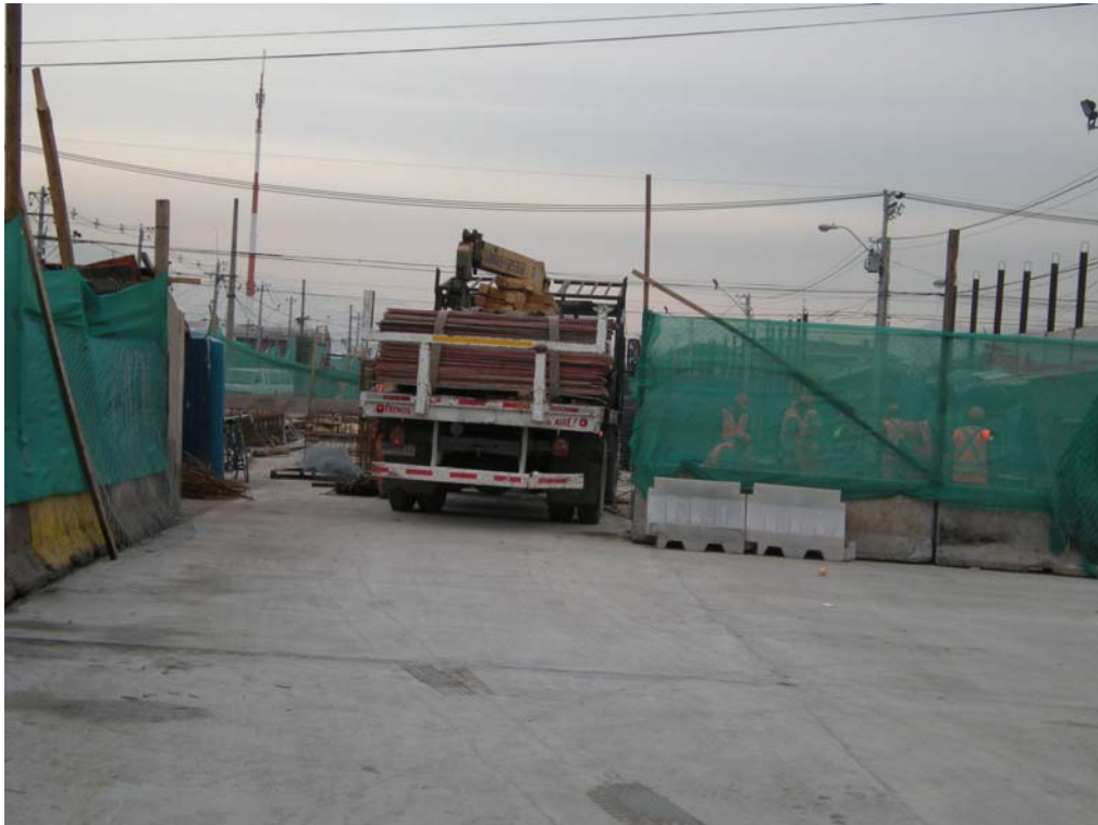
Fig. 6.1.3.7.11 Losas Aledañas Zona Control 1. En buen estado, no se aprecian fisuras. Se aprecia el movimiento normal de camiones para alimentar faena.
