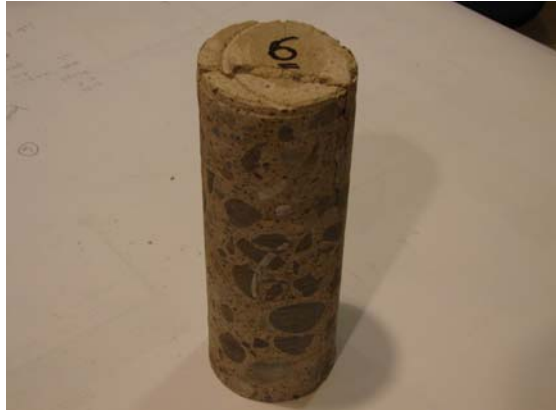
Fig. 7.1.1.1.2.3 Detalle de Testigo N°6, Fisura desde la cara Expuesta, Muy Dañada Producto del Proceso de Muestreo.
