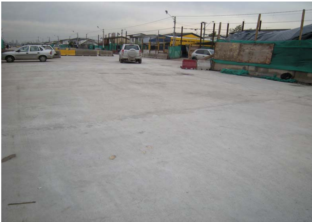
Fig. 6.1.3.7.10 Losas Aledañas Zona Control 1. Sin fisuras.
