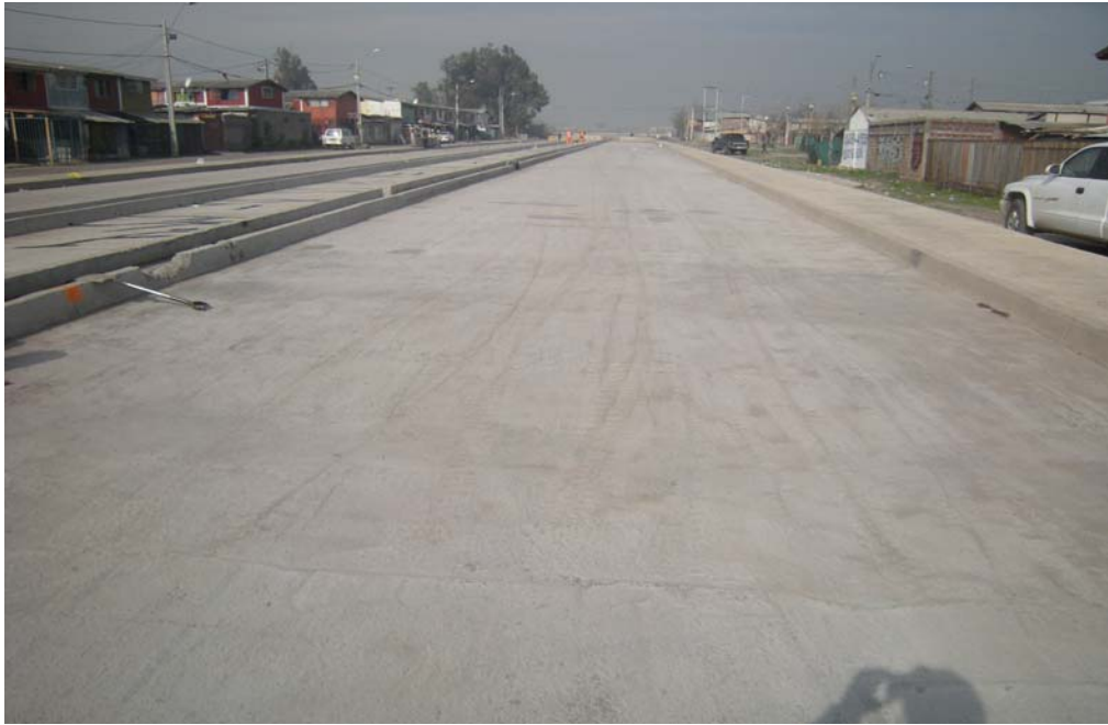
Fig. 6.1.3.10.1 Zona General Arriagada Vista al Sur. Sector de testeo calzada poniente. Zona hormigonada en los inicios del proyecto, años 2004-2005.
