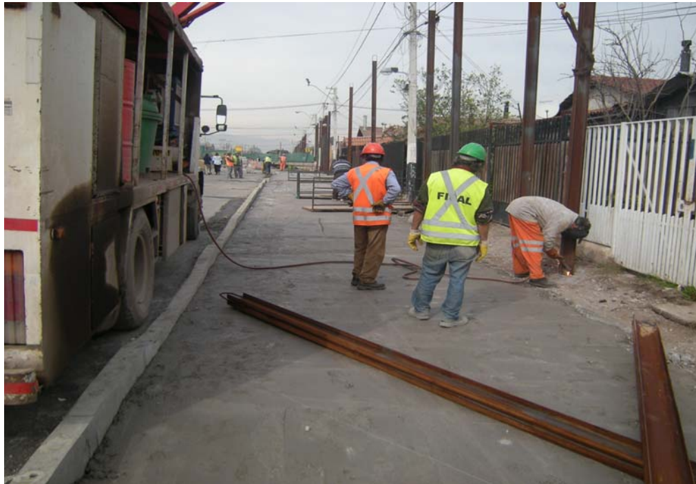
Fig. 6.1.3.14.1 Zona Control 1. Hormigón de regular calidad sobre losa en zona extrema de pilotes poniente.
