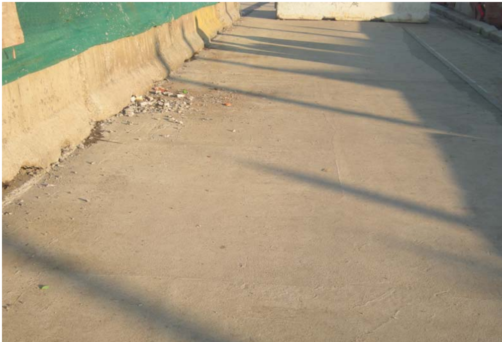
Fig. 6.1.3.13.4 Zona Control 1. Losa en zona de loseta continuidad sobre cepa. Detalle.
