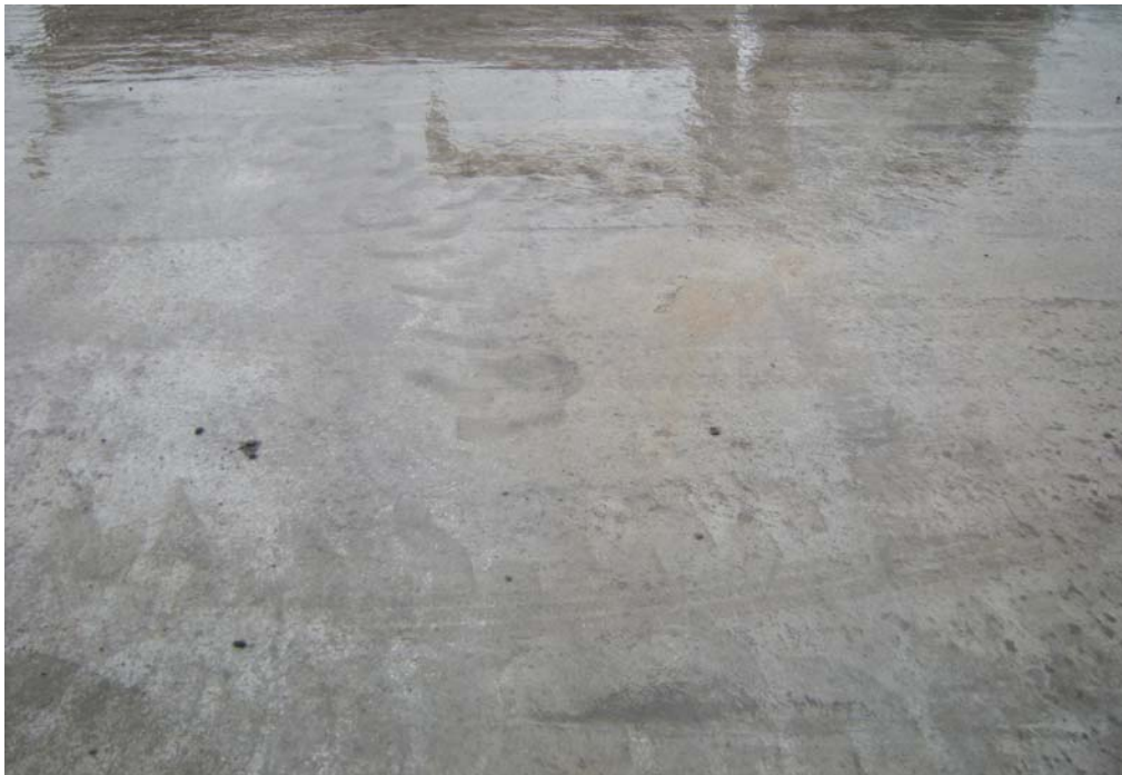
Fig. 6.1.3.5.4 Acercamiento Losa Central, Zona Control 1. No se aprecian fisuras.
