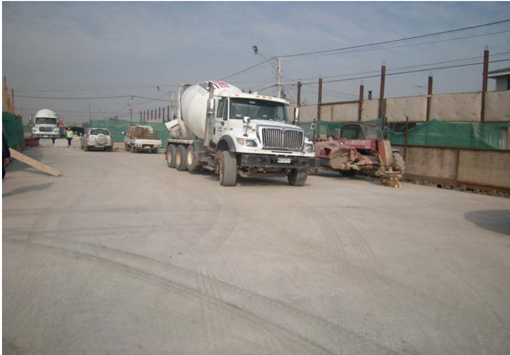
Fig. 6.1.3.8.1 Losa Zona Control 1. Se aprecia camión betonero. Sin problemas de fisuración.
