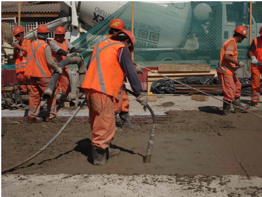
Fig. 2.3.13 Vibrado de Tramo de Losa. Es de vital importancia el proceso de vibrado del hormigón, ya que ayuda a evitar la aparición de fisuras provocadas por precipitaciones diferenciales alrededor de los encofrados o moldajes.
