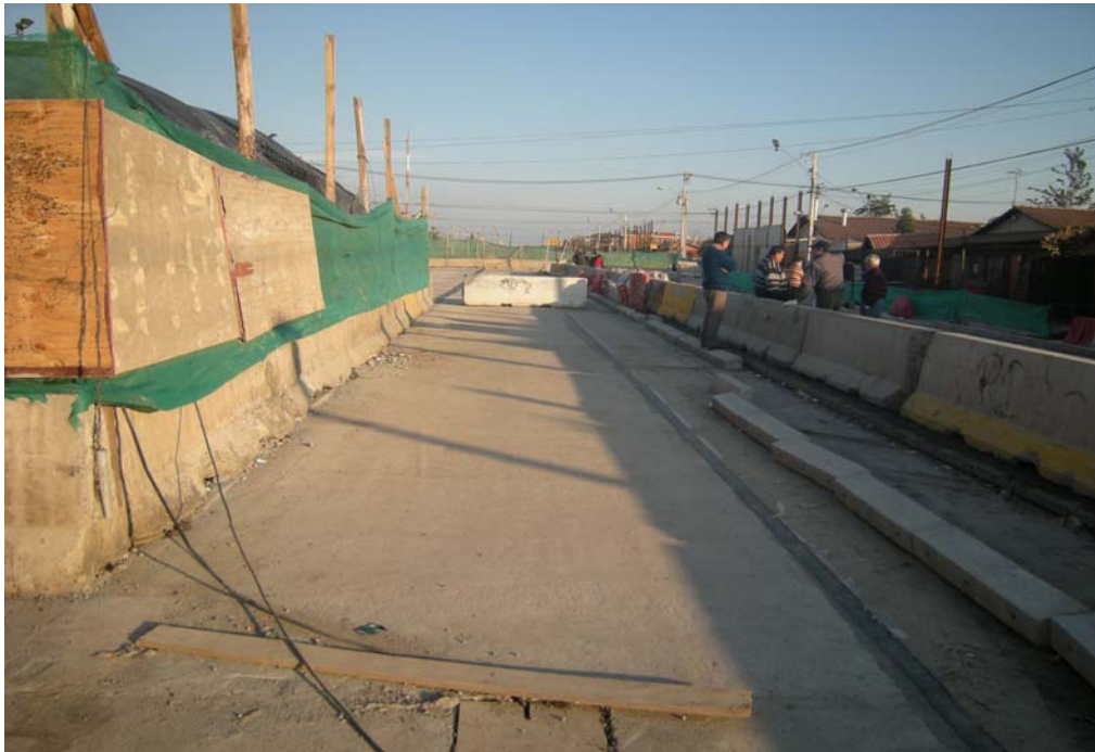
Fig. 6.1.3.13.3 Zona Control 1. Losa en zona de loseta continuidad sobre cepa. No presenta fisuras.
