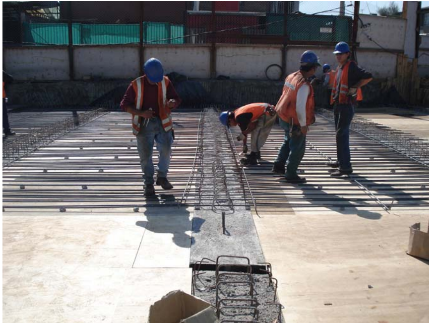
Fig. 2.3.4 Colocación Armaduras. Se aprecia el proceso de enfierrado de la losa.
