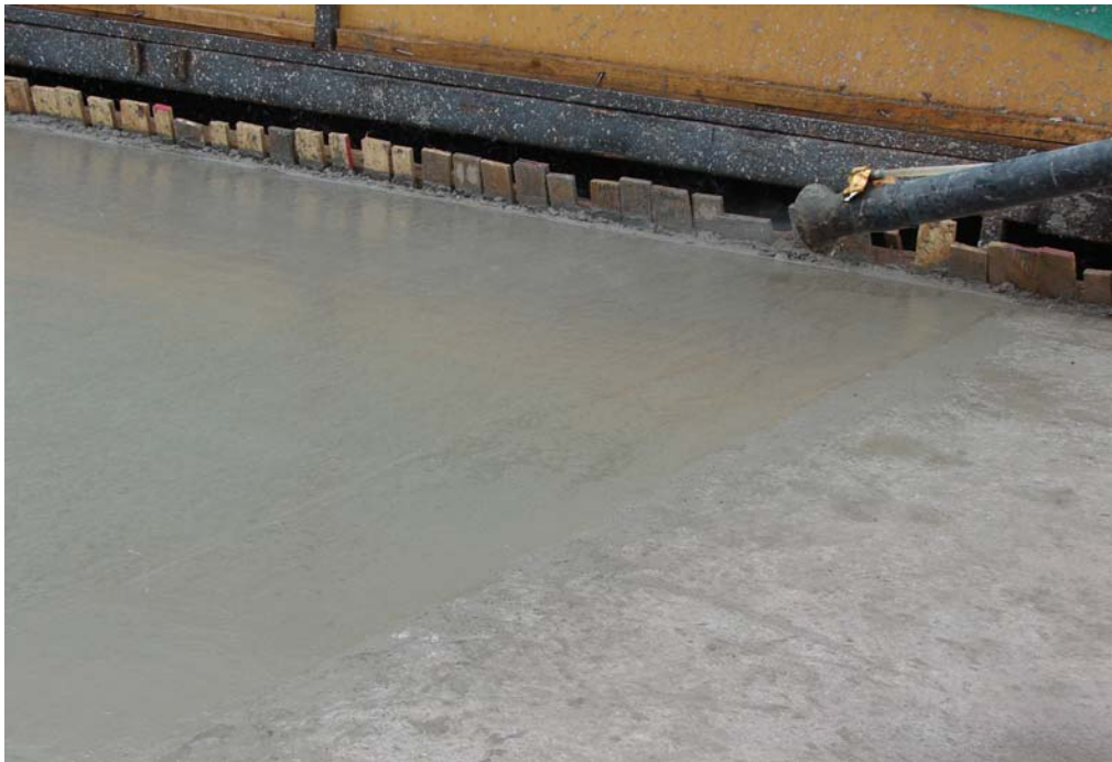
Fig. 6.1.3.3.14 Detalle Cambio Textura Superficial del Hormigón al Colocar la Membrana.
