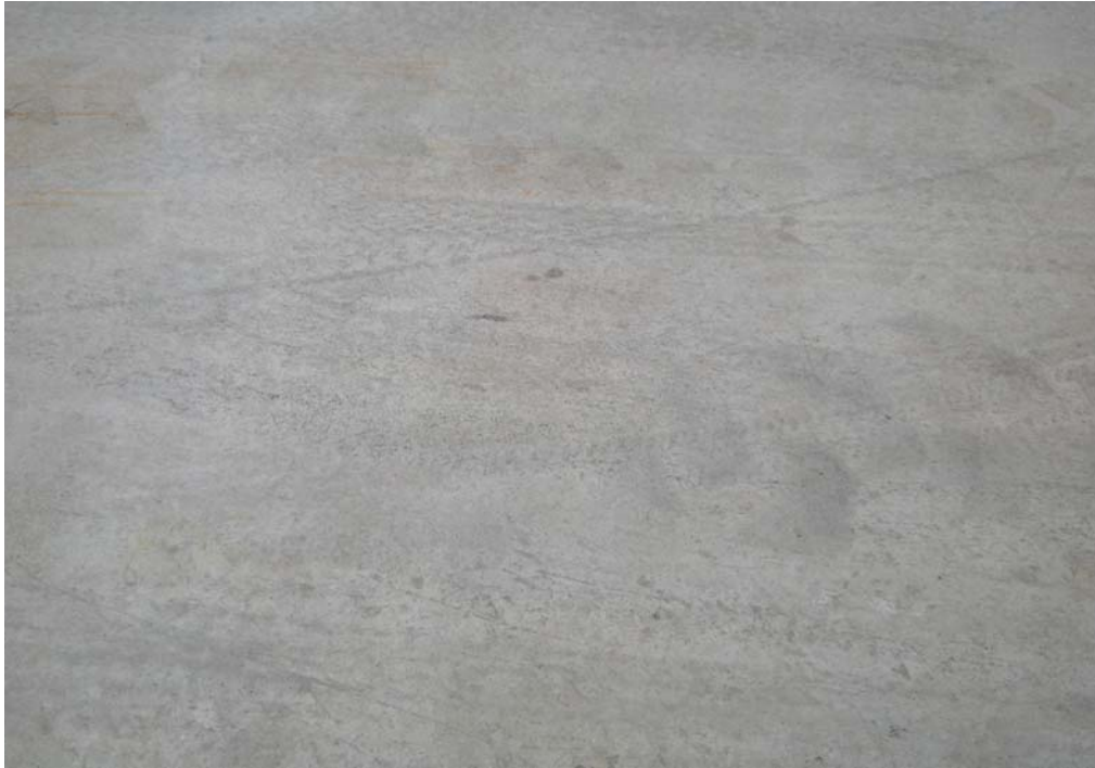
Fig. 6.1.3.7.7 Losa Zona Control 1. Acercamiento. Solo marcas sin fisuras.
