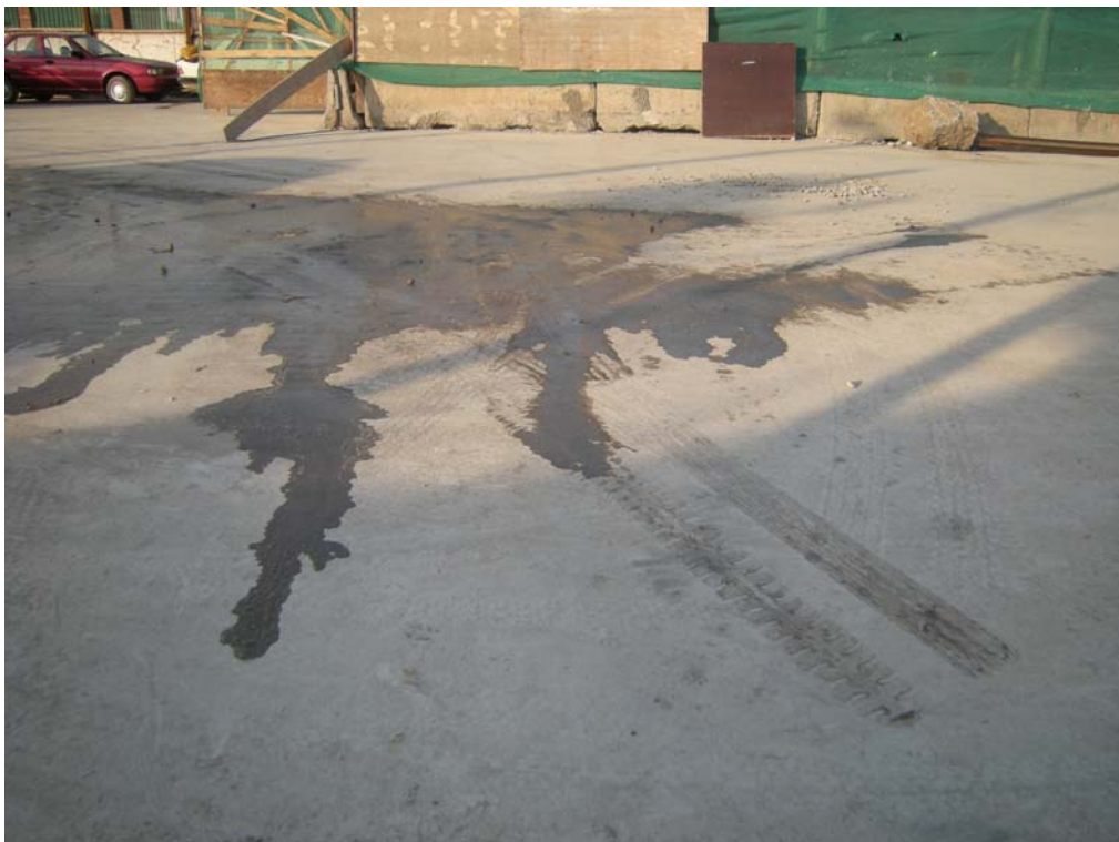
Fig. 6.1.3.11.4 Acercamiento Losa. No se aprecian fisuras, solo marcas de tránsito sobre la losa.
