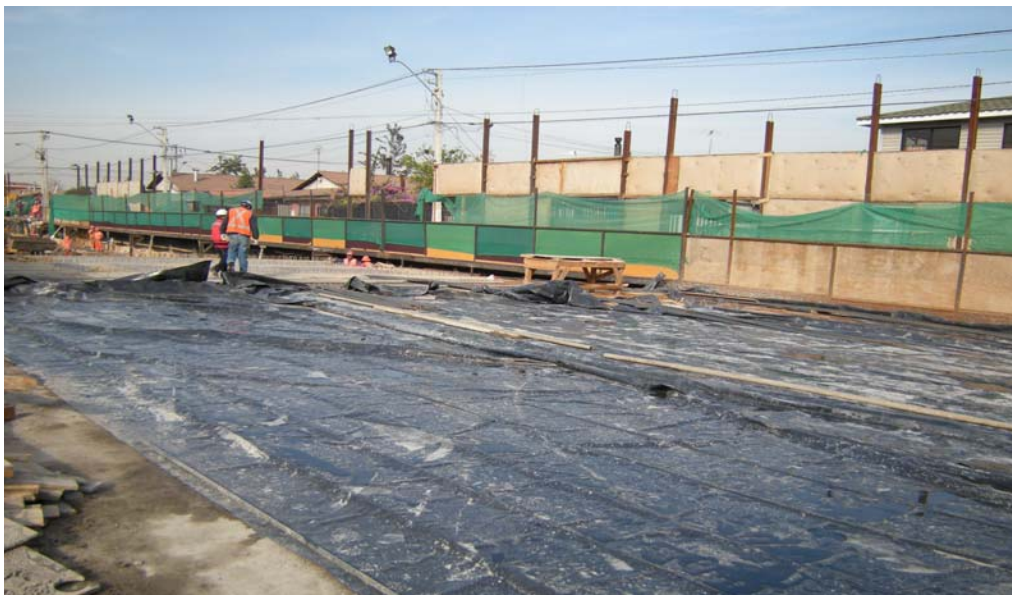
Fig. 6.1.3.1.2 Losa Recién Hormigonada el 15.05.08, Lado Poniente Aledaña a Zona Control 1. Esta losa ha sido hormigonada en forma completa, no en tramos como la losa en estudio.
