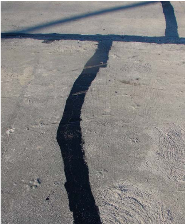
Fig. 6.1.3.6.7 Zona de Losa PK 1280 a 1340. Se aprecia trabajo de sellado de fisuras previo a la colocación de membrana. Zona con muy pocas fisuras.
