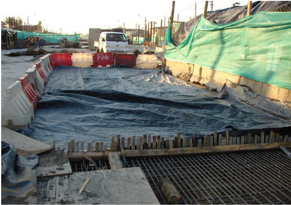
Fig. 6.1.3.4.3 Acercamiento Loseta de Continuidad. Esta zona fue hormigonada entre la primera vista y la efectuada al día de tomada la foto.
