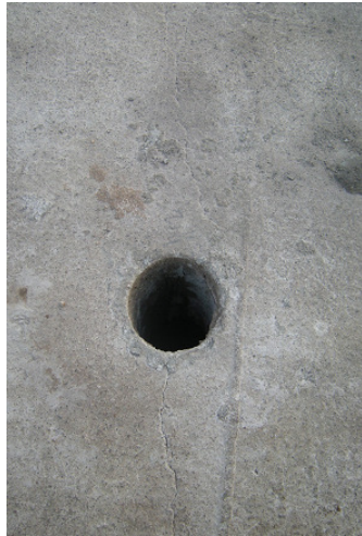
Fig. 7.1.1.1.1.4A Ampliación Zona Extracción Testigo N°2.
