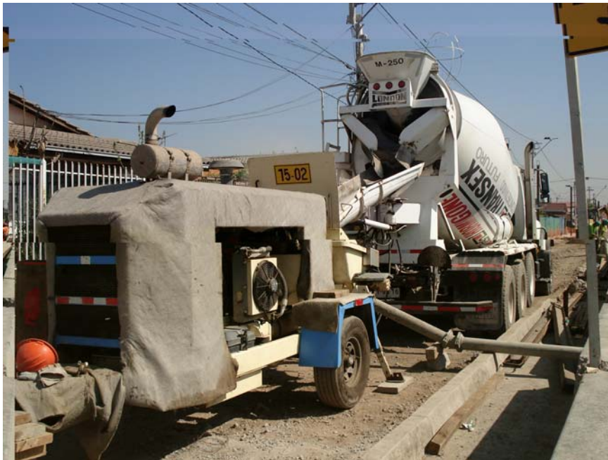
Fig. 2.3.8 Camión Mezclador descargando en Tolva de Bomba de Hormigón. La utilización de bombas es práctica común para la optimización del tiempo de colocación del hormigón en zonas con dificultad de acceso directo.
