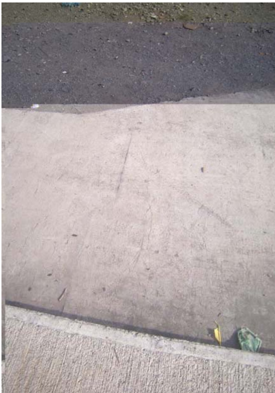
Fig. 6.1.3.10.7 Fisuras en el Sector, Comprometen toda la Losa. Incluyendo Sector sobre Pilotes.
