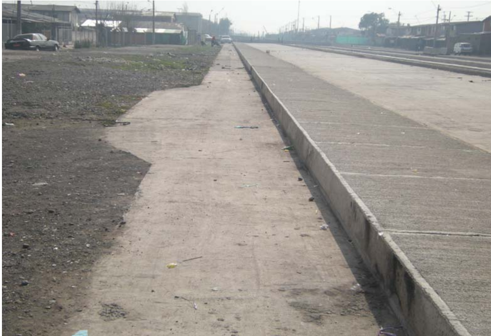
Fig. 6.1.3.10.7 Fisuras en el Sector, Comprometen toda la Losa. Incluyendo Sector sobre Pilotes.
