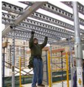
Figura 6.8: Encofrado horizontal EFCO DECK; Fuente: EFCO, Junio 2010.
