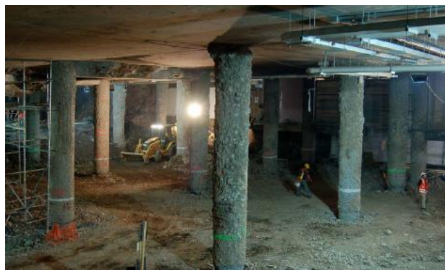
Figura 5.8: Método top-down; Fuente: Pilotes Terratest, Mayo 2010.
