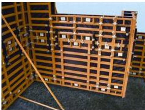
Figura 6.2 y 6.3: Encofrado y Apuntalamiento encofrado ORMA; Fuente: ULMA, Junio 2010.
