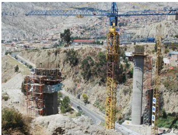
Figura 6.4: Encofrado deslizante
