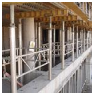
Figura 6.9: Encofrado horizontal EFCO E-Z DECK; Fuente: EFCO, Junio 2010.
