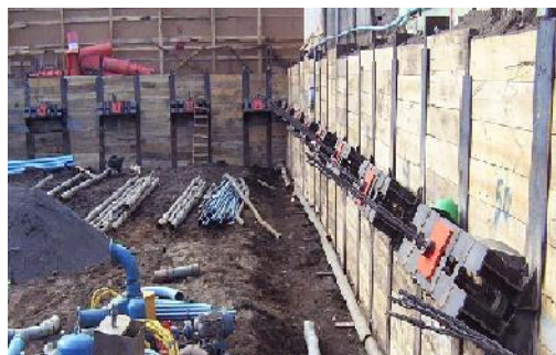
Figura 5.4: Fotografía muro berlinés edificio Chacabuco; Fuente: Pilotes Terratest, Junio 2010.
