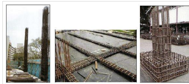
Figura 7.5: Armaduras para columnas, vigas y fundaciones prefabricadas; Fuente: memoria 2 (referencias)
