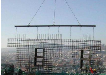
Figura 7.4: Armadura prefabricada para muro; Fuente: memoria 2 (referencias)
