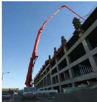
Figura 9.2: Bomba Pluma; Fuente: Putzmeister Ibérica S.A.
