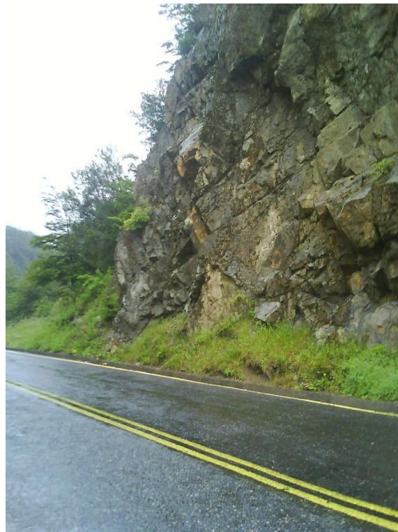
Fotografía 3.15 Sector 14 de medición estructural. Vista hacia el WNW.
