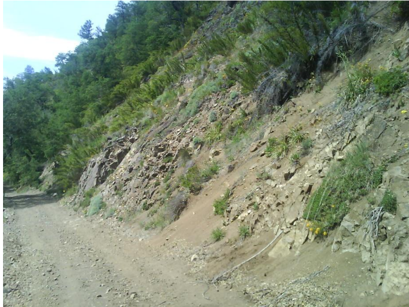
Fotografía 3.1 Sector 1 de medición estructural. Vista hacia el NNE.
