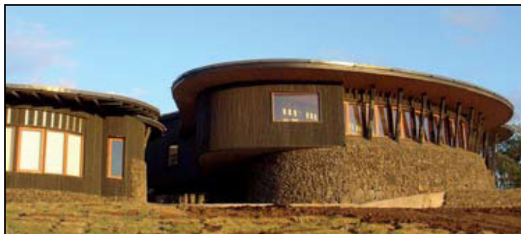
Figura 2.10 Zócalo perimetral en piedra volcánica.
