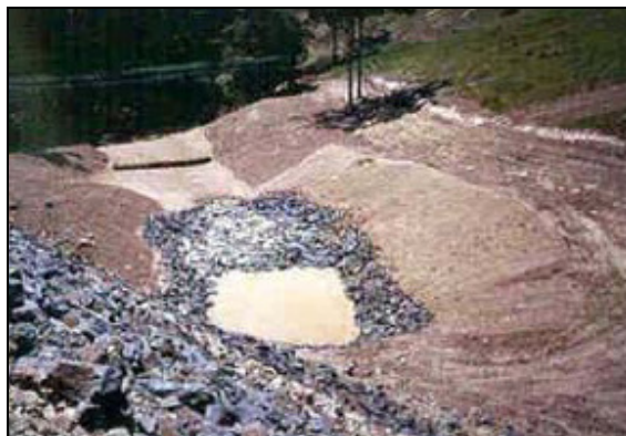
Figura 3.4 Presa de Retención.
