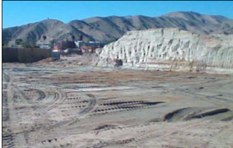
Figura 2.1 Terreno recuperado para la construcción.
