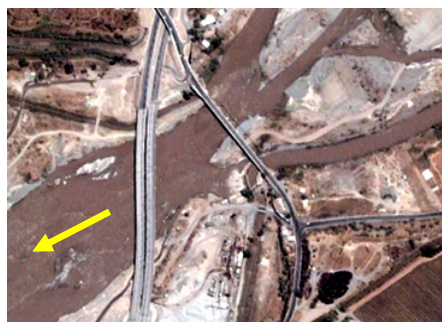
Puente Los Morros Puente Acceso Sur
