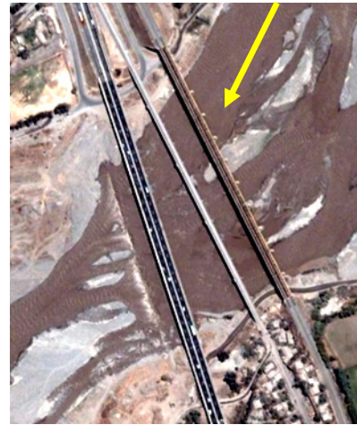
Puente de tren sobre el Maipo
