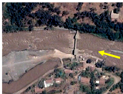
Bocatoma Canal "Pirque / Sirena".
