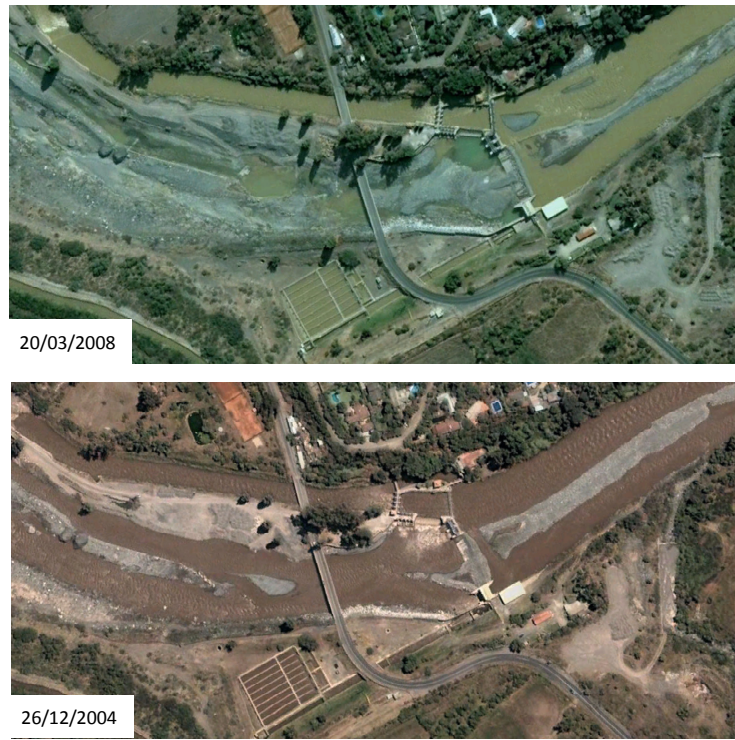
Figura 4.12 Bocatoma San Carlos e Independiente (estiaje y crecida de verano)
