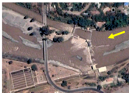
Bocatoma Canal "San Carlos".
