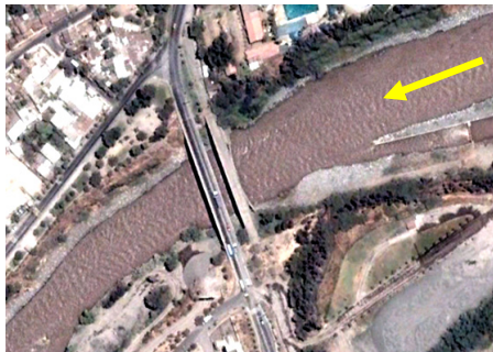
Puente Concha y Toro
