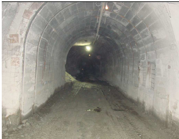
Fotografía A1: Bóveda de hormigón en calles recuperadas
