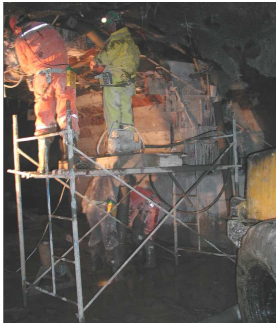
Fotografía 12. Reparación de muros guía
