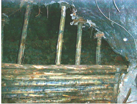
Fotografía 11. Reparación de viseras mediante "monos"
