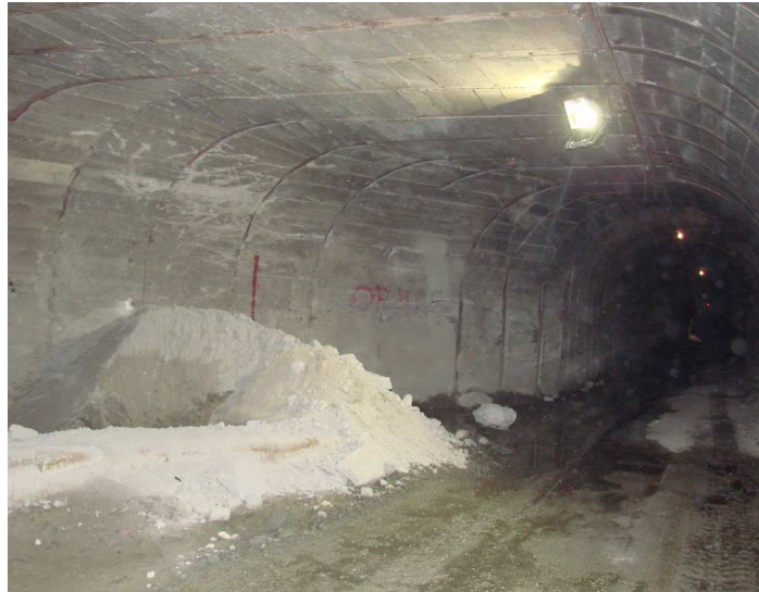
Fotografía A2: Bóveda de hormigón en punto de vaciado.
