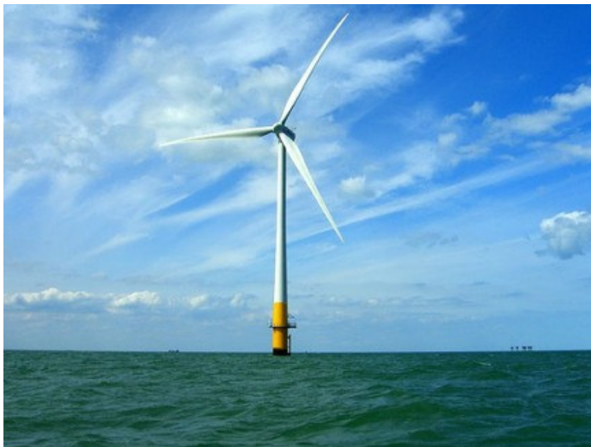
Figura 2.3: Aerogenerador instalado en el mar, nivel de rugosidad 0.
