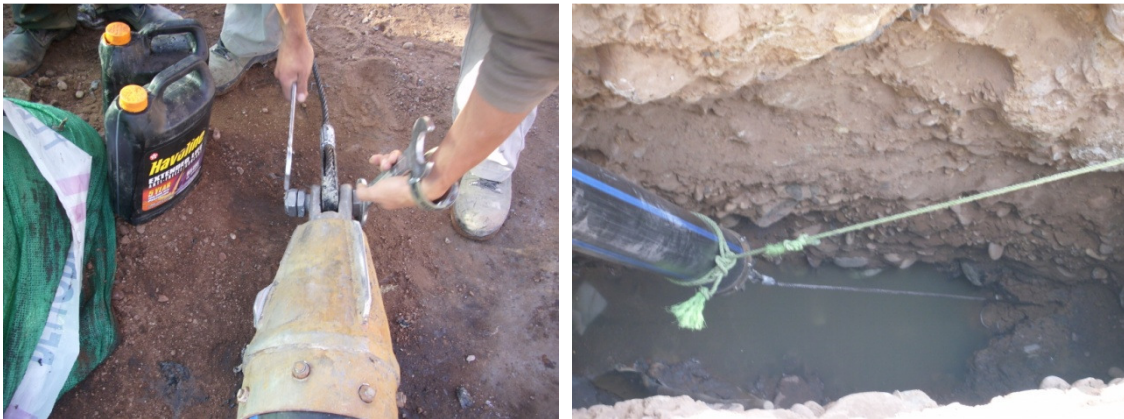
Figura 4-16: Apernado del winche con la cabeza cortadora (izquierda), posicionamiento de la tubería (derecha).
