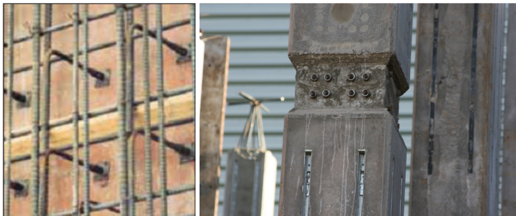
Figura 6-12: Ejemplo de utilización de conectores espigados
