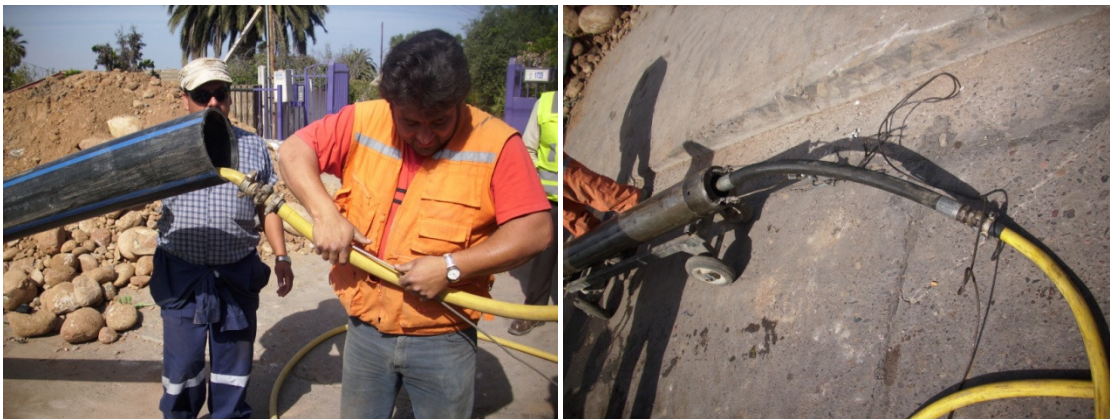
Figura 4-14: Instalación tubería hidráulica y conexión martinete dinámico.
