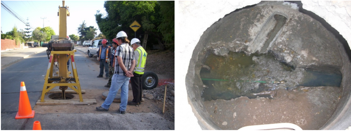
Figura 4-15: Winche en el pique de salida (izquierda), extremo del winche en el pique de entrada (derecha).
