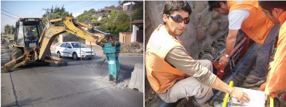
Figura 4-13: Rotura pavimento existente y termo-fusionado HDPE.
