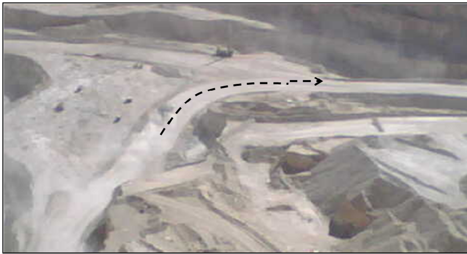
Ilustración 21: Ejemplo de curva en rampa
