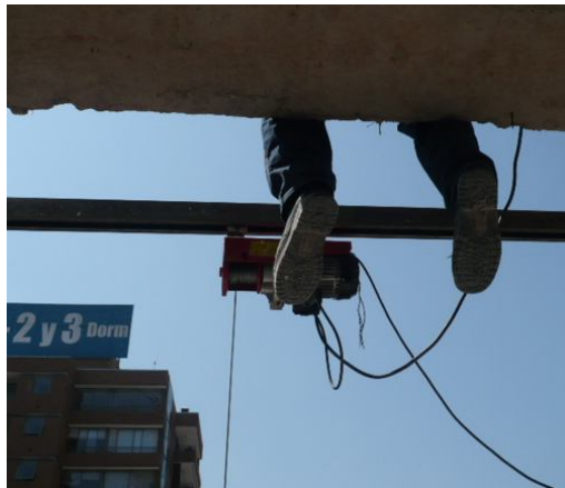
Figura 4-1. Sistema de riel corredizo tradicional
