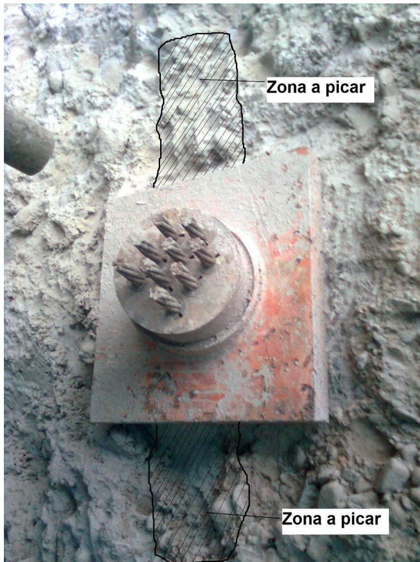
Figura 2.36 Esquematación frontal de propuesta sin hombro de anclaje.
