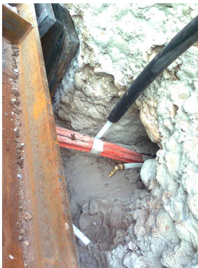
Figura 2.25 Vista lateral viga de apoyo.
