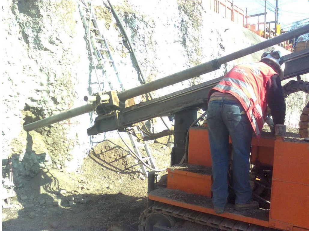
Figura 2.18 Perforación para anclaje
