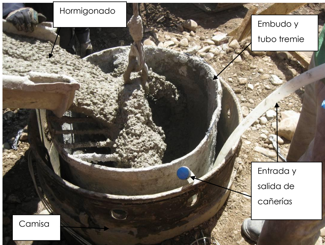
Figura 2.12 Hormigonado de la PE.
