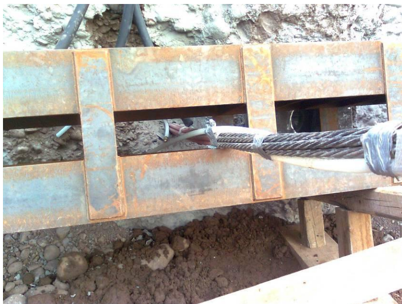
Figura 2.24 Vista frontal viga de apoyo.
