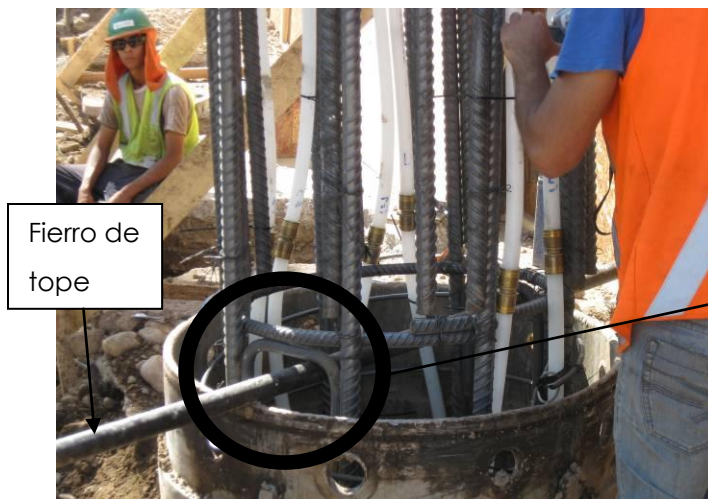
Figura 2.9 Asa soldada en cuerpo inferior de armadura.
