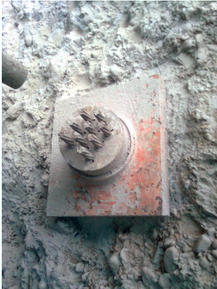
Figura 2.23 Cabeza de anclaje utilizada en proyecto Beauchef Poniente.
