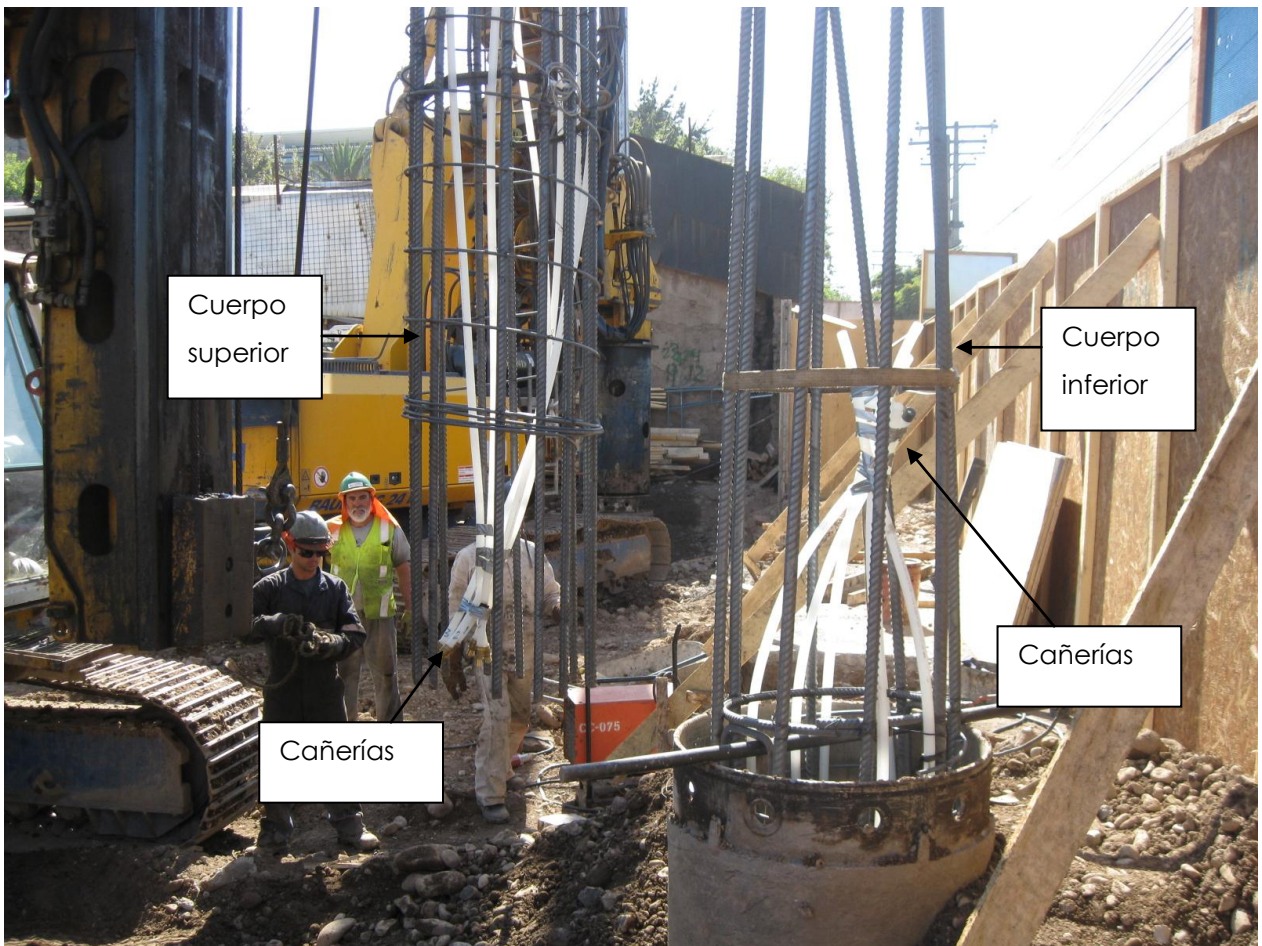
Figura 2.11 Maquina pilotera colocando cuerpo superior de la armadura de la PE101.
