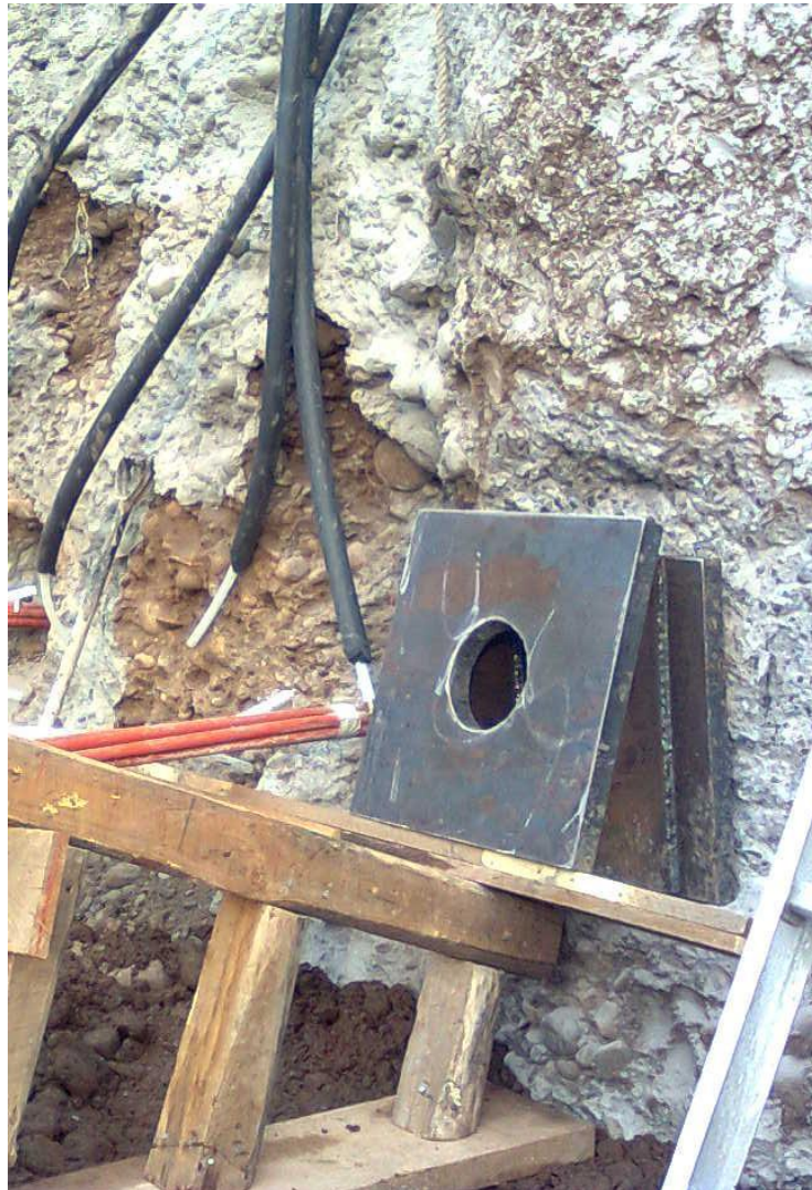
Figura 2.34 Apoyo de anclaje utilizado en esta ocasión como apoyo para la viga.
