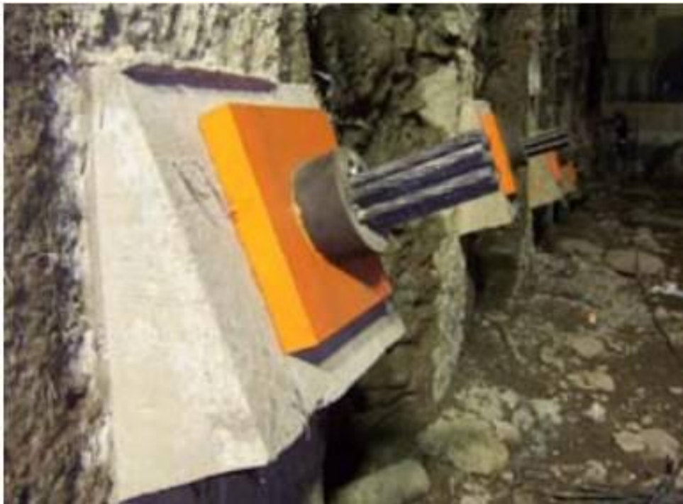
Figura 2.32 Hombro de apoyo utilizado en anclaje de una Pila.
