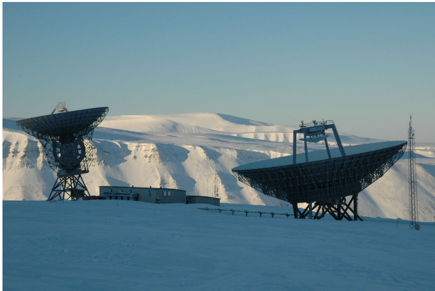
Figura 2.5: Conjunto de antenas ubicadas en Longyearbyen, Svalbard, Noruega. A la izquierda la antena parabólica de 32 m de diámetro, y a la derecha la antena fija de 42 m de diámetro. Foto: Tom Grydeland
