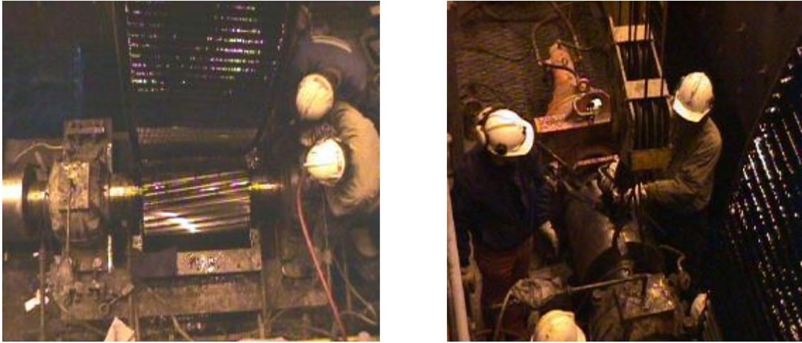
**Figura 12-2. Proceso de desplazamiento de descansos e instalación de laines.**
