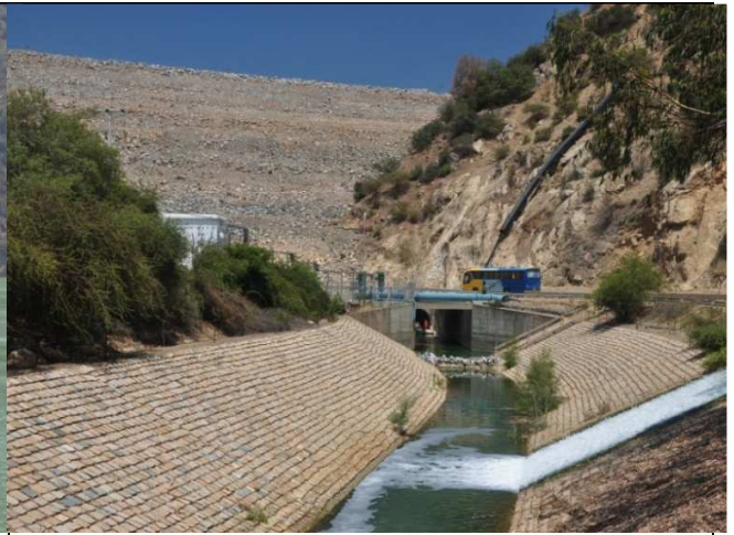
Figura C.7: Descarga desde el tranque de relaves al estero Carén.
