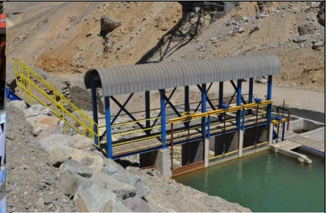
Figura C.4: Bocatoma Coya bajo, de la DET
