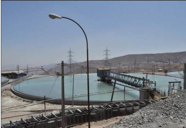
Figura C.10: Espesadores de relaves del sector Colón.
