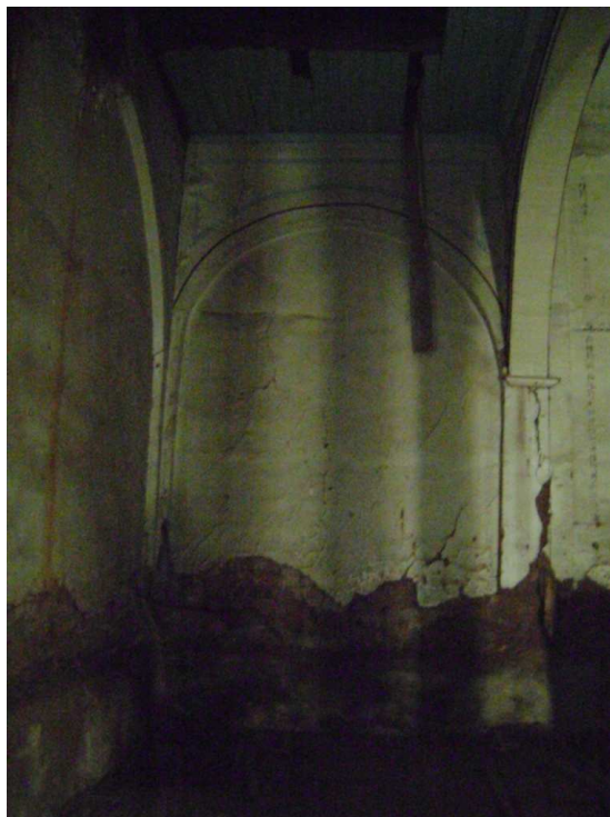
Ilustración 3.4.19. Vano de muro en eje 1 entre ejes C y D.
