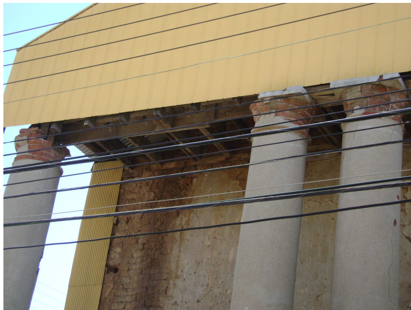
Ilustración 3.4.5. Fotografía capiteles columnas de fachada
