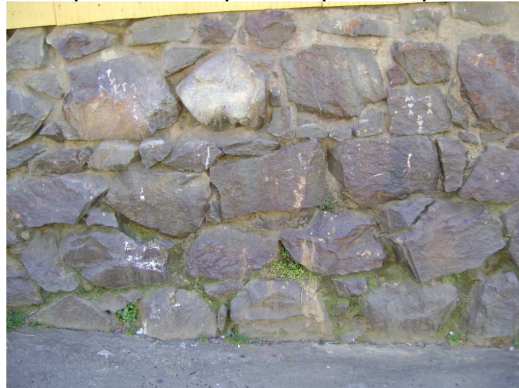
Ilustración 3.4.8. Estado de mampostería de piedra que compone cimiento.
