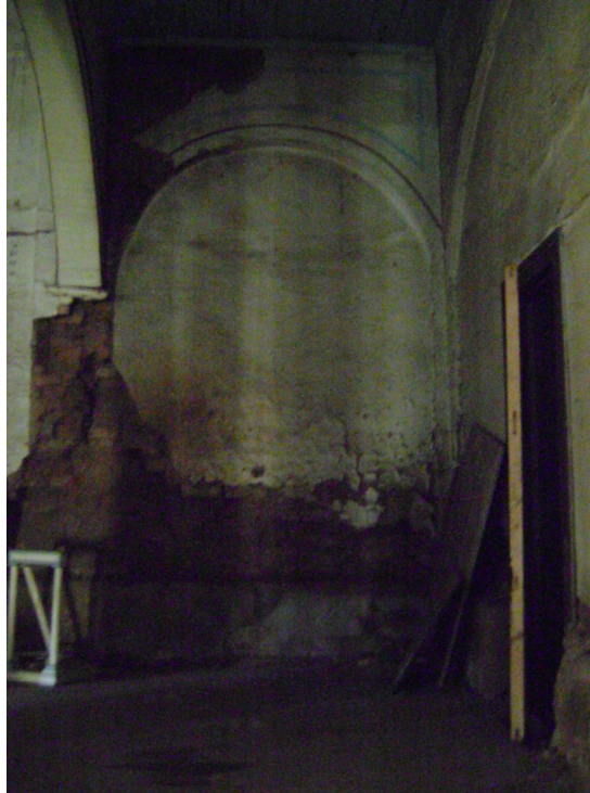
Ilustración 3.4.17. Vano de muro en eje 1 entre ejes A y B.
