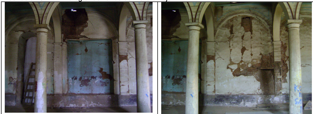
Fuente propia. A la izquierda vano entre ejes 4 y 5, a la derecha vano entre eje 5 y 6.
