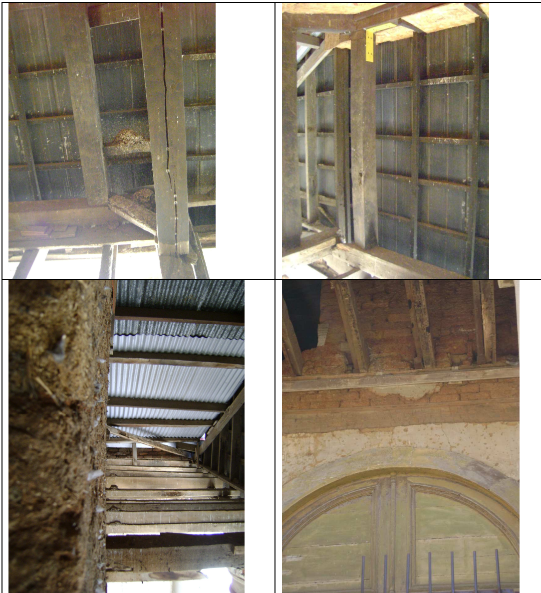
Envigado del atrio. Fuente propia.
