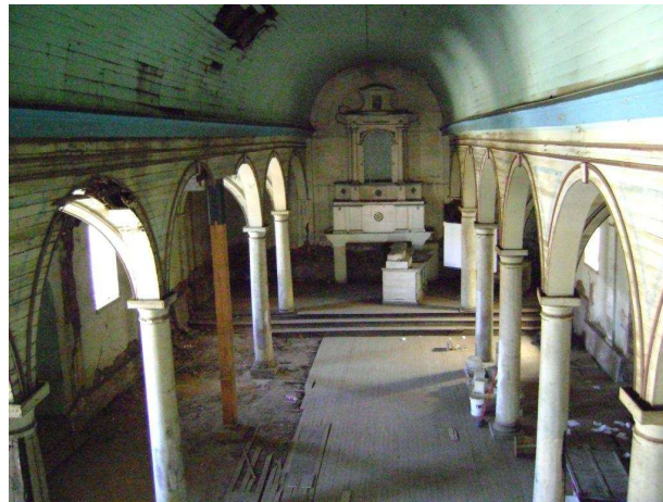
Ilustración 3.4.2. Fotografía desde el coro al interior de la iglesia.
