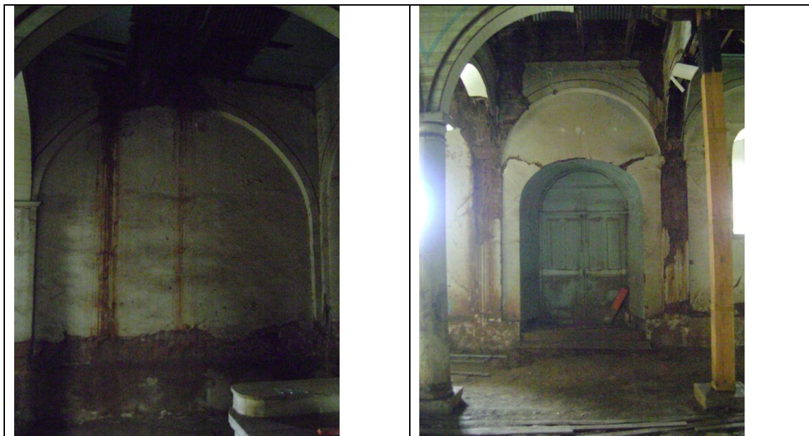
Ilustración 3.4.14. Fotografías vanos de muro de eje D
