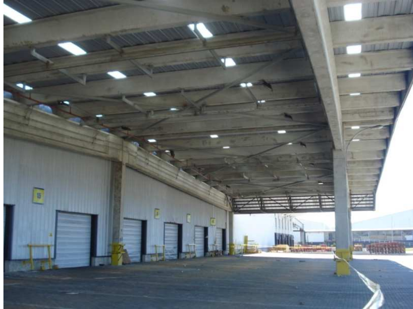
Figura 4.6: Vista general de la estructura
