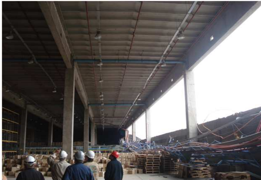
Figura 4.1: Vista general de la estructura
