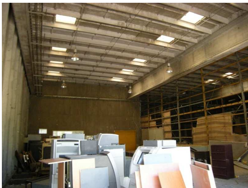
Figura 4.15: Vista general de la estructura
