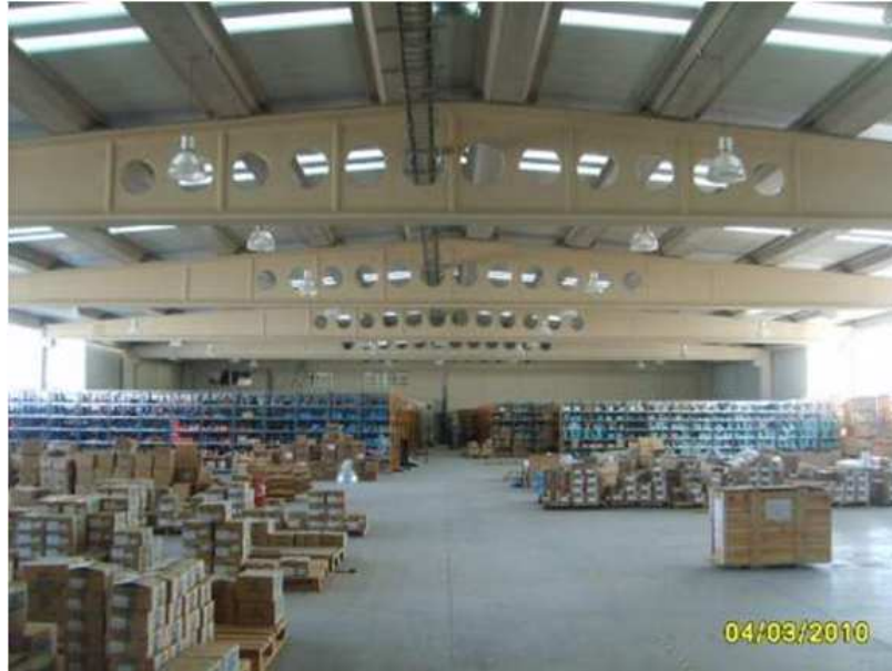
Figura 4.11: Vista general de la estructura
