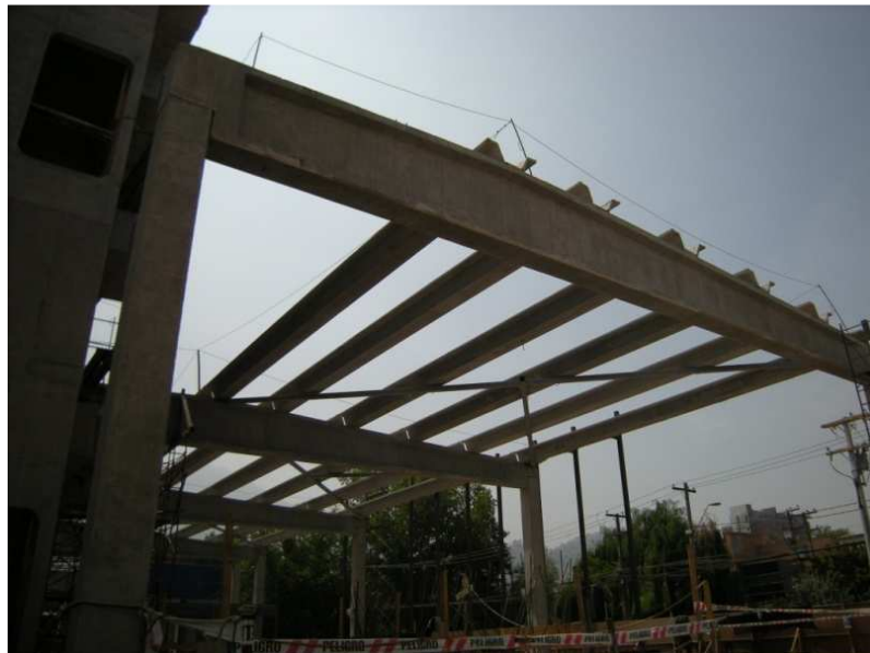
Figura 4.17: Vista general de la estructura
