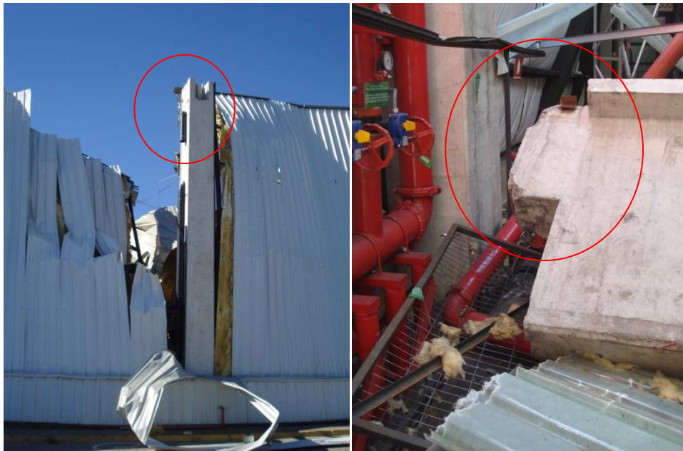
Figura 4.7: Colapso conexión seca pilar- viga principal
