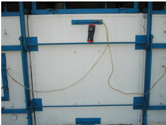
Figura 4.16: Manómetro de presión diferencial conectado antes y después del arreglo de cajas
