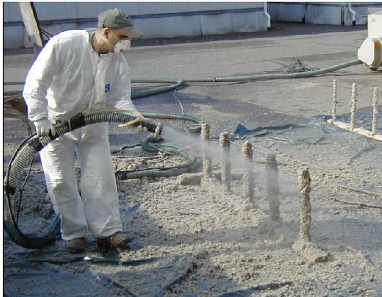
Figura 2.8: Aplicación del mortero BZII sobre una estructura de acero [15].
