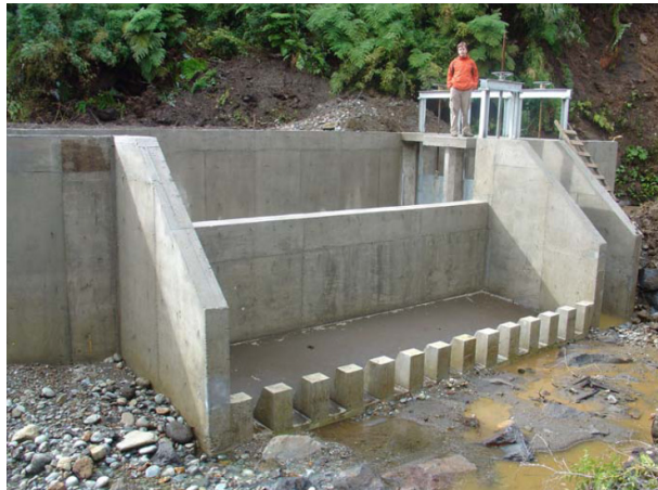
Figura 11. Desarenador con vertedero lateral y compuertas de control Fuente: DIA Mini Central Hidroeléctrica Cayucupil.
