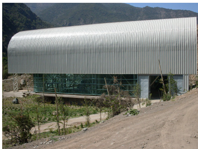
Figura 15. Casa de maquinas central Guayacán Fuente: Fotografía tomada durante visita a la central
