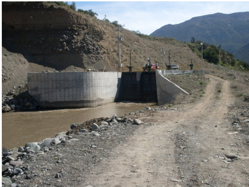
Figura 18. Obra de Toma
