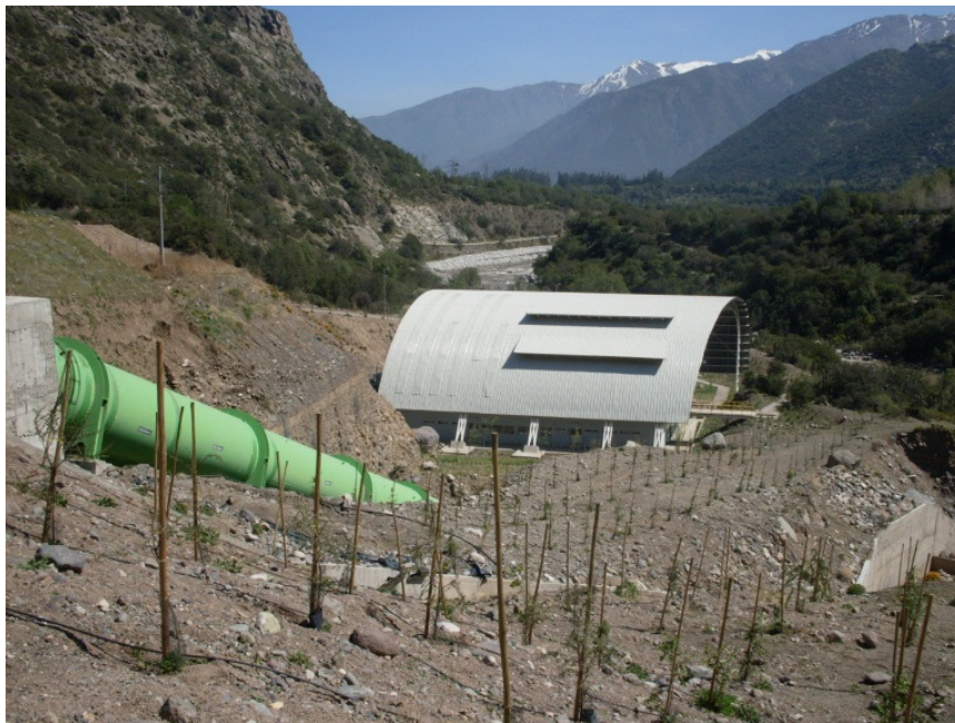
Figura 21. Tubería en Presión y Casa de Maquinas
