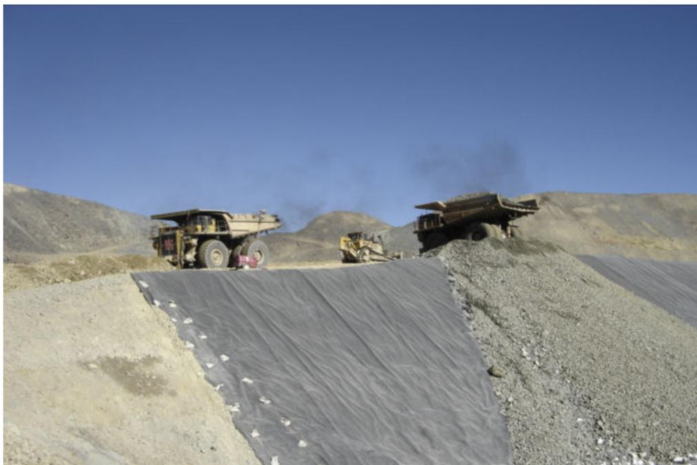
**Figura 1: Construcción de una pila [6]**
