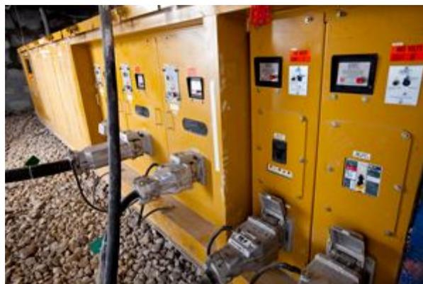
Figura 2.16: Acopladoras enchufables utilizados en la minería
