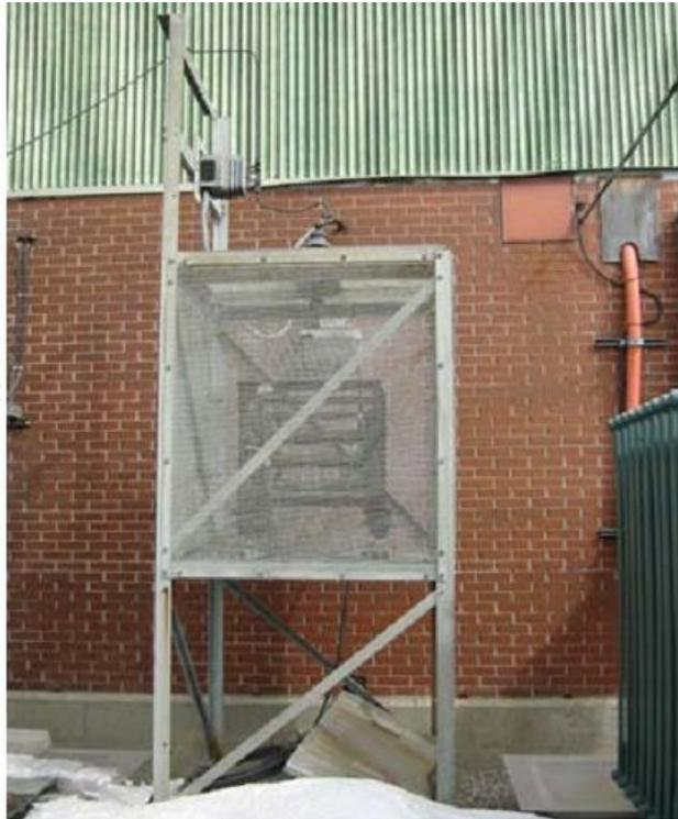
**Figura 5.4: NGR de intemperie cubierta por una malla metálica**
