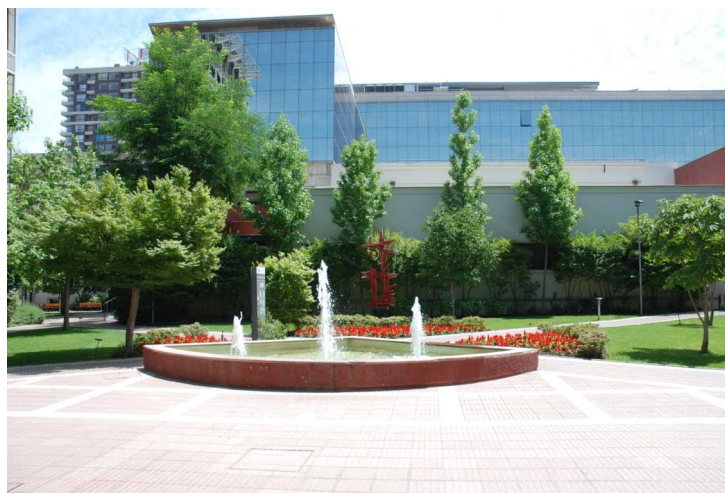
Figura 9: Fachada sur edificio Ingeniería Civil
