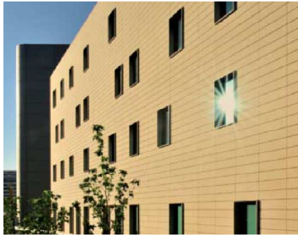
Figura 30: Edificio C4 Clínica Las Condes
