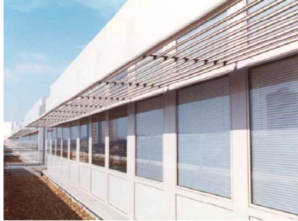
Figura 21: Parasol en el edificio Scottish Office, Edimburgo [9]
