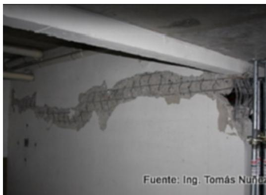
**Figura 4.4: Grieta horizontal con pérdida de material en muros. (Boroschek 2011)**
