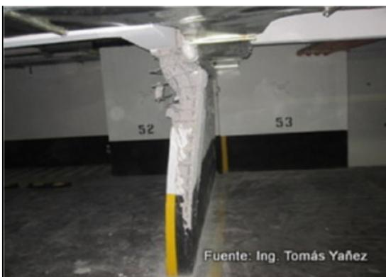
**Figura 4.5: Desaplome de muros. (Boroschek 2011)**
