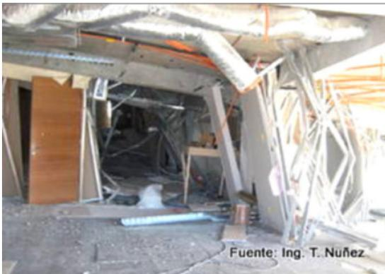
**Figura 4.1: Daño severo en elementos no estructurales. (Boroschek 2011)**
