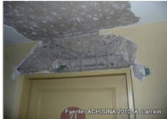
**Figura 4.2: Fallas de corte en dinteles. (Boroschek 2011)**
