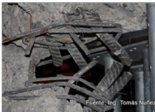
**Figura 4.6: Fractura en armadura longitudinal de muros. (Boroschek 2011)**
