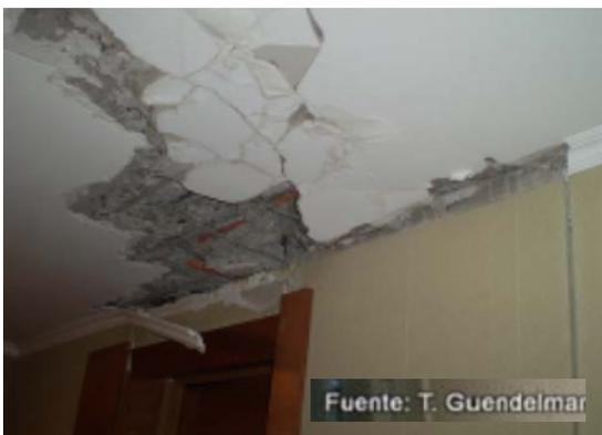
**Figura 4.3: Agrietamiento de losas. (Guendelman 2010)**
