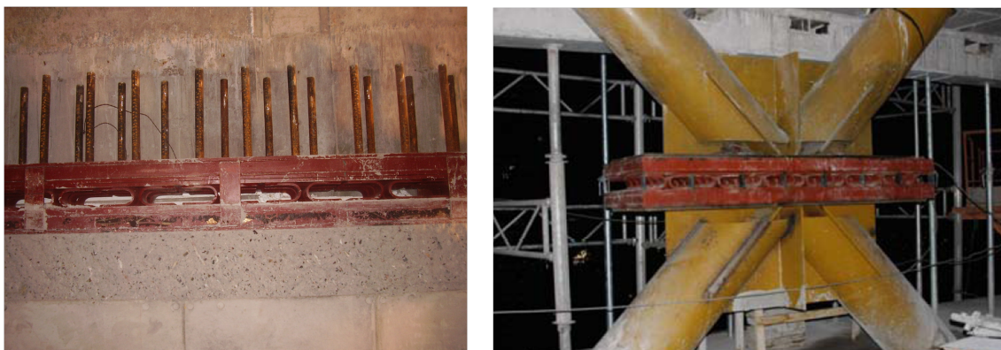
Figura 3.14: Disipadores Titanium (Izq.: Elementos Longitudinales; Der: Elementos Transversales) Nuñez (2009)
