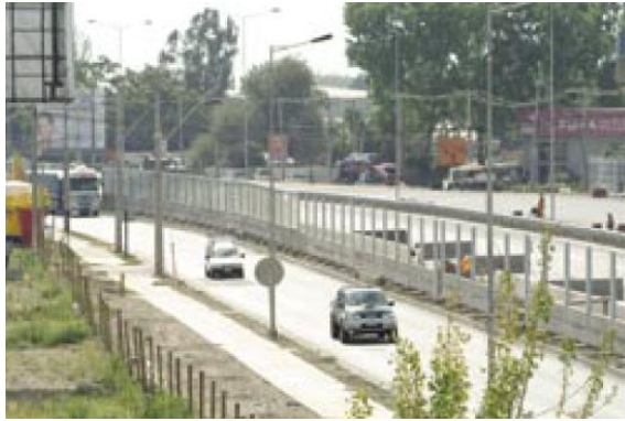
Figura n° 23: Barreras acústicas en Autopista Américo Vespucio Norte Express
