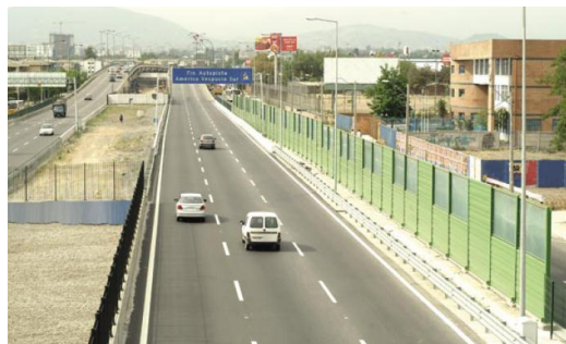
Figura n° 22: Barreras acústicas en Autopista Américo Vespucio Sur, sector Av. Grecia
