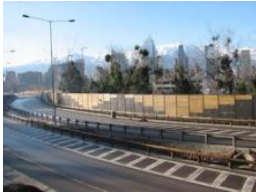
Figura n° 21: Barreras acústicas en Túnel San Cristobal, Pedro de Valdivia Norte
