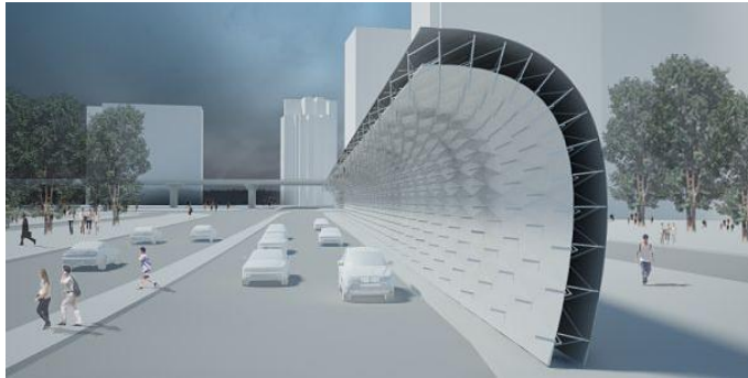
Figura n° 16: Barrera voladizo de 170 m de longitud y 6 m de altura.
