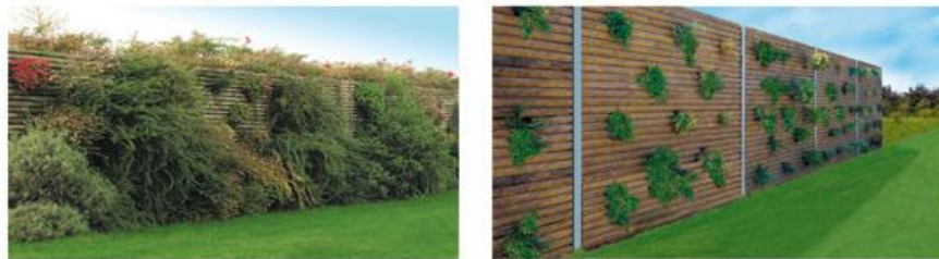
Figura nº 18: Barrera acústica de madera verde.
