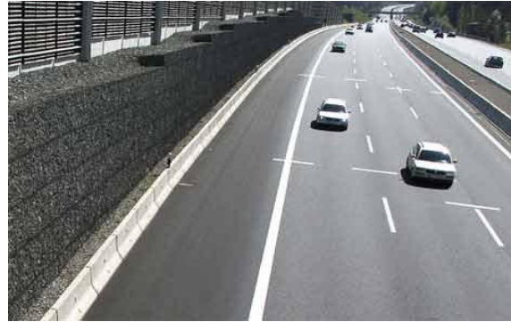
Figura nº 20: Gaviones Rothfuss como barreras acústicas
