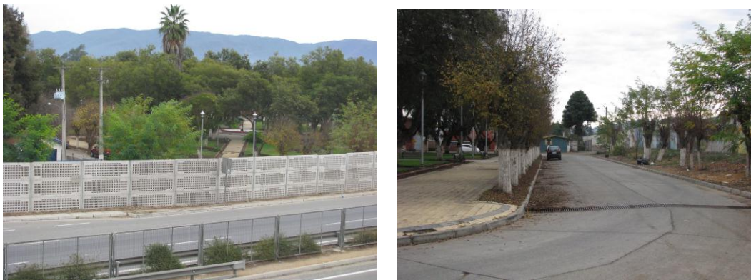
Figura n° 34: Toma de datos con sistema de barreras en Nogales, Ruta 5 Norte.
