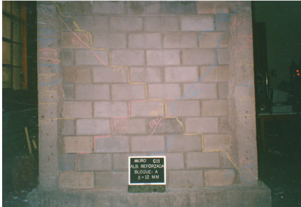
Figura E.30 Estado final del muro C11 (Muñoz, 1992)
