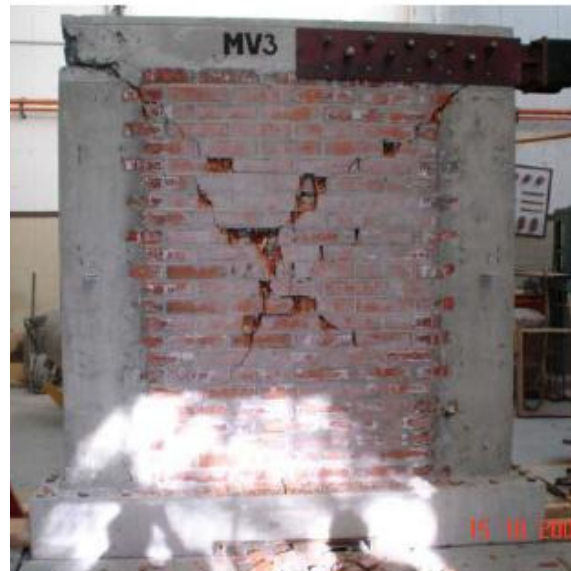
Figura E.36 Estado final de muro MV3 (Galleguillos y Valenzuela, 2009)
