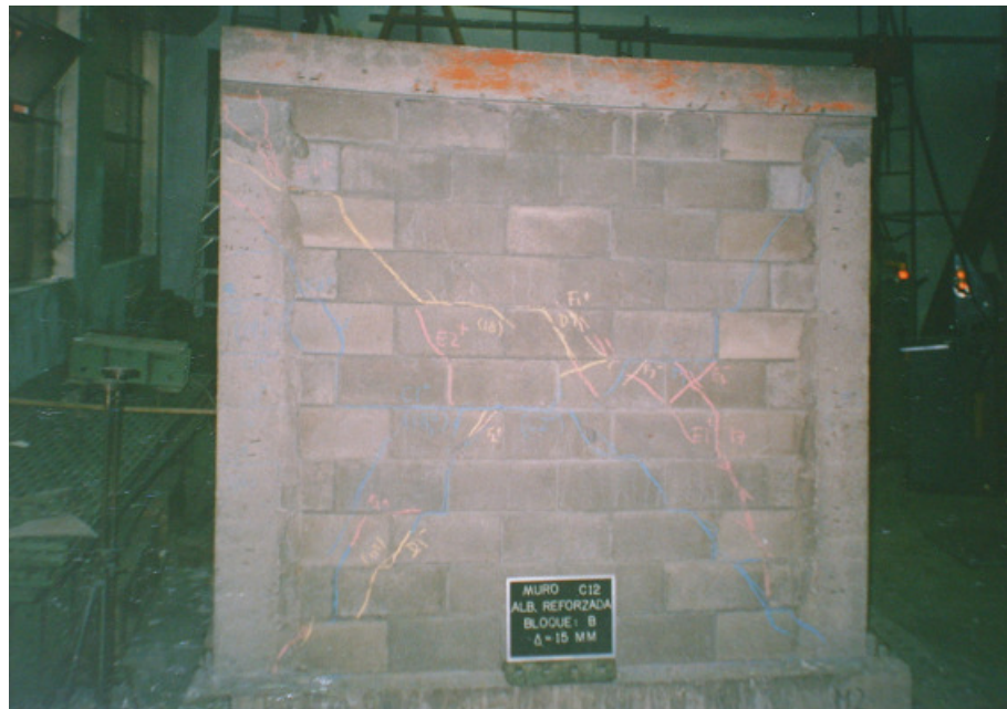
Figura E.32 Estado final del muro C12 (Muñoz, 1992)
