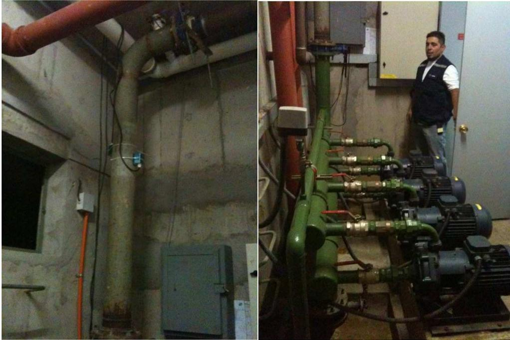
**Ilustración 31.** Instalación del fluxómetro.
