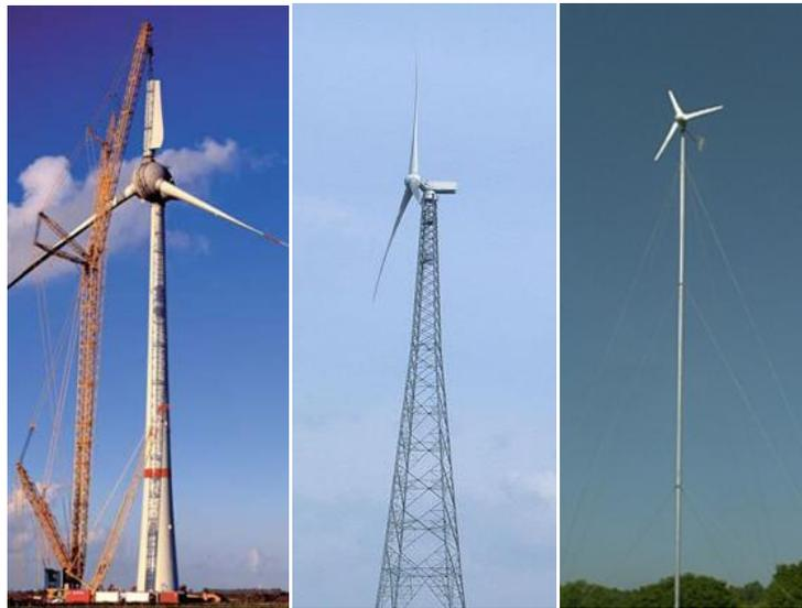
Figura 2.5: Tipo de torres, tubular (E-126), celosía y mástil tensado (de izquierda a derecha).
