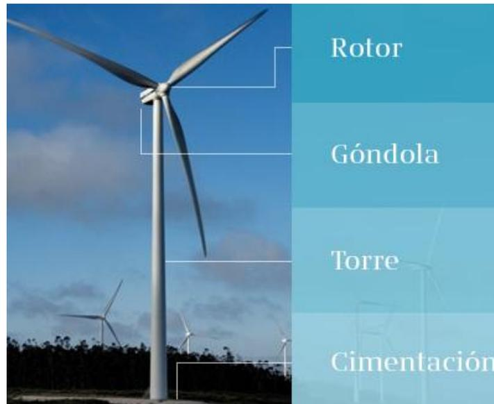
Figura 2.4: Partes de un generador eólico, [14].
