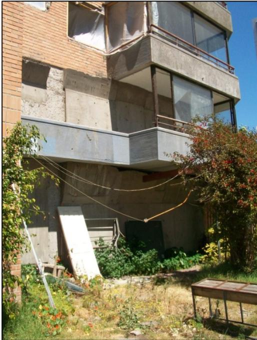
**Figura 7 Muros truncados rellenos con hormigón
