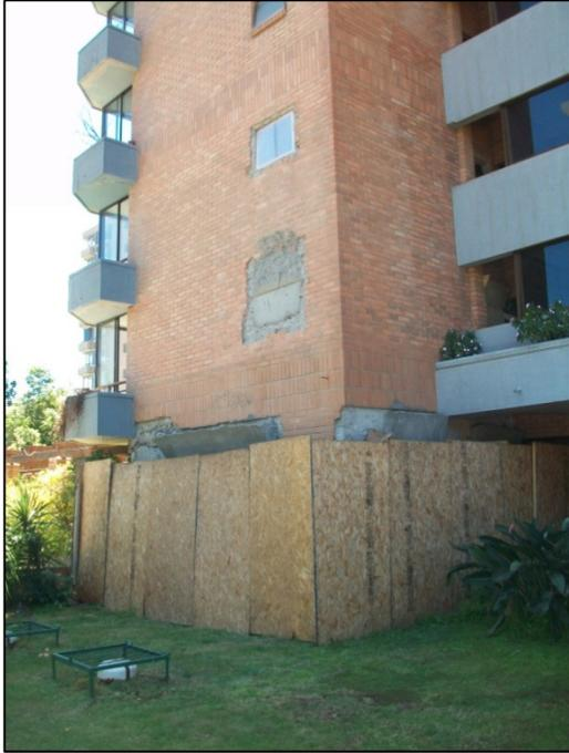
**Figura 5 Daños en Primer piso, a Nivel de Terreno.
