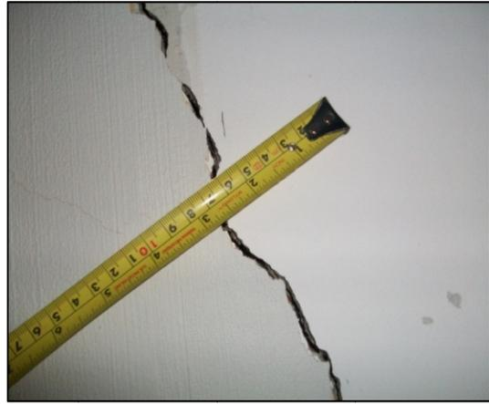
**Figura 10** Dimensionamiento de grietas en tabiques.
