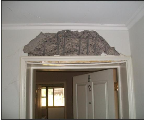
**Figura 11** Daño en dinteles.
