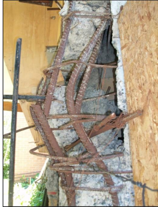
**Figura 6 Falla de barras longitudinales en pilar exterior
