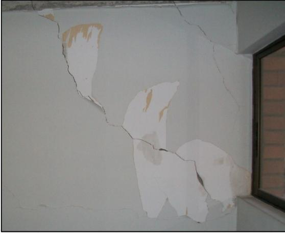
**Figura 9** Agrietamiento en Tabiquería Interior.
