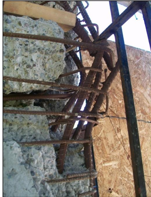
**Figura 8 Barras expuestas y completamente cortadas.
