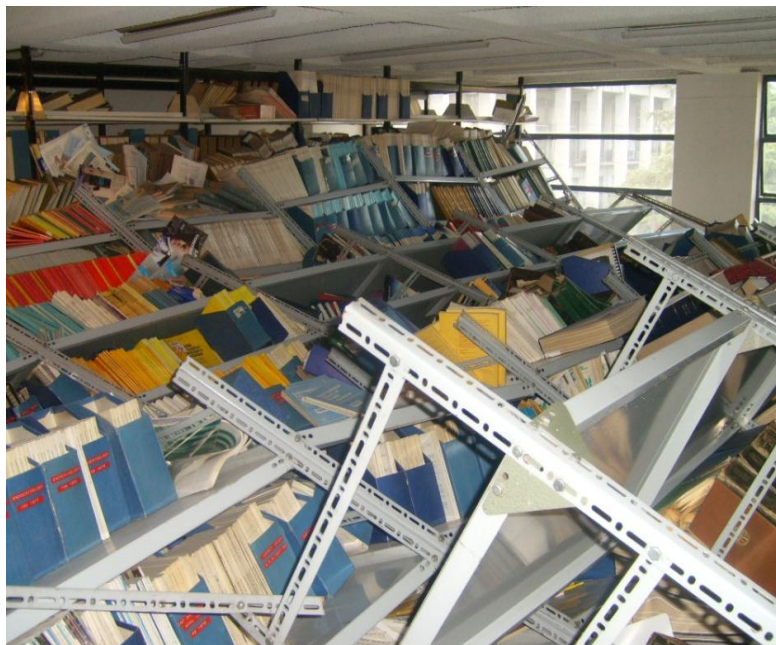
Figura7 Estanterías después del terremoto
