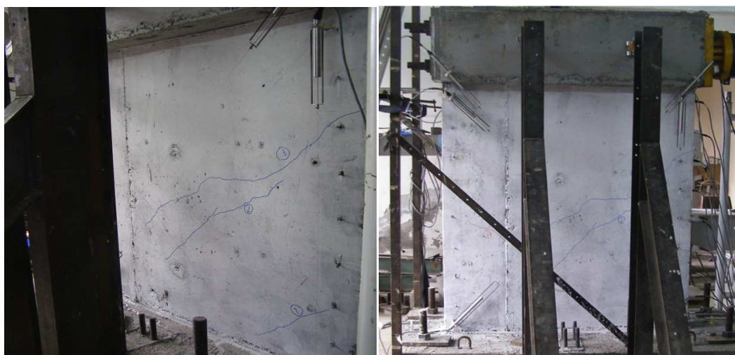
Figura 4.1 Aparición de primera grietas diagonales en muro SW-T6-S1-8 (Terzioğlu, 2011).
