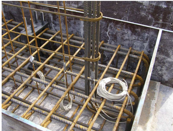
Figura 3.5 Instalación de sensores de deformación (Terzioğlu, 2011).
