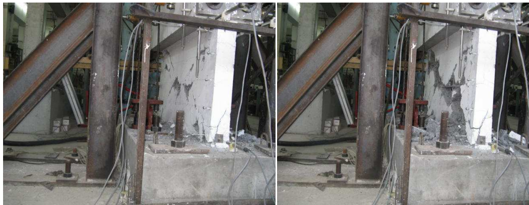
Figura 4.6 Daño moderado y severo en muro SW-T1-N5-S1-10 (Terzioğlu, 2011).
