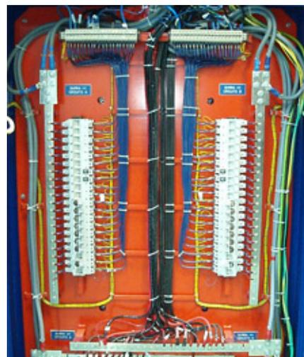
**Figura 37.:** Tablero de potencia (vista exterior e interior)
